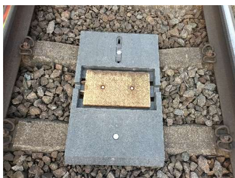
Obrázek 12 – Umístění nosiče balíz
