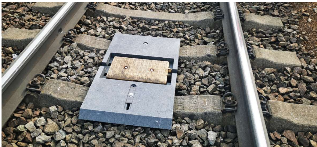
Obrázek 14 - Utažení nosiče
