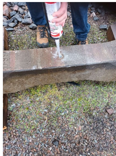
Obrázek 7 - Naplnění otvoru chemickou maltou
