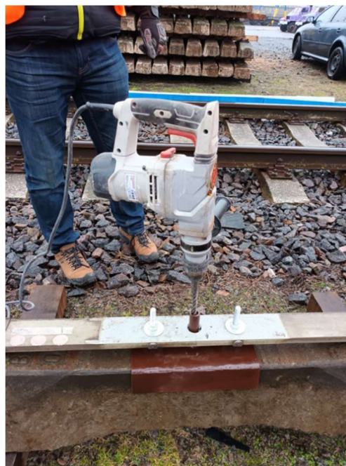
Obrázek 3 - Vrtání za použití přípravku
