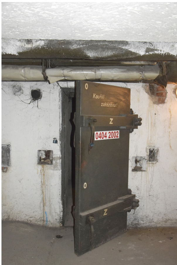
Pancéřované dveře krytu CO v suterénu pod hlavním křídlem. Pohled k Z.
