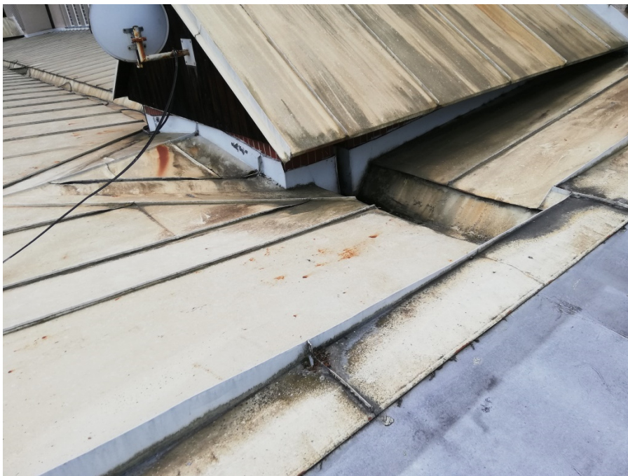
Stříška spočívá na původní plechové krytině
