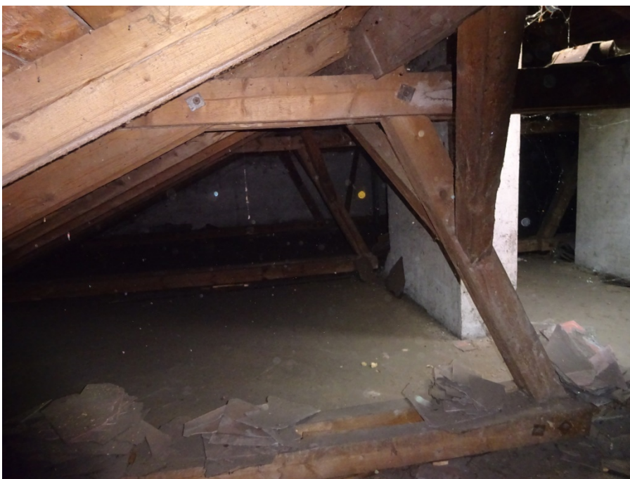
Zbytky azbestocementových šablon (původní krytiny)
