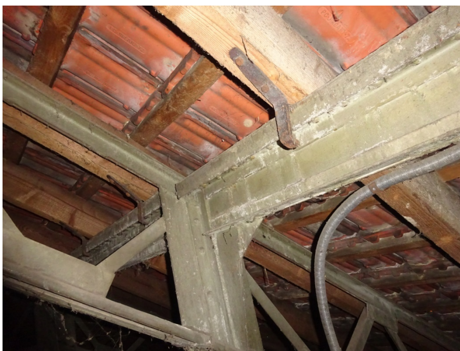
Kotvení dřevěných krokví k vaznicím
