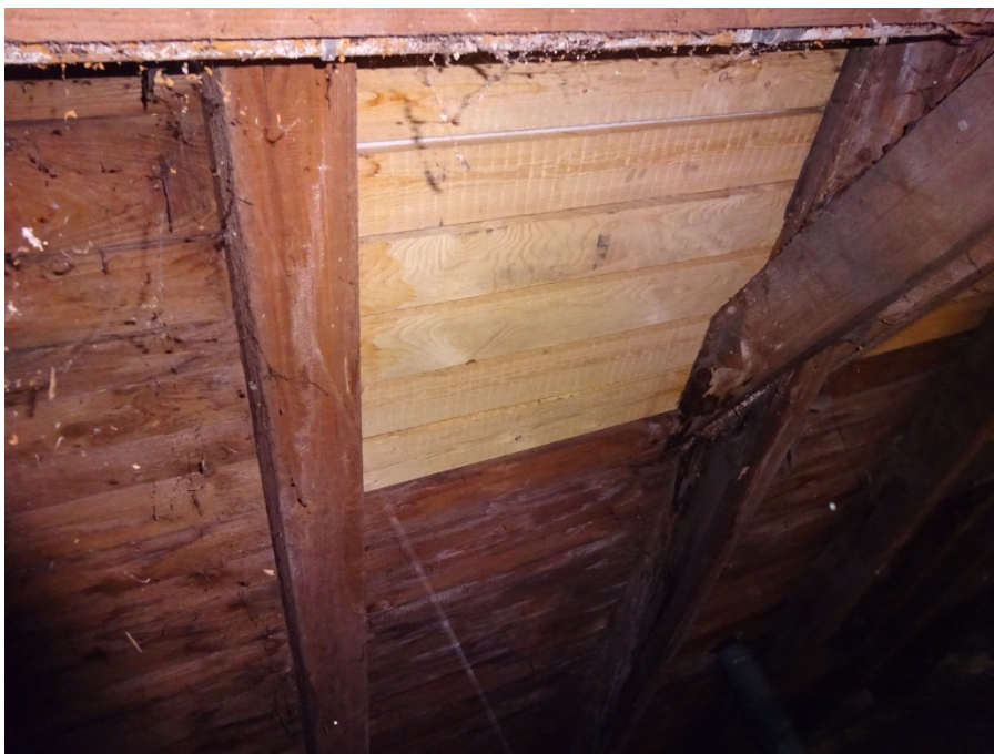
Vyměněná část střešního bednění
