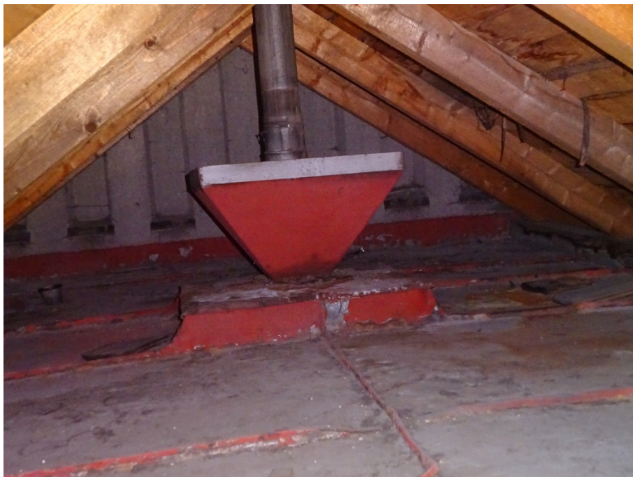
Původní úprava paty žerdi pod stříškou a plechová krytina
