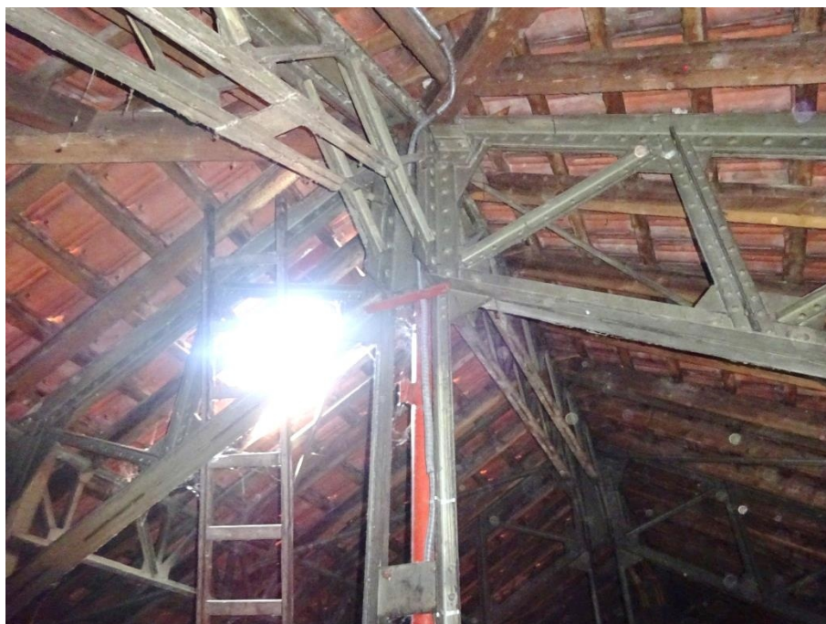
Styk ocelových krokví a vrcholové vaznice
