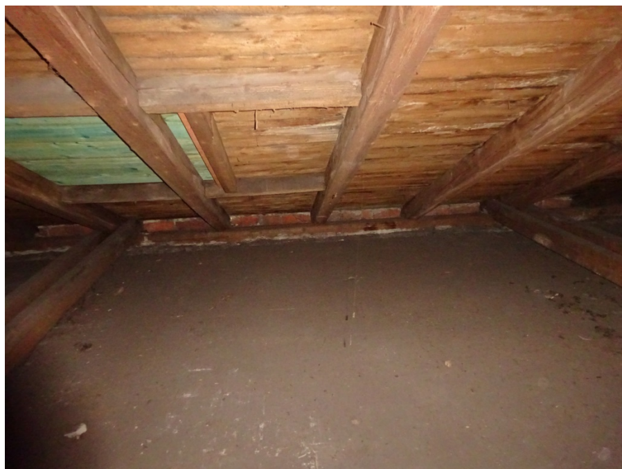
Vyměněná část střešního bednění ošetřená fungicidem
