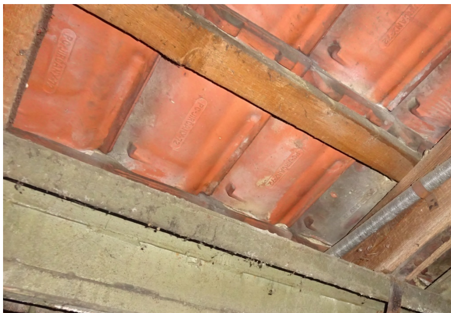
Pálená krytina na latích na vstupním křídle budovy
