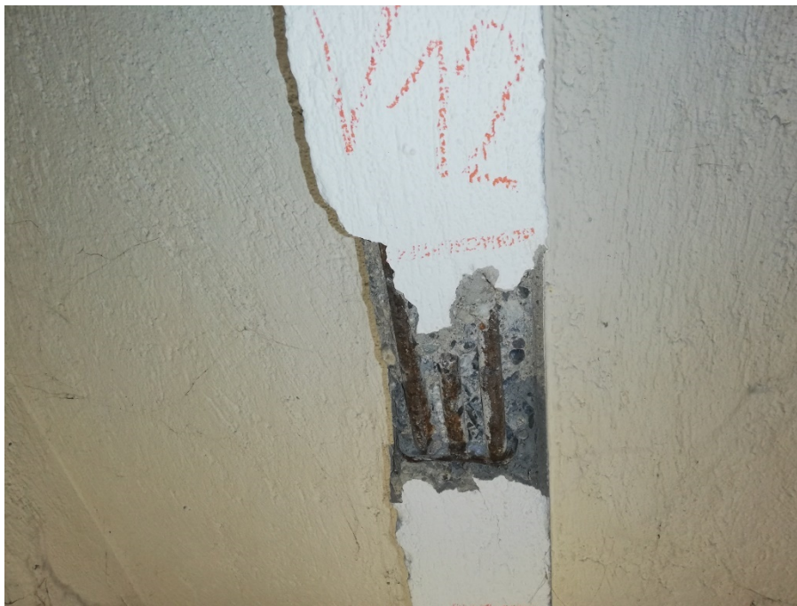
Sonda V12 k ověření výztuže (hladká ocel)
