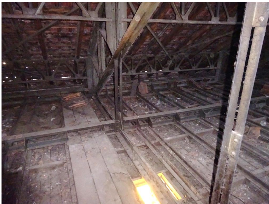
Příčná lávka ke stropnímu svítidlu
