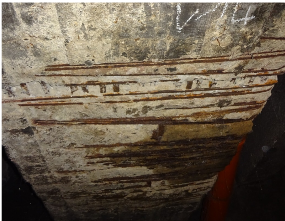
Sonda V14, významná koroze třmínek (ocel ROXOR)
