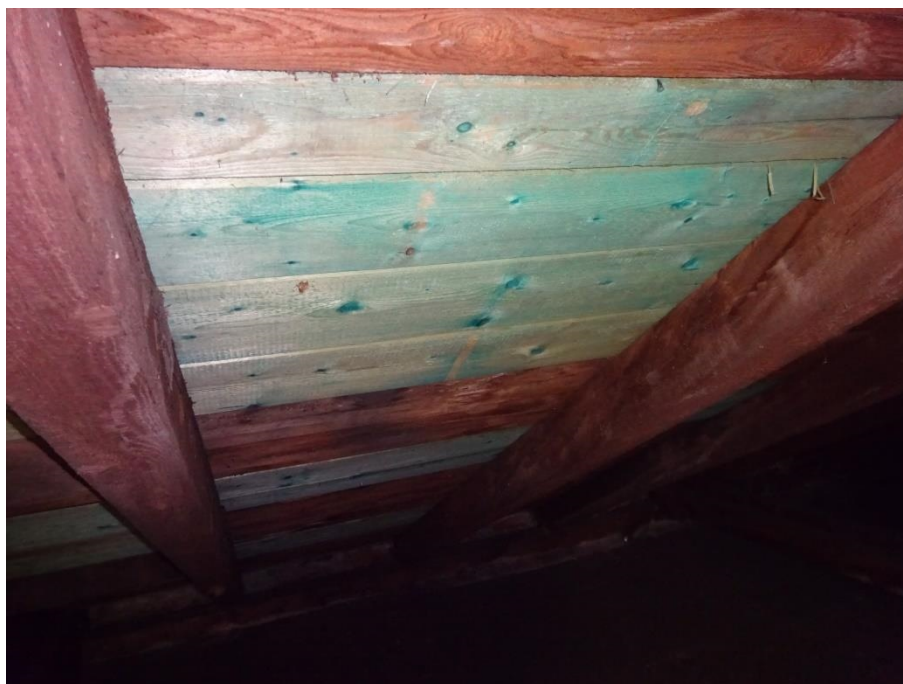
Vyměněná část střešního bednění
