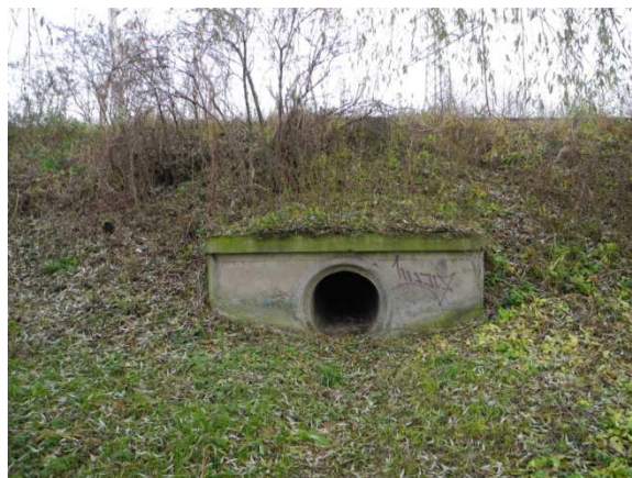
2-27,854 trubní propustek, Rooseveltovy sady
