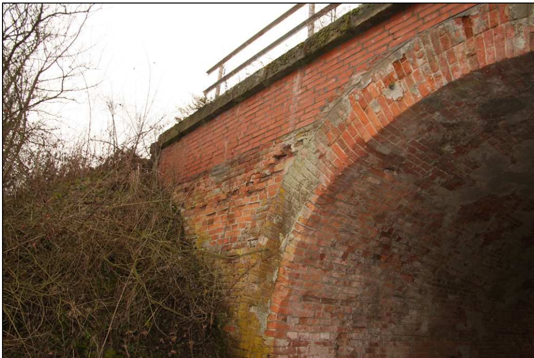
Obr. č. 3 – Pohled na pravé čelo znojemské opěry, viditelná trhlina cca 1,2m od čela probíhající od soklu až do vrcholu klenby, pod římsou je viditelné nové přezdění čela, níže je pak zdivo již značně zdegradované
