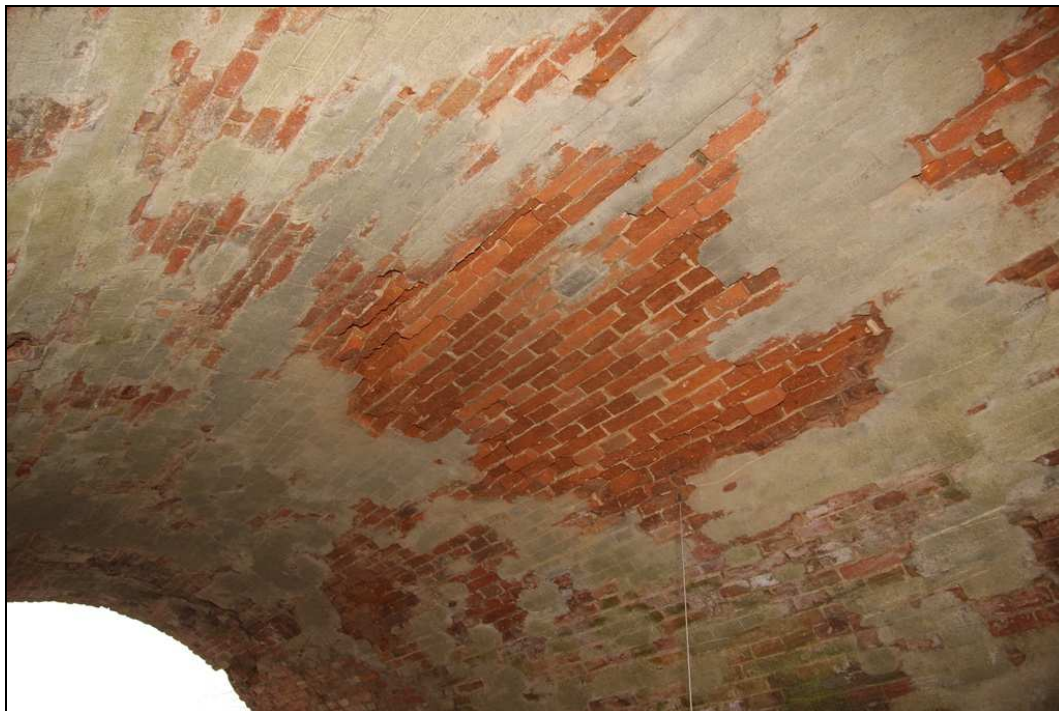
- Obr. č. 9 – pohled na NK klenby zasaženou degradací cihelného zdiva
