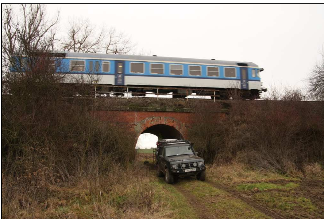
Obr. č. 2 – Pohled na pravé čelo mostu, pod římsovou je viditelné nové přezdění čela
