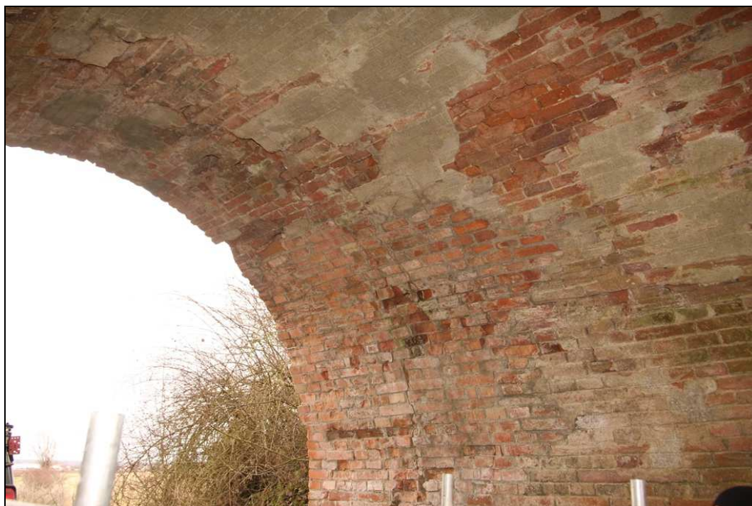
- Obr. č. 4 – Pohled na pravou část znojemské opěry, viditelná trhlina cca 1,2m od čela probíhající od soklu až do vrcholu klenby
