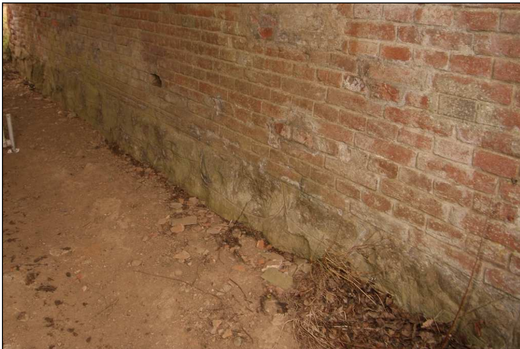
- Obr. č. 7 – pohled na opěru Moravské Budějovice na vyspravené spárování soklu
