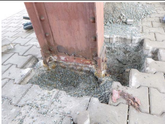
Obr. 142 – Pohled na patu sloupu N4/20: odhalená pata sloupu a viditelné výrazné korozní produkty
