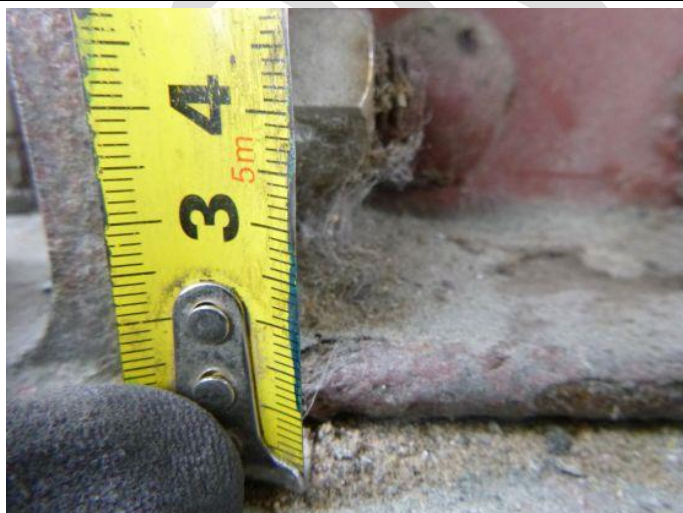
Obr. 167 – Pohled na patu sloupu N5/4B: počínající koroze šroubů a delaminace PKO
