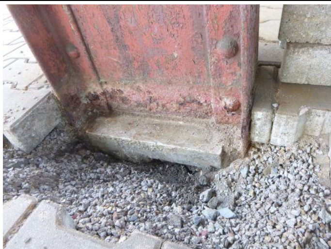
Obr. 119 – Pohled na sloup N3/24: vložená betonová kostka pod zámkovou dlažbou
