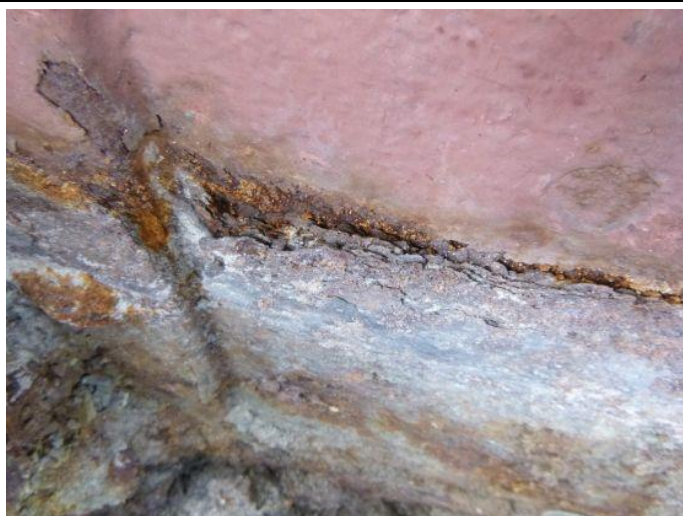
Obr. 48 – Pohled na patu sloupu N1/25: korozní produkty
