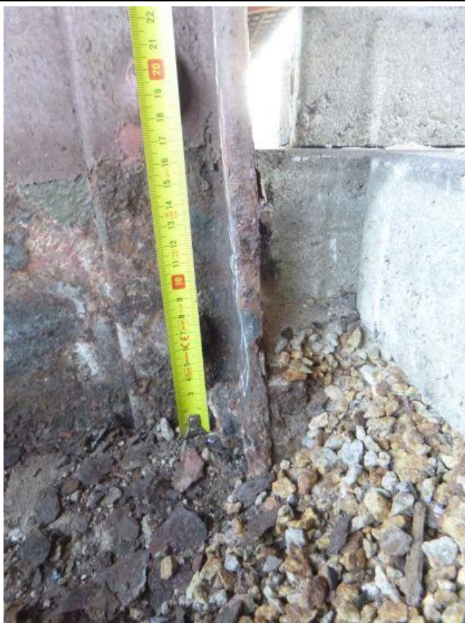
Obr. 90 – Pohled na sloup N2/5: zabetonování paty sloupu je v hloubce cca 160 mm pod chodníkovou úrovní
