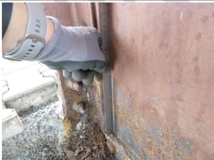
Obr. 144 – Pohled na patu sloupu N4/20: korozní oslabení stojny sloupu
