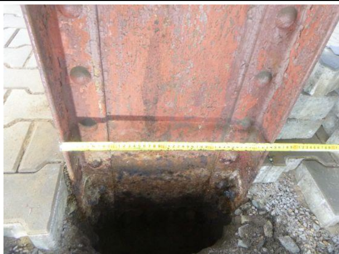
Obr. 122 – Pohled na patu sloupu N3/24: vnější rozteč mezi bočnicemi – cca 446 mm
