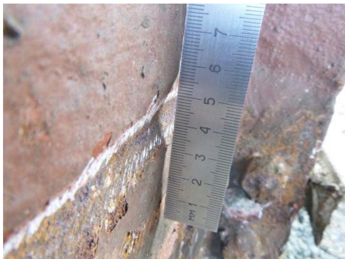
Obr. 134 – Pohled na patu sloupu N4/13: korozní poškození stojny sloupu
