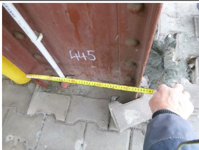
Obr. 160 – Pohled na patu sloupu N5/3: vnější rozteč mezi bočnicemi – cca 445 mm
