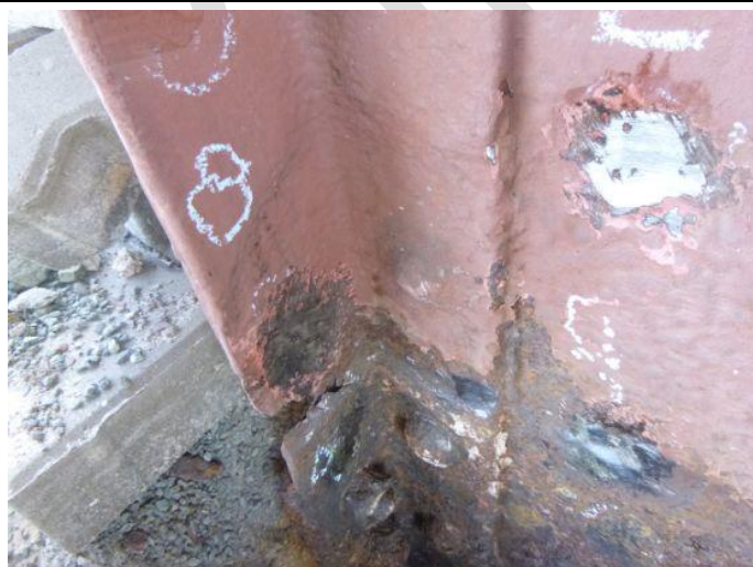
Obr. 80 – Pohled na patu sloupu N1/52: prokorodovaná bočnice
