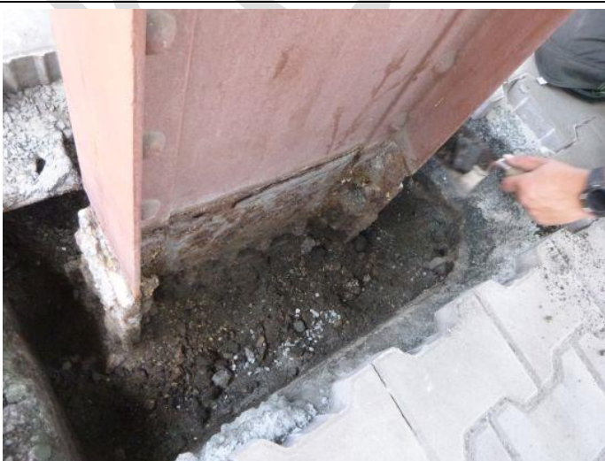
Obr. 47 – Pohled na patu sloupu NI/25: po odhalení paty sloupu je viditelný nárůst korozních produktů
