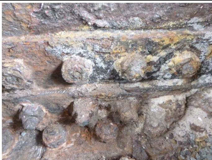
Obr. 130 – Pohled na patu sloupu N4/13: korozní poškození šroubů
