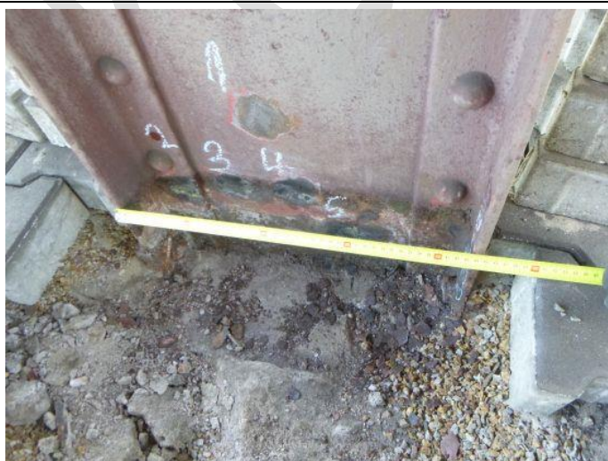
Obr. 89 – Pohled na patu sloupu N2/5: vnější rozteč mezi bočnicemi – cca 447 mm
