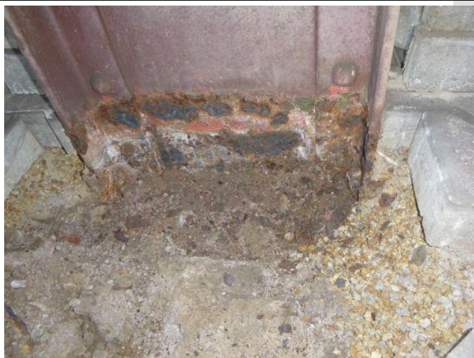
Obr. 85 – Pohled na patu sloupu N2/5: lokální očištění od korozních produktů
