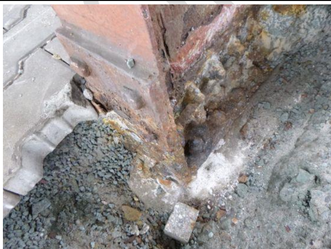
Obr. 141 – Pohled na patu sloupu N4/20: odhalená pata sloupu
