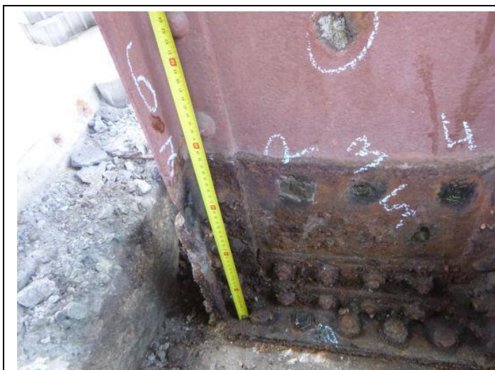
Obr. 57 – Pohled na patu sloupu N1/25: hloubka sloupu pod chodníkovou úrovní je cca 345 mm
