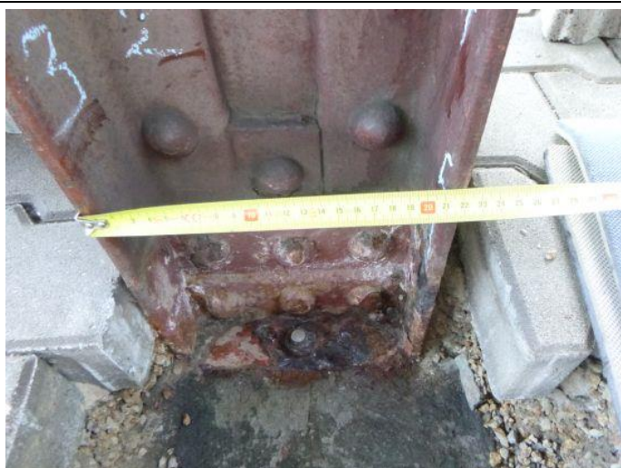
Obr. 99 – Pohled na patu sloupu N2/25A: vnější rozteč mezi bočnicemi – cca 222 mm
