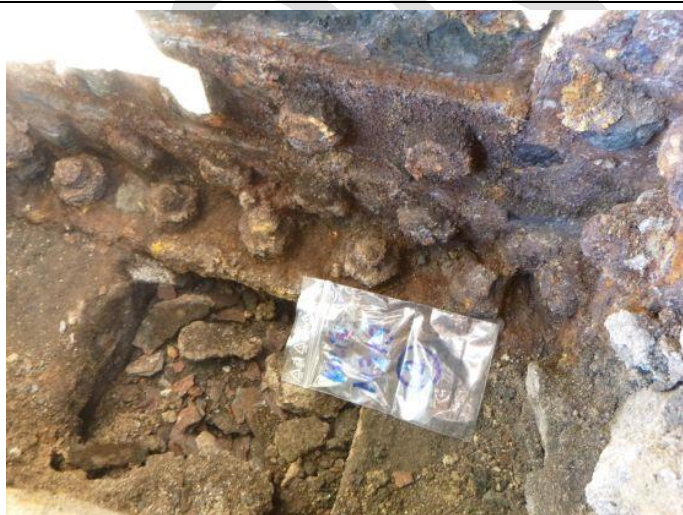
Obr. 109 – Pohled na patu sloupu N3/3: přítomnost betonových bloků pro ukotvení sloupu je pouze po stranách!
