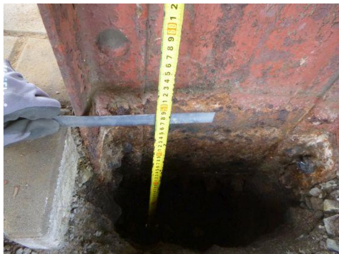
Obr. 123 – Pohled na patu sloupu N3/24: hloubka ukotvení pod chodníkovou úroveň je cca 470 mm
