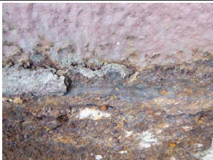
Obr. 72 – Pohled na sloup N1/52: korozní produkty na stejné sloupu; pod nátěrem viditelné dřívější poškození důlkovou korozi
