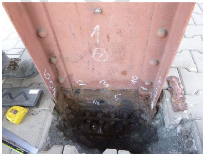
Obr. 64 – Pohled na patu sloupu N1/26: místa měření
