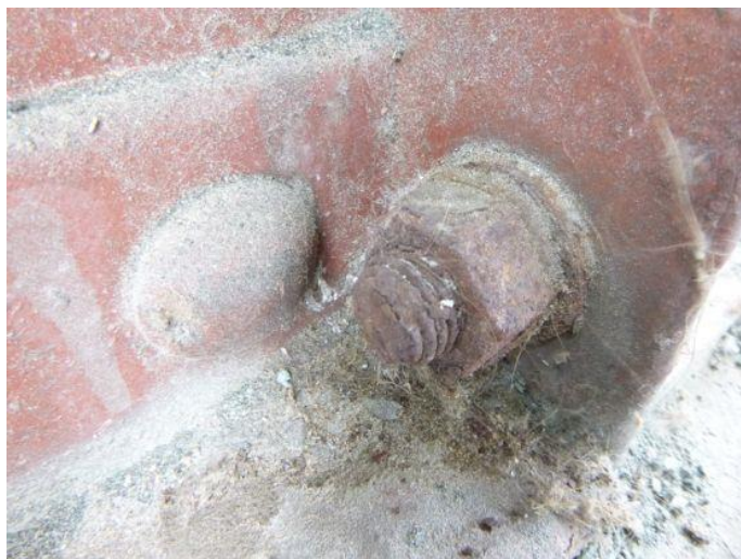
Obr. 169 – Pohled na patu sloupu N5/4B: počínající koroze šroubů
