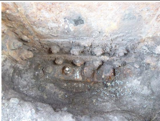
Obr. 65 – Pohled na patu sloupu N1/26: pohled na ukotvení paty sloupu
