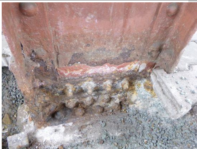
Obr. 140 – Pohled na patu sloupu N4/20: odhalená pata sloupu
