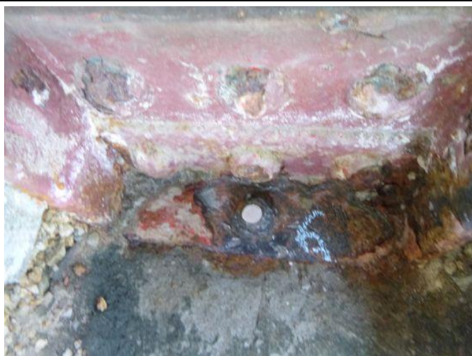
Obr. 98 – Pohled na sloup N2/25A: koroze kotevního šroubu (měření délky pomocí PAUT)
