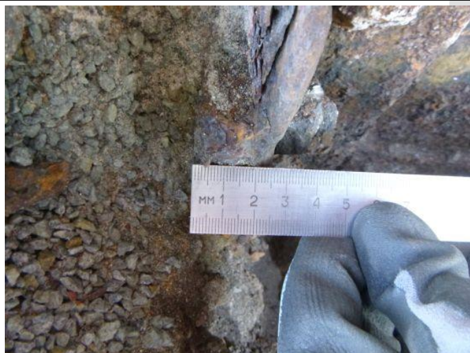
Obr. 79 – Pohled na patu sloupu N1/52: ztužení bočnice paty sloupu
