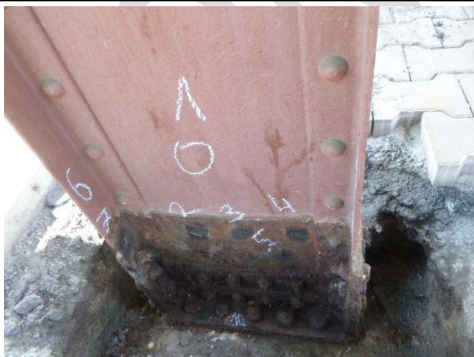
Obr. 50 – Pohled na patu sloupu N1/25: místa měření zbytkových tloušťek nebo korozních úbytků
