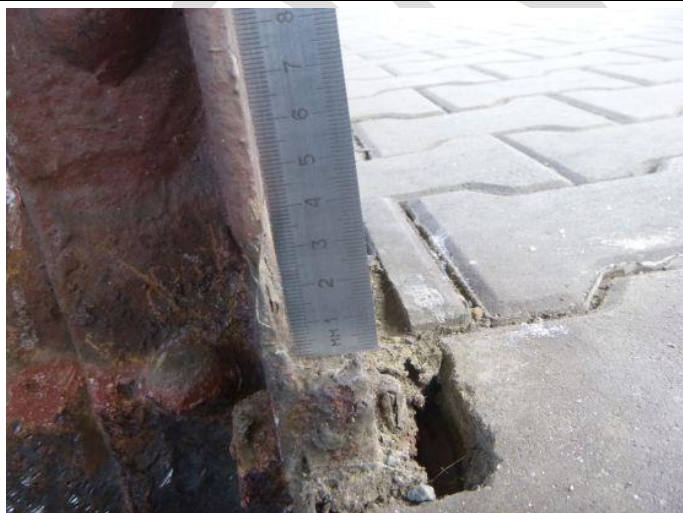
Obr. 135 – Pohled na patu sloupu N4/13: korozní poškození bočnice sloupu
