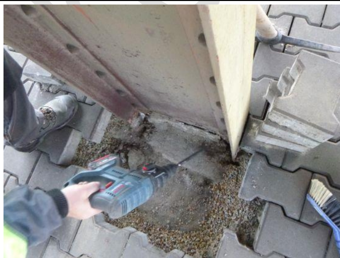
Obr. 83 – Pohled na patu sloupu N2/5: zabetonovaná pata sloupu
