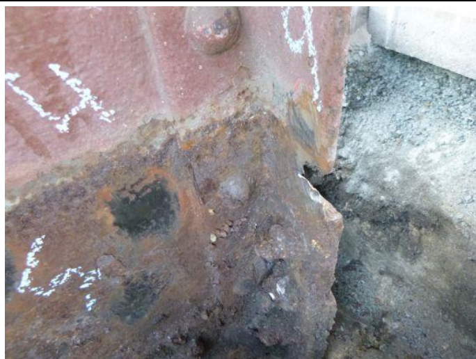
Obr. 51 – Pohled na patu sloupu N1/25: prokorodovaná bočnice
