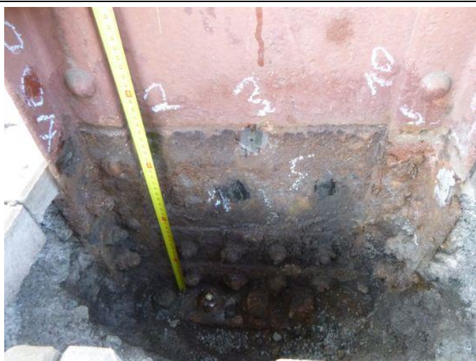
Obr. 66 – Pohled na patu sloupu N1/26: korozní poškození dosahuje až do výšky 335 mm od spodní desky
