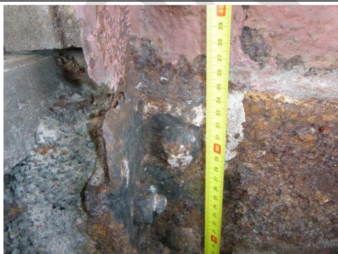
Obr. 74 – Pohled na patu sloupu N1/52: prokorodovaná bočnice a koroze šroubů a hlav nýtů
