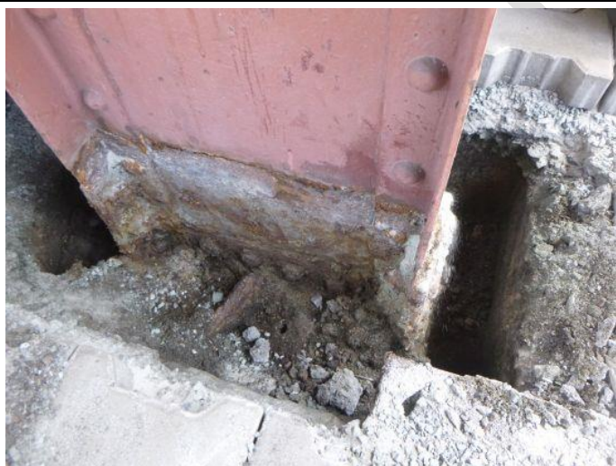
Obr. 46 – Pohled na patu sloupu NI/25: po odhalení paty sloupu je viditelný nárůst korozních produktů
