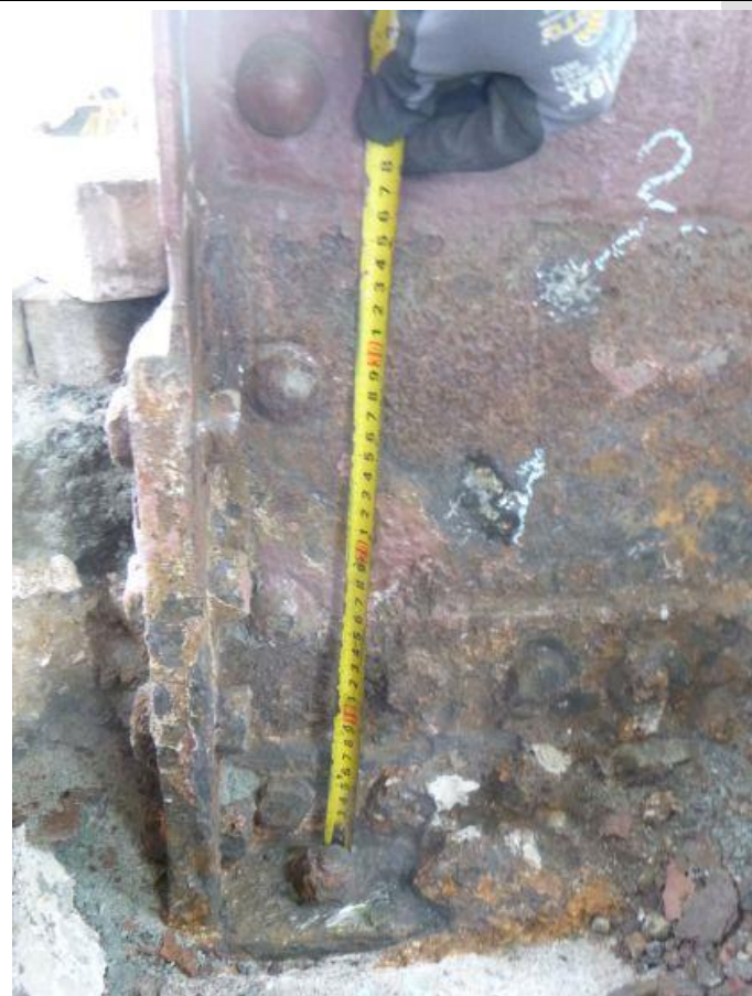
Obr. 161 – Pohled na patu sloupu N5/3: hloubka ukotvení pod chodníkovou úroveň je cca 370 mm
