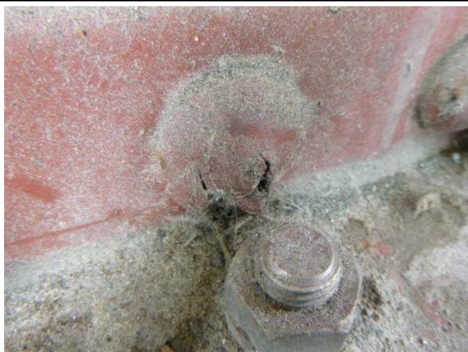
Obr. 168 – Pohled na patu sloupu N5/4B: delaminace PKO
