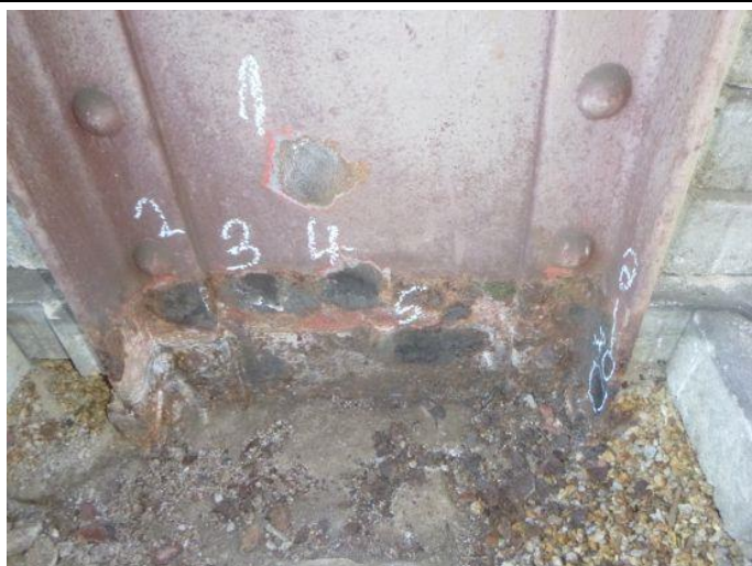
Obr. 87 – Pohled na sloup N2/5: místa měření
