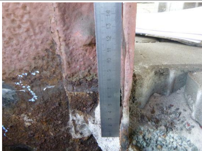
Obr. 78 – Pohled na patu sloupu N1/52: korozní oslabení bočnice sloupu
