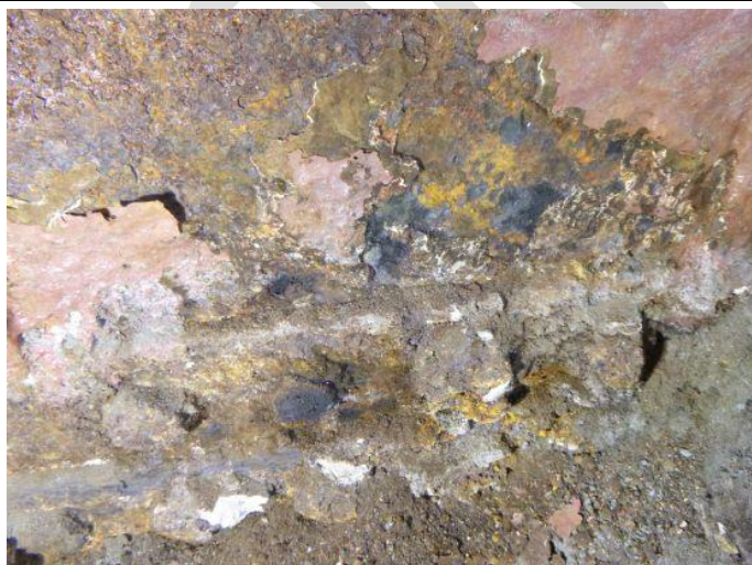
Obr. 153 – Pohled na patu sloupu N5/3: vrstva korozních produktů
