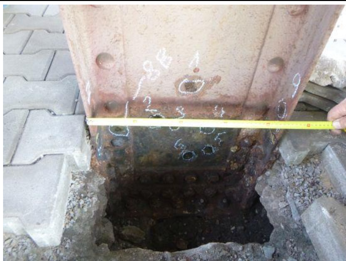
Obr. 113 – Pohled na sloup N3/3: místa měření; vnější rozteč mezi bočnicemi – cca 447 mm
