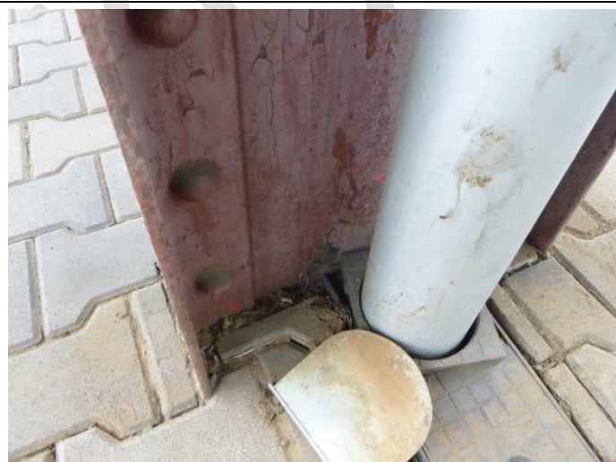
Obr. 118 – Pohled na patu sloupu N3/24: odvodňovač
