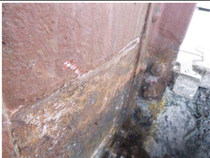
Obr. 133 – Pohled na patu sloupu N4/13: korozní poškození stojny, bočnice a šroubů
