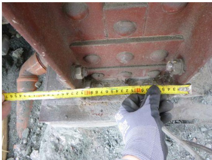
Obr. 166 – Pohled na patu sloupu N5/4B: vnější rozteč mezi bočnicemi se ztužením – cca 240 mm
