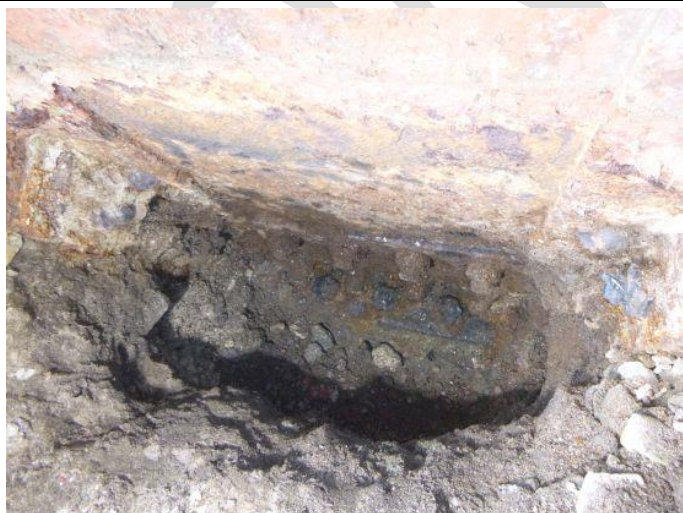
Obr. 121 – Pohled na patu sloupu N3/24: pata sloupu – po vyjmutí betonové kostky
