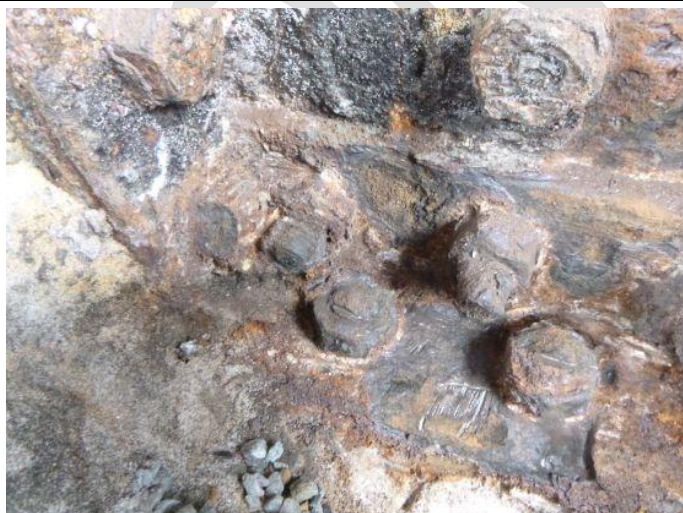
Obr. 132 – Pohled na patu sloupu N4/13: korozní poškození šroubů
