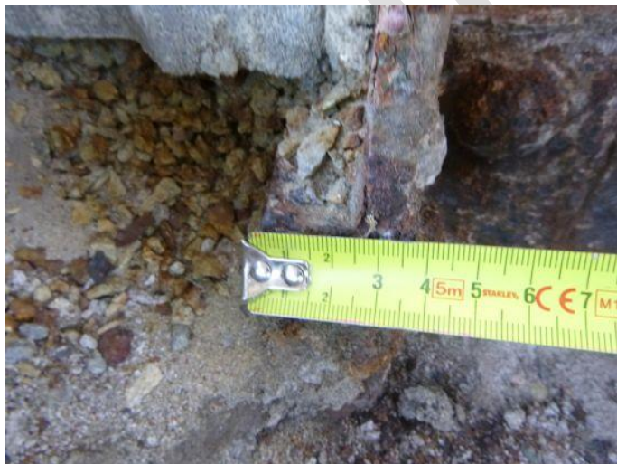
Obr. 91 – Pohled na patu sloupu N2/5: ztužení bočnice paty sloupu
