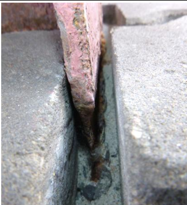
Obr. 44 – Obr. 45 – Pohled na patu sloupu NI/25: při detailním pohledu je viditelné korozní poškození u úrovni zámkové dlažby
