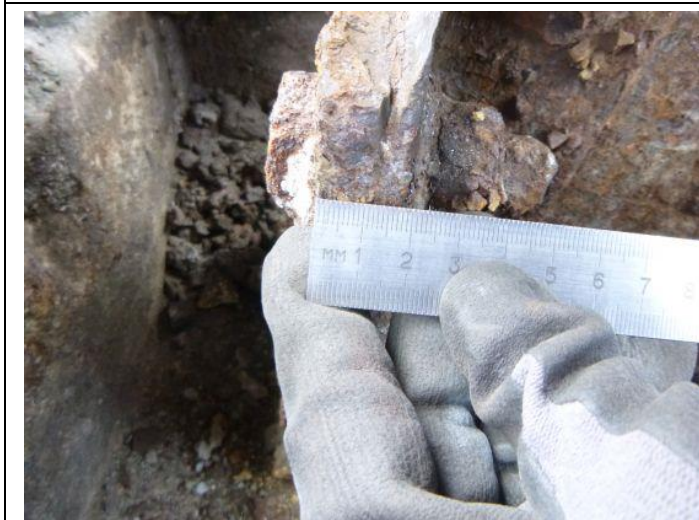
Obr. 58 – Pohled na patu sloupu N1/25: bočnice a přidavné ztužení, zkorodovaný šroub
