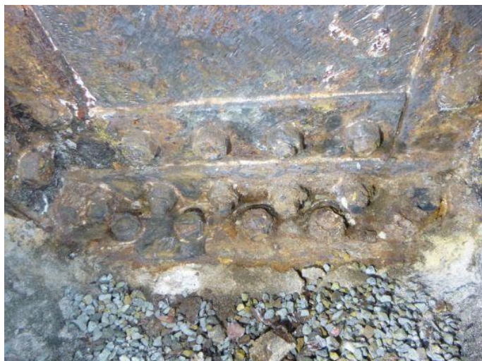
Obr. 131 – Pohled na patu sloupu N4/13: korozní poškození šroubů
