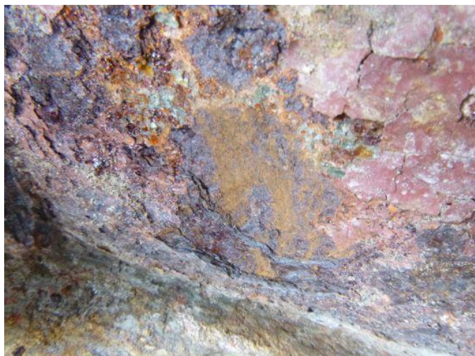
Obr. 120 – Pohled na patu sloupu N3/24: korozní produkty na stejné sloupu
