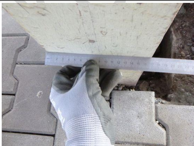
Obr. 115 – Pohled na patu sloupu N3/3: šířka bočnice 170 mm
