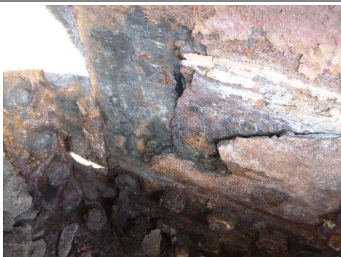
Obr. 108 – Pohled na patu sloupu N3/3: silná vrstva korozních produktů na stejné sloupu
