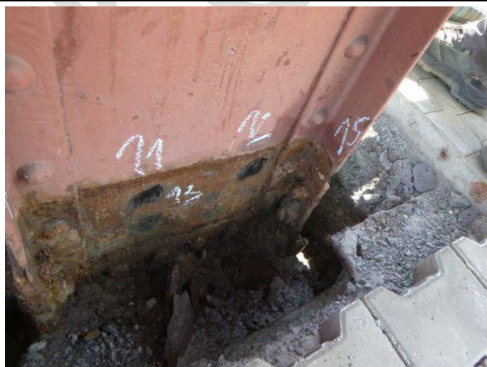
Obr. 53 – Pohled na patu sloupu N1/25: místa měření zbytkových tloušťek nebo korozních úbytků
