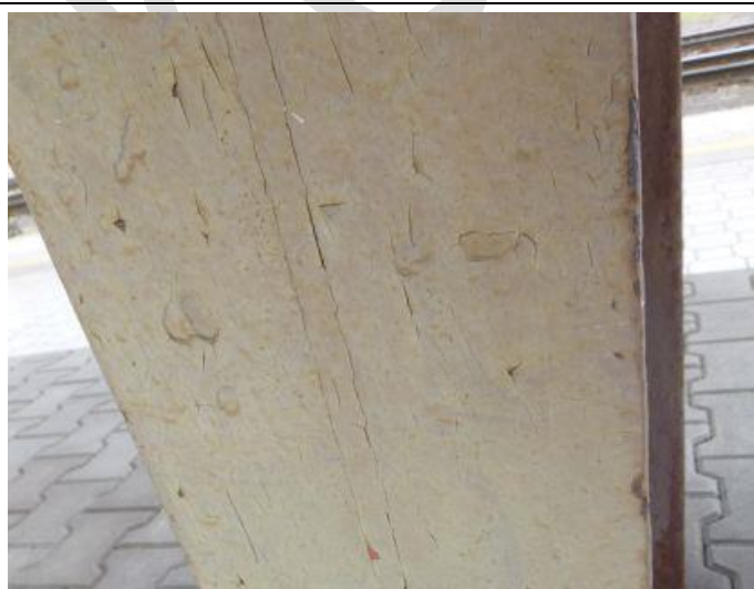
Obr. 103 – Pohled na sloup N3/3: degradace nátěrového systému
