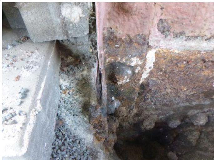
Obr. 73 – Pohled na patu sloupu N1/52: zeslabení bočnice vlivem koroze
