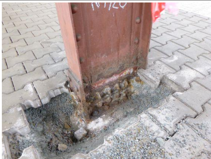
Obr. 139 – Pohled na patu sloupu N4/20: odhalená pata sloupu
