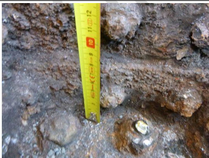
Obr. 67 – Pohled na patu sloupu N1/26: koroze kotevních šroubů
