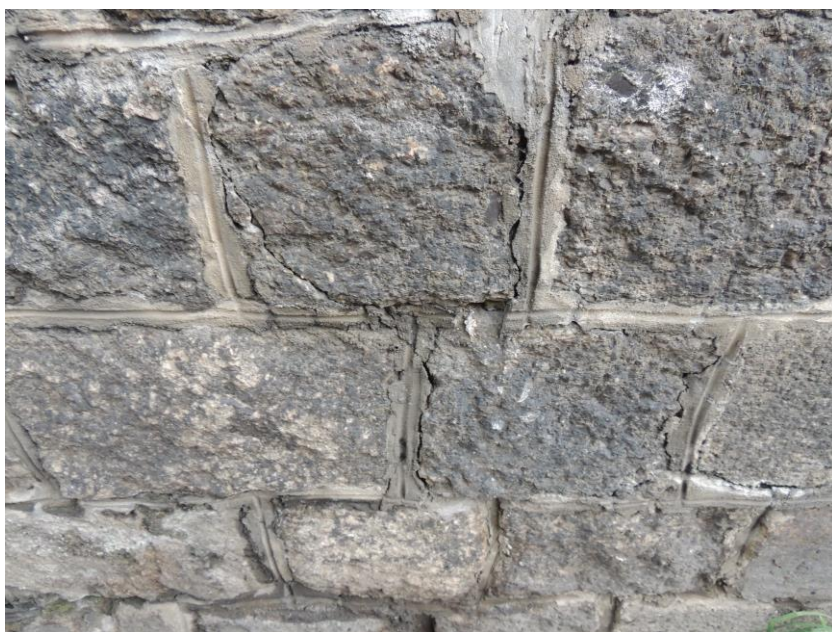
Trhliny v přespárování stykových spár kamenného zdiva
