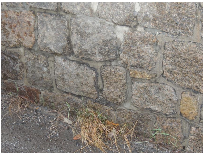
Viditelně obnovené spárování stykových spár kamenného zdiva
