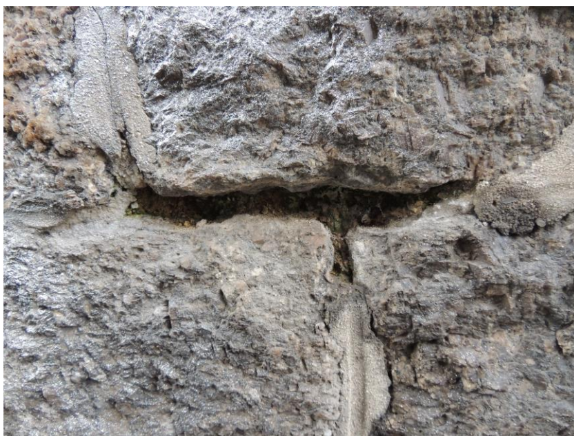
Vydrolení obnovy spárování stykové spáry
