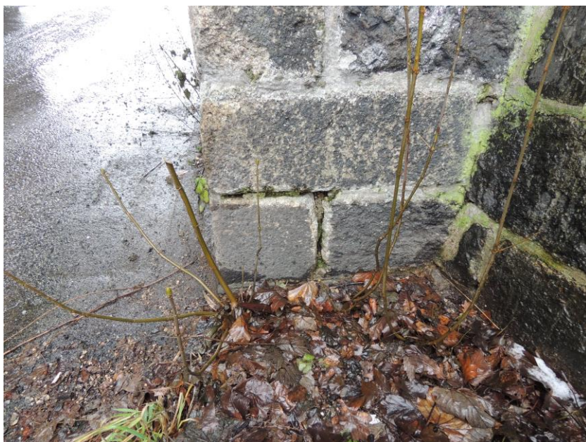
Vydrolené přespárování stykové spáry zdiva severní opěry
