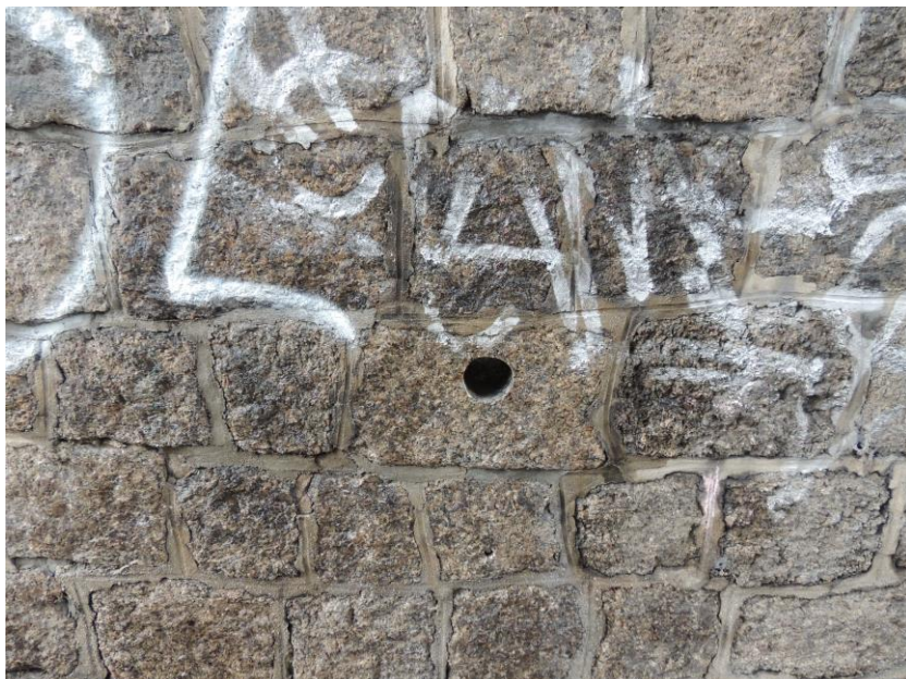
Místo odběru zkušebního vzorku pro stanovení pevnosti kamene zdiva severní opěry
