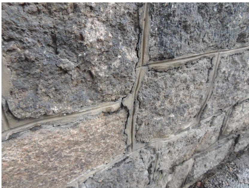
Trhliny v přespárování stykových spár kamenného zdiva
