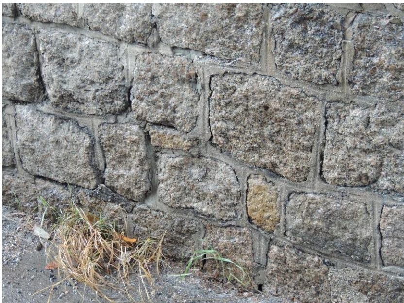
Trhliny v přespárování stykových spár kamenného zdiva
