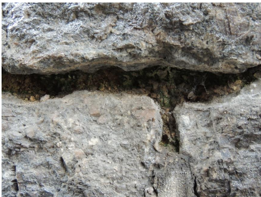
Detail hloubky vydrolení obnoveného spárování kamenného zdiva
