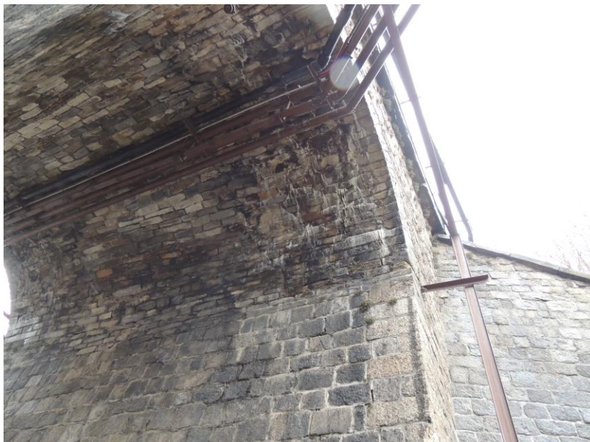
Viditelné vápenné výluhy ze stykových spár zdiva klenby
