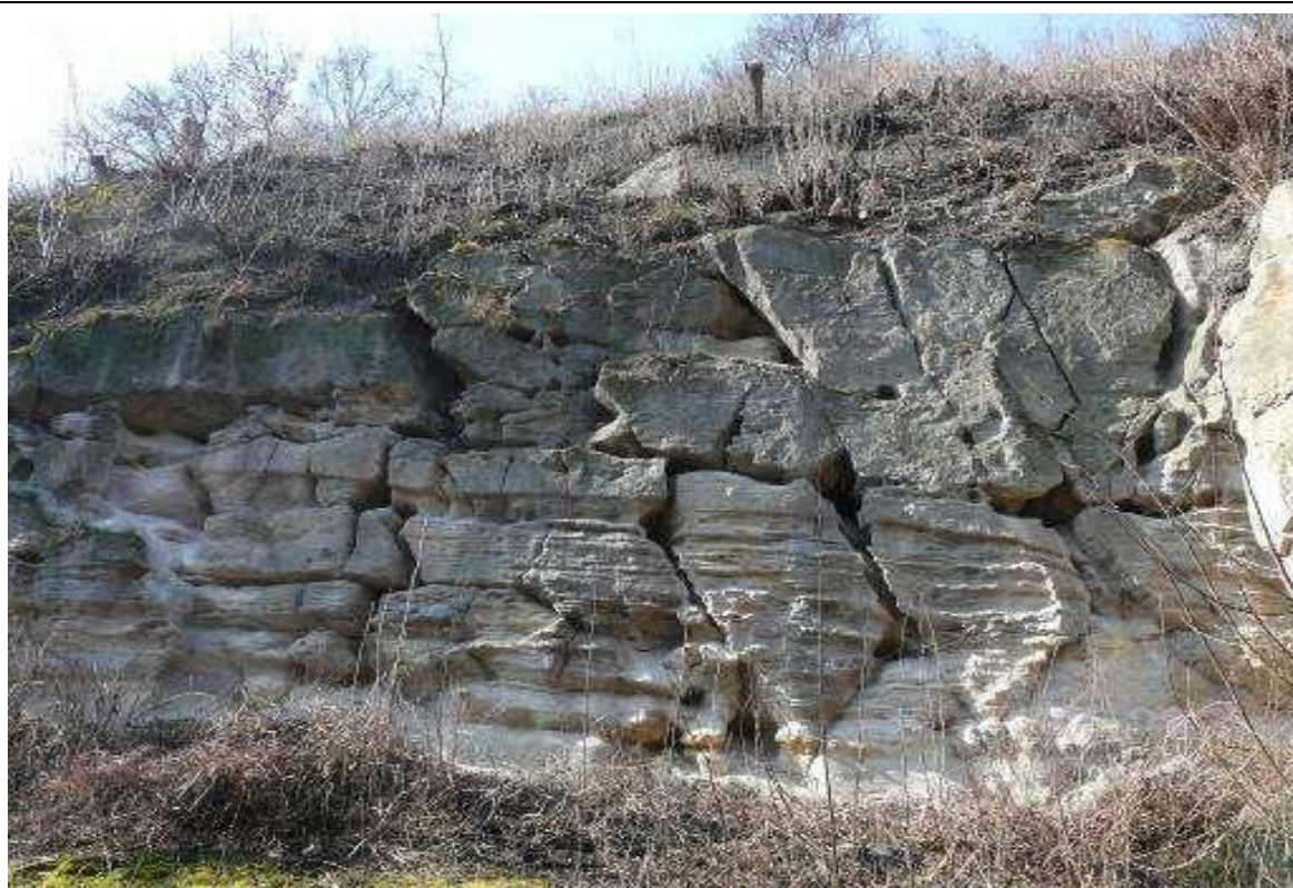
Obrázek 26: Rozpukání pískovcové stěny před výjezdovým portálem
