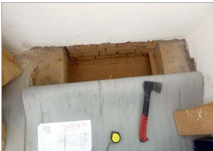
foto 21, 22: Průzkumná sonda P-5 v podlaze 2.NP a pohled do dutiny trámové stropní konstrukce v místě sondy
