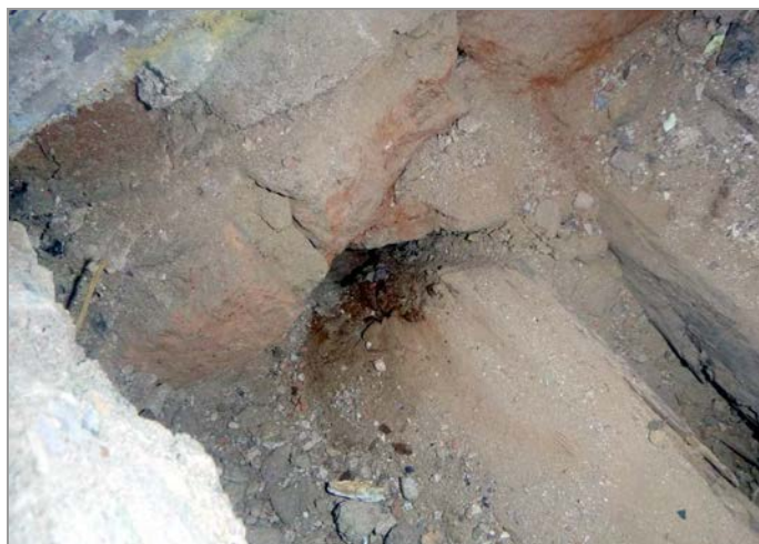
foto 30: Hnilobou poškozené trámové zhlaví v sondě P-8
