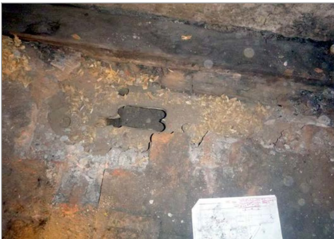
foto 31, 32: Průzkumná sonda P-9 v podlaze 3.NP/půdy a pohled do dutiny trámové stropní konstrukce v místě sondy
