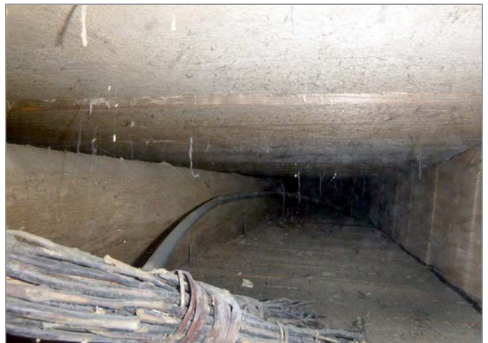
foto 31, 32: Průzkumná sonda P-9 v podlaze 3.NP/půdy a pohled do dutiny trámové stropní konstrukce v místě sondy
