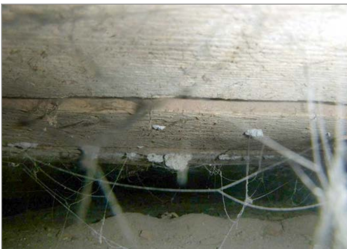
foto 21, 22: Průzkumná sonda P-5 v podlaze 2.NP a pohled do dutiny trámové stropní konstrukce v místě sondy
