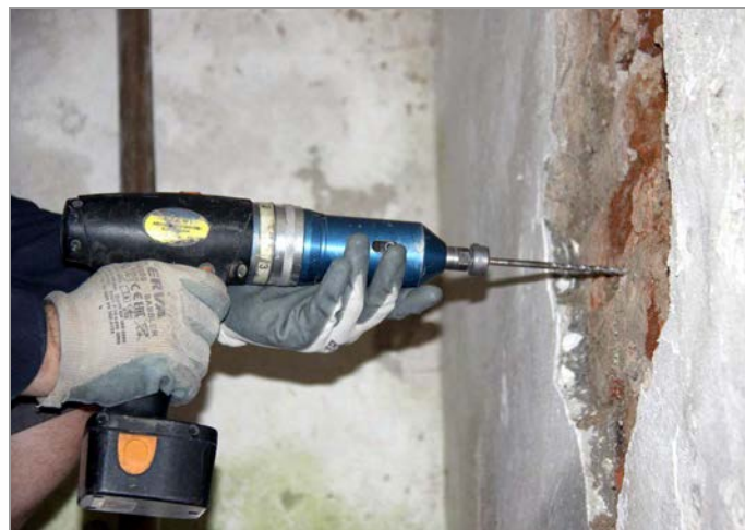
foto 15, 16: Ověřování pevnosti cihelného zdiva metodou místního porušení v sondě Z-1 v 1.NP
