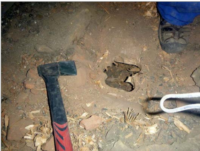
foto 33, 34: Průzkumná sonda P-10 v podlaze půdy západní části budovy a pohled do dutiny trámové stropní konstrukce v místě sondy
