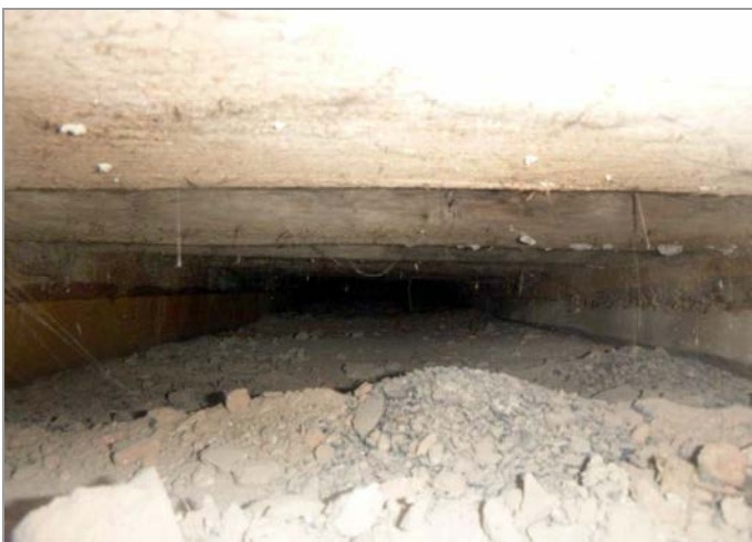
foto 23, 24: Průzkumná sonda P-6 v podlaze 2.NP a pohled do dutiny trámové stropní konstrukce v místě sondy
