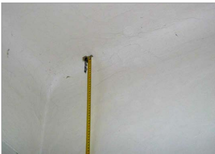
foto 29: Zkušební průvrt stropní konstrukce nad 2.NP v sondě P-8
