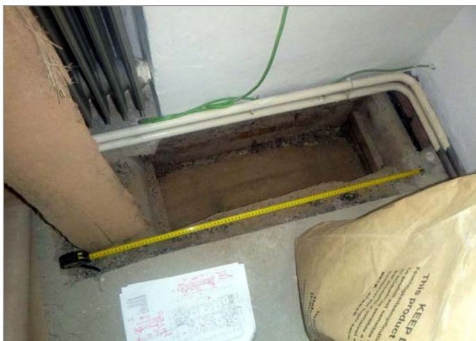
foto 23, 24: Průzkumná sonda P-6 v podlaze 2.NP a pohled do dutiny trámové stropní konstrukce v místě sondy
