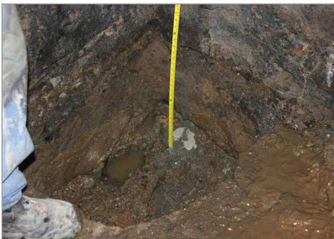
foto 7, 8: Hloubení kopané a ručně dovrtané průzkumné sondy KV-1 v podlaze 1.PP pro ověření založení
