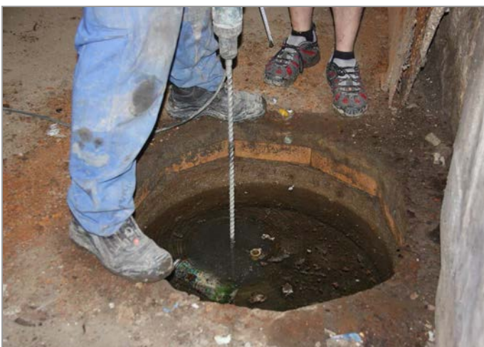
foto 9, 10: Hloubení ručně vrtané průzkumné sondy V-2 v podlaze 1.PP pro ověření základových poměrů
