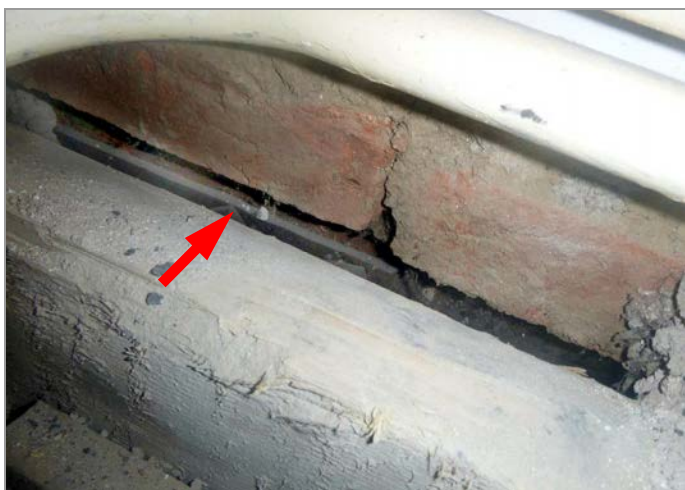
foto 25: Podchycení příčky 2.NP ocelovým nosníkem v sondě P-6
