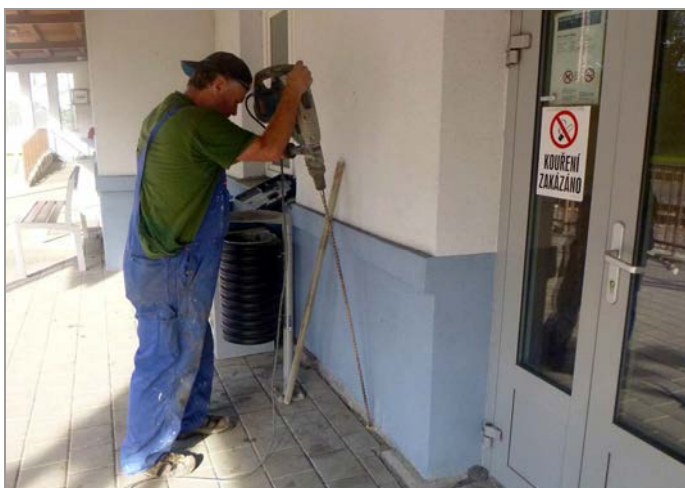
foto 11, 12: Hloubení ručně vrtané průzkumné sondy V-3 vně budovy pro ověření základových poměrů v nepodsklepené části
