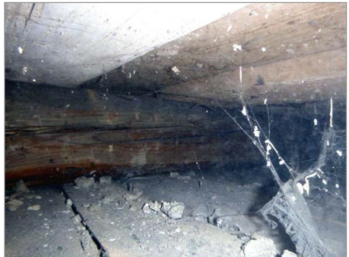
foto 33, 34: Průzkumná sonda P-10 v podlaze půdy západní části budovy a pohled do dutiny trámové stropní konstrukce v místě sondy
