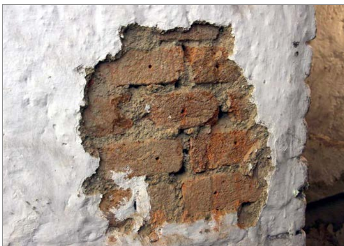
foto 17: Detail zkušebního místa pro ověření pevnosti zdiva
