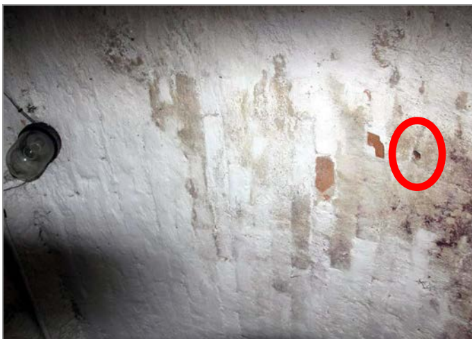
foto 19, 20: Průzkumný vrt V-4 do klenby nad 1.PP pro ověření skladby stropní konstrukce
