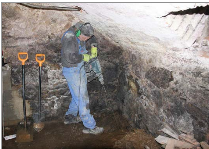
foto 7, 8: Hloubení kopané a ručně dovrtané průzkumné sondy KV-1 v podlaze 1.PP pro ověření založení
