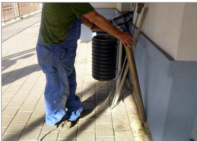
foto 13, 14: Jádrové dovrtávání průzkumné sondy V-3 vně budovy
