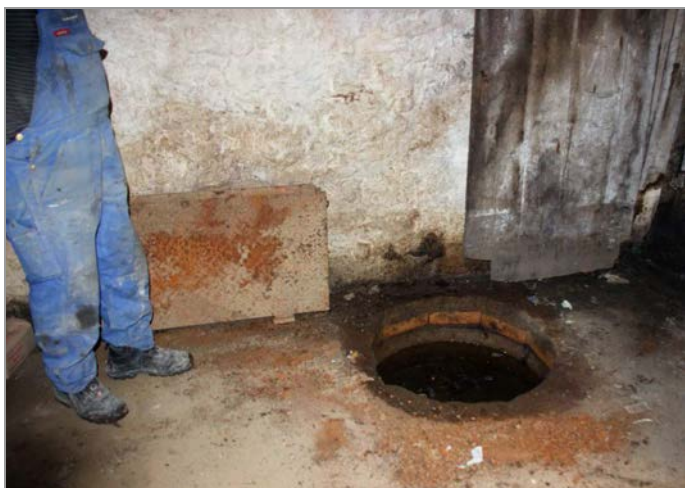
foto 9, 10: Hloubení ručně vrtané průzkumné sondy V-2 v podlaze 1.PP pro ověření základových poměrů
