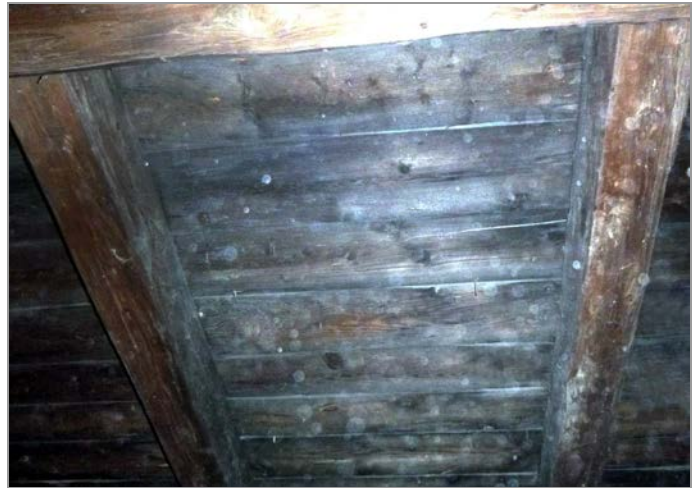
foto 38: Detail prkenného podbití taškové střešní krytiny
