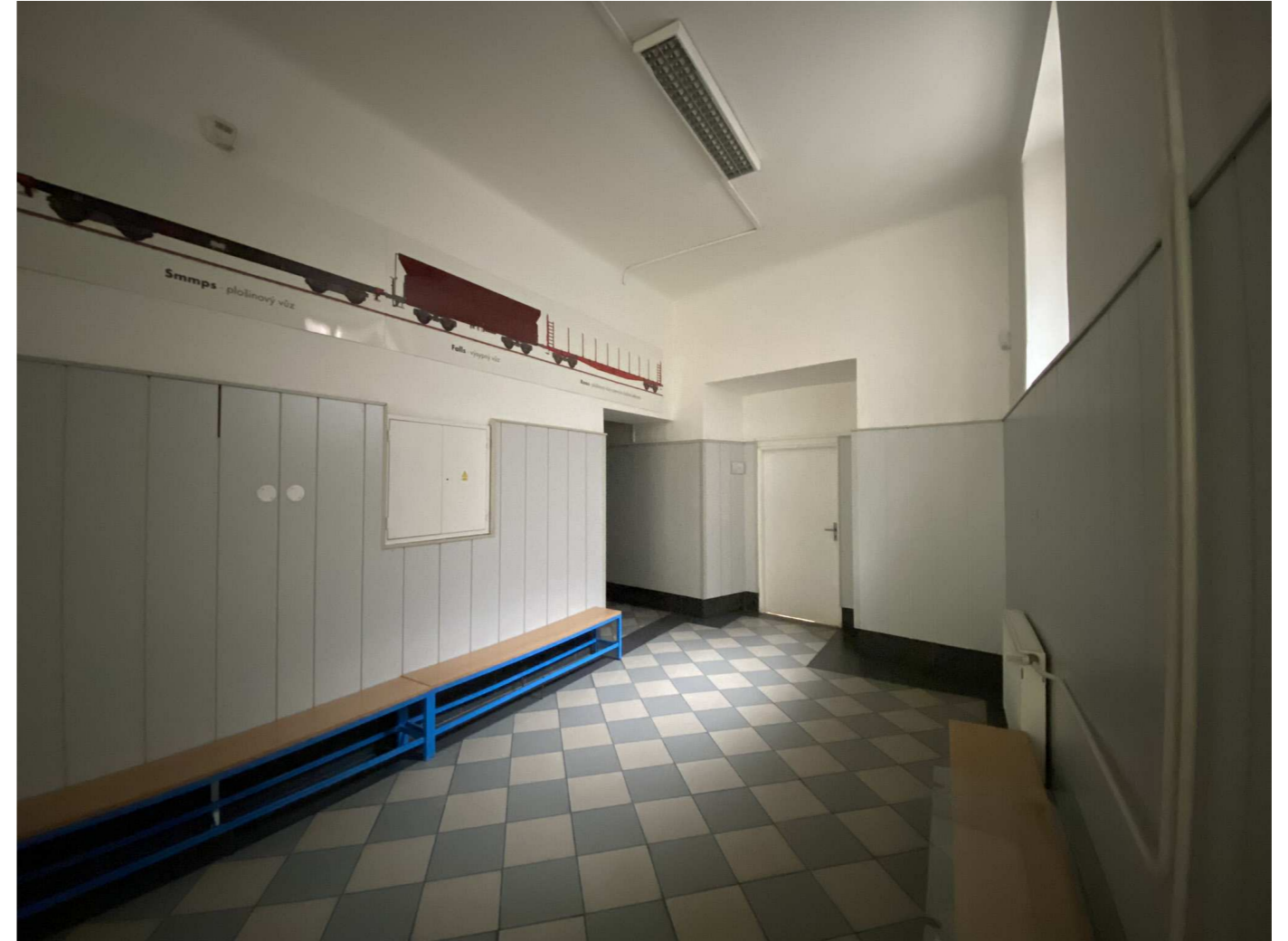
chodba ve 2NP budovy B - Masná 8
