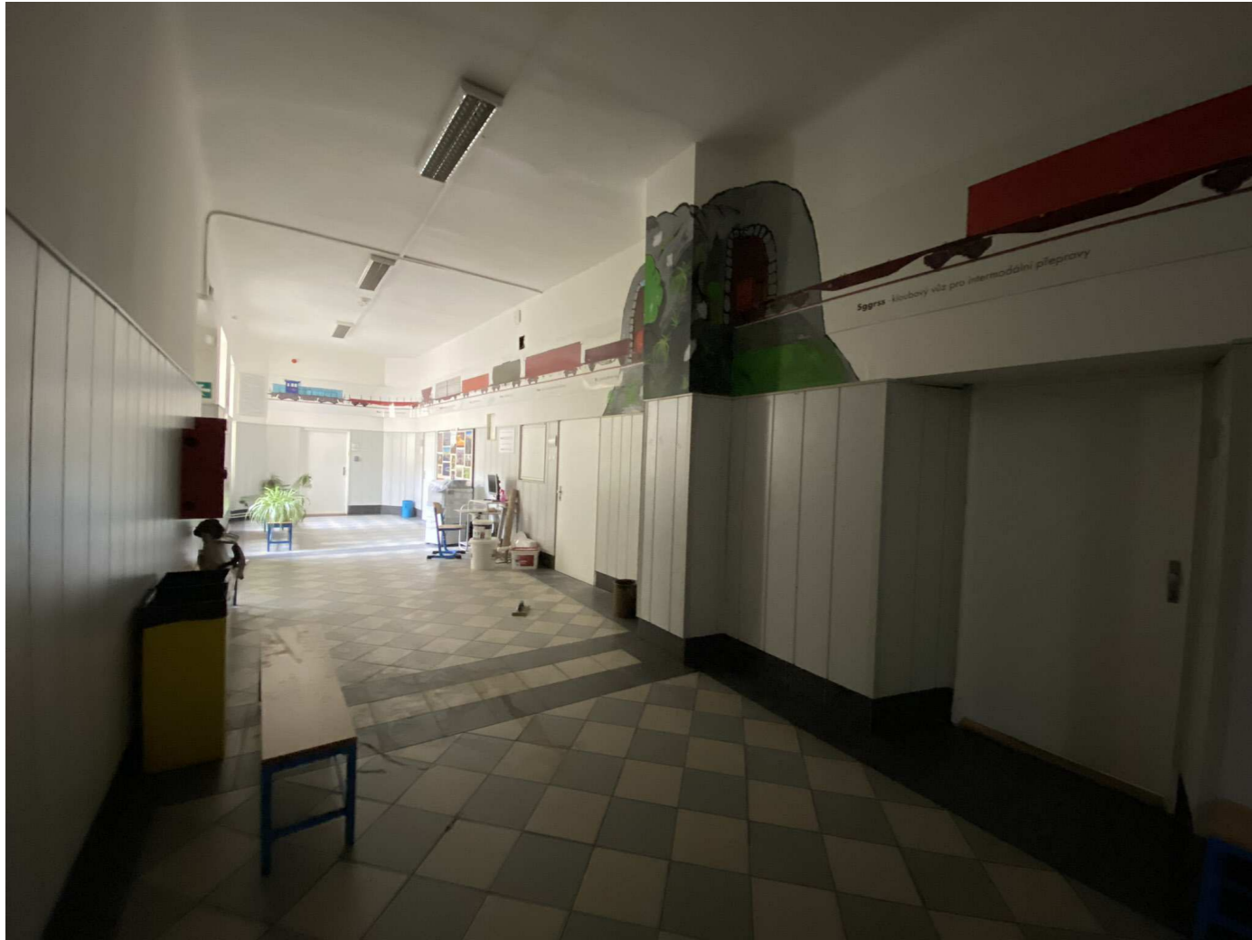
chodba ve 2NP budovy B - Masná 8
