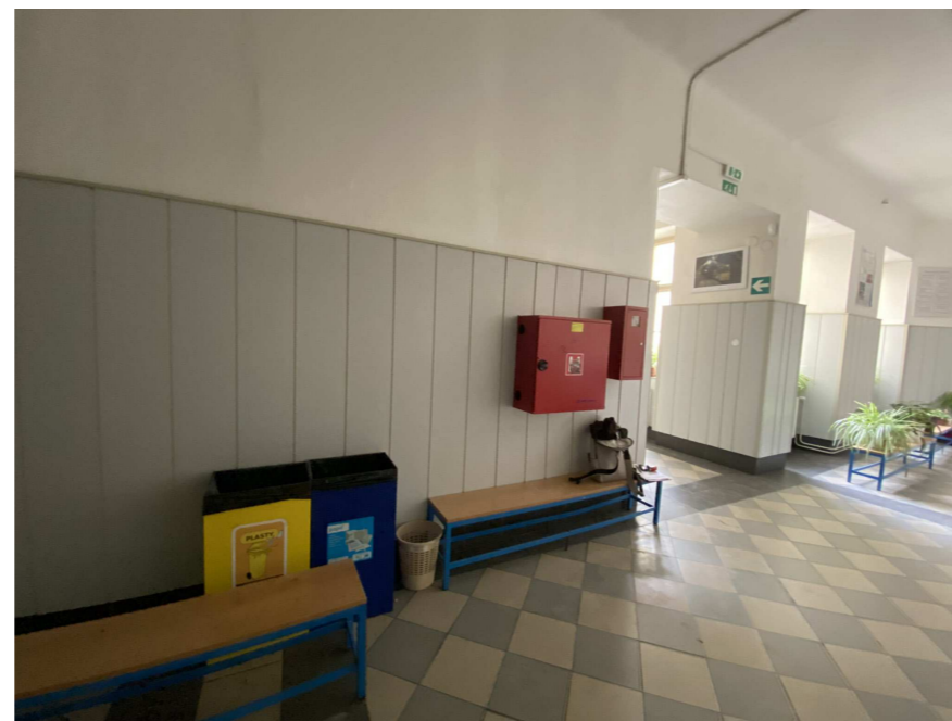
chodba ve 2NP budovy B - Masná 8
