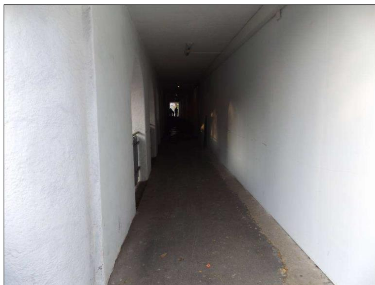
Obr. č. 15 - pohled na instalované sádkartonové desky překrývající keramický obklad vybrané opěry
