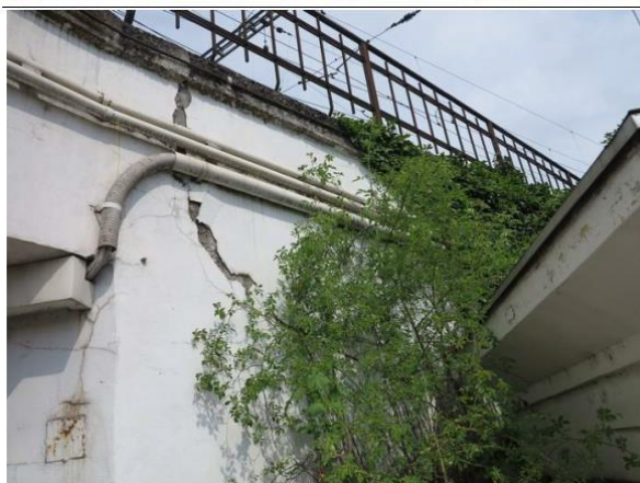
Foto č. 3 O 02 - křídlo vpravo, trhlina
