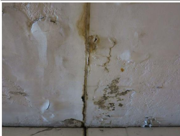
Foto č. 1 K 01 - průsaky u dilatační spáry, vzduť povrchová úprava
