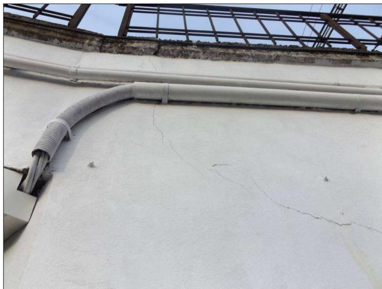
Obr. č. 17 - pohled na průběžnou trhlinu v líci pravého křídla královohradecké opěry
