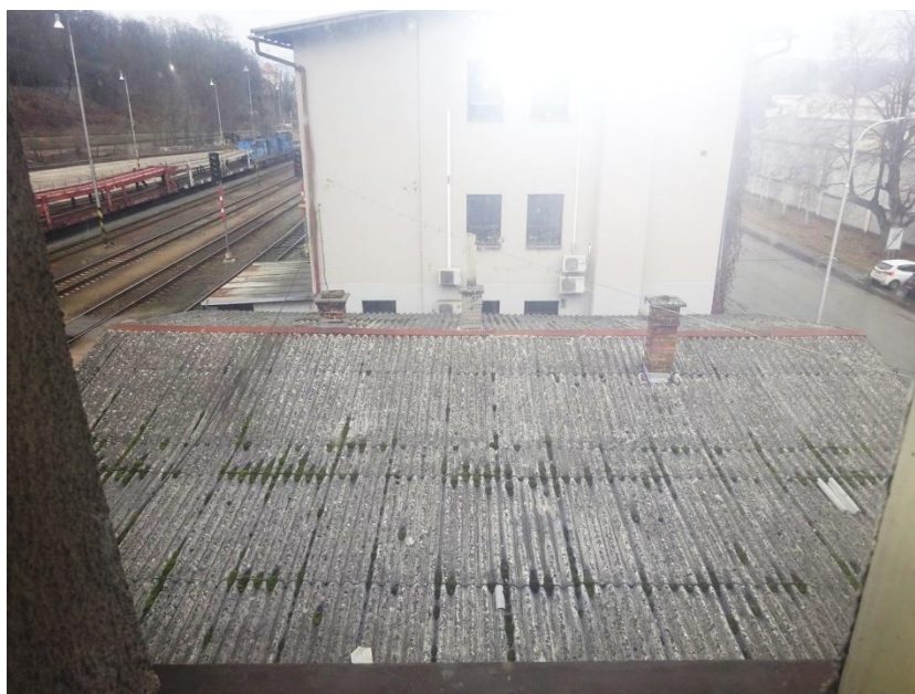
Azbestocementová krytina sousedního objektu
