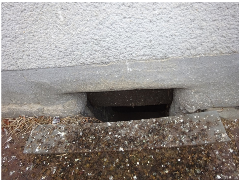
Větrací sklepní okno sousední budovy
