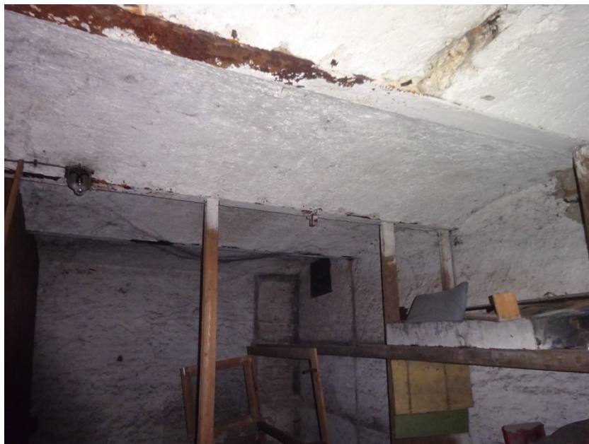
Strop nad sklepem, klenby do travers, koroze nosníků
