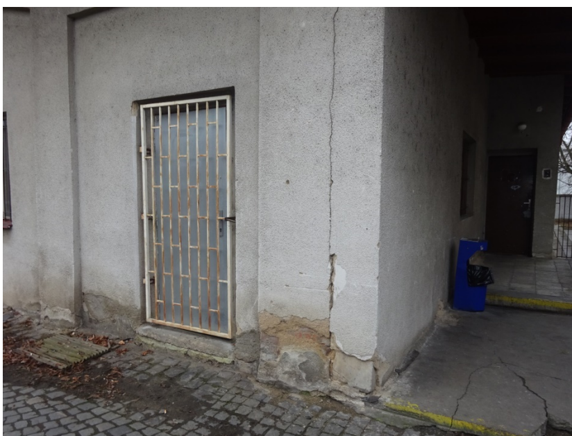
Přístavek sousedního objektu, trhliny ve zdivu, působení vlhkosti
