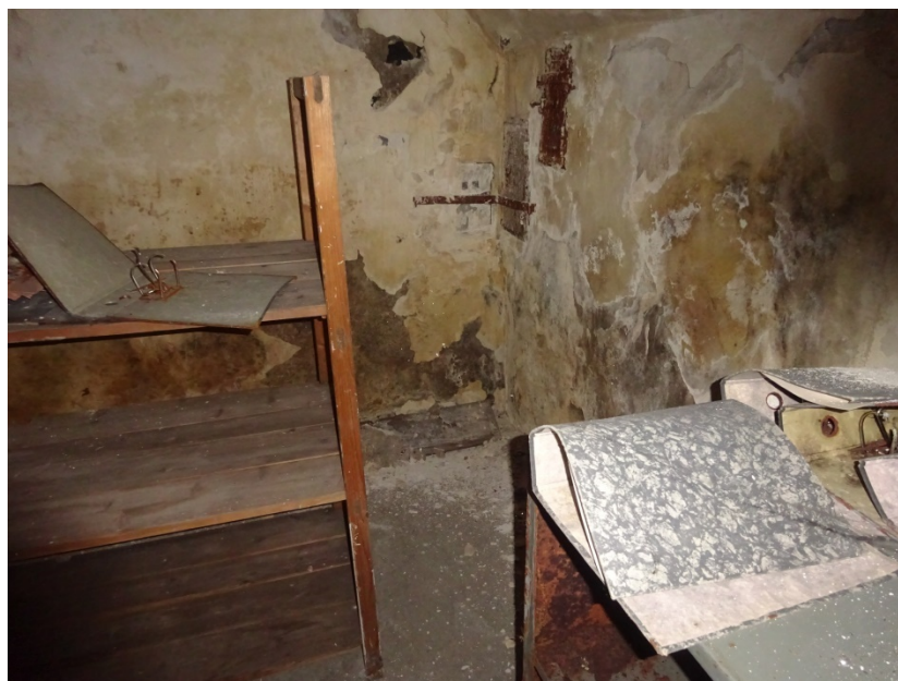
Projevy vlhkosti a salinity zdiva v suterénu
