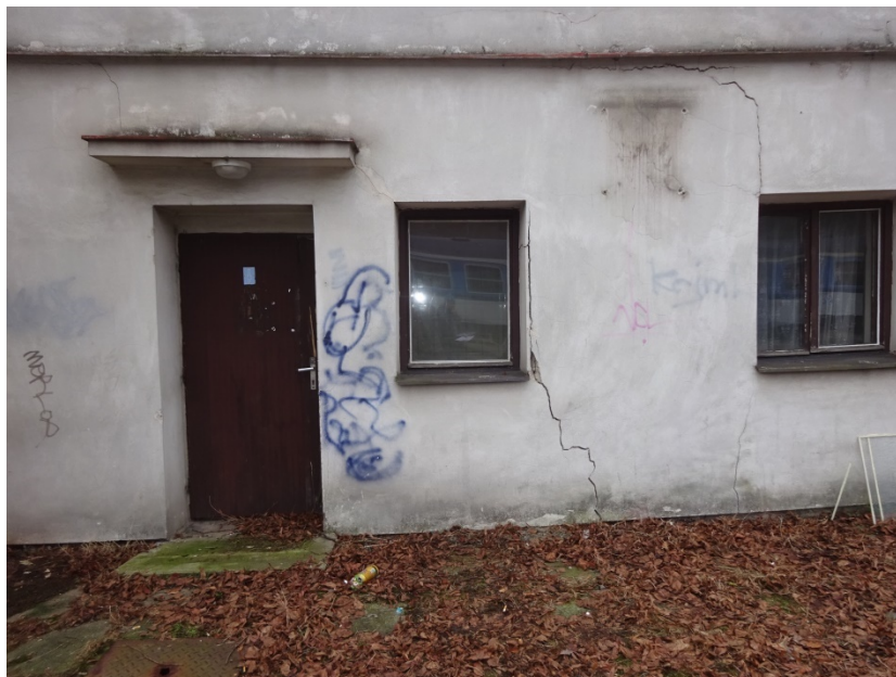
Přístavek WC, trhliny od nerovnoměrných poklesů v základech
