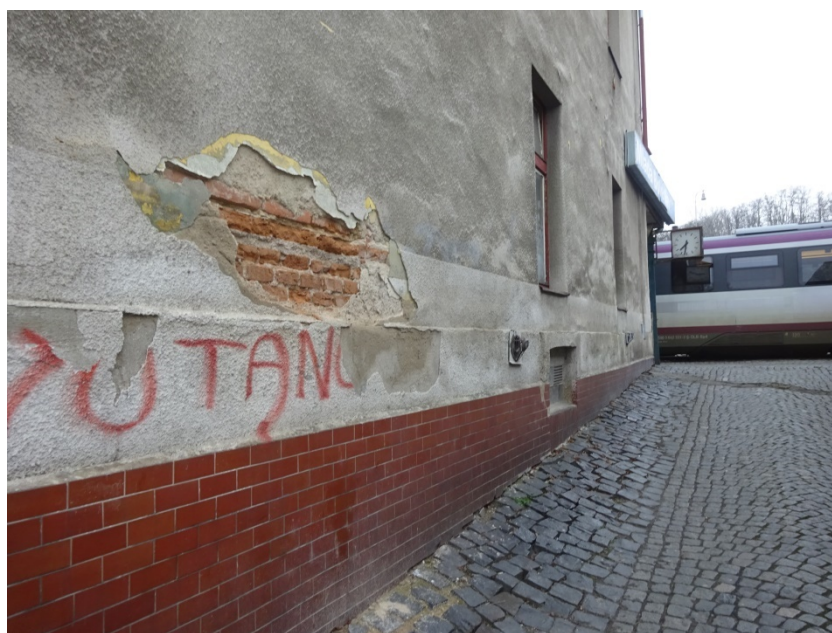
Povrchová degradace cihel
