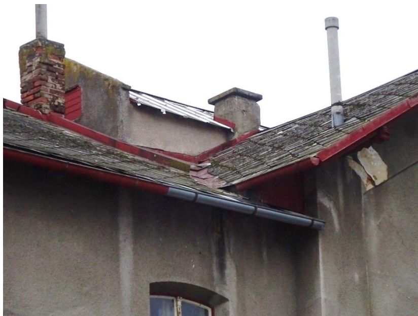
Azbestocementové odvětrání stoupačky a komína, světlík
