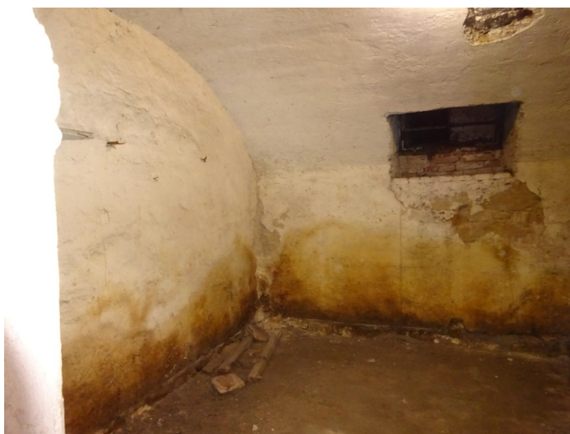
Klenutý strop nad suterénem, působení vlhkosti
