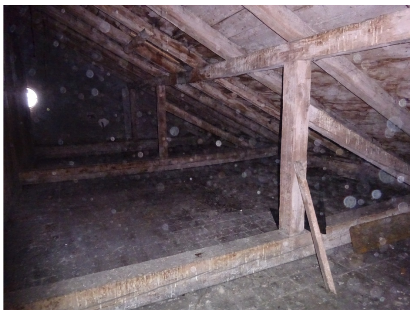
Půda, konstrukce krovu stožaté stolice
