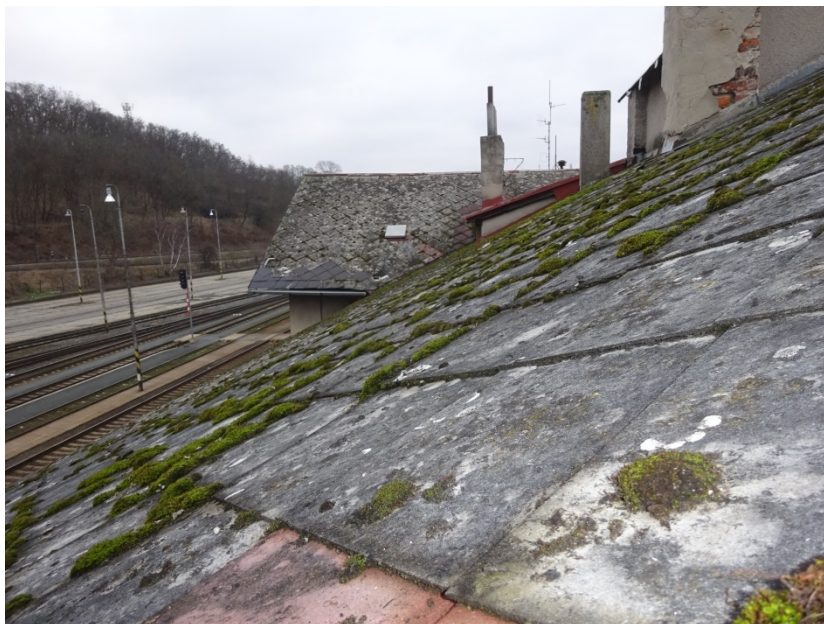
Mech na azbestocementové krytině
