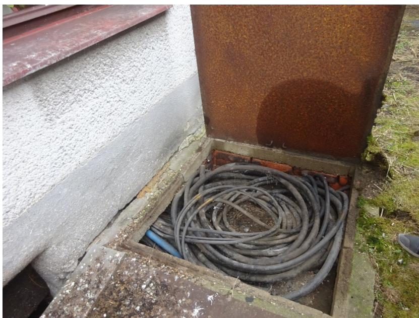
Bývalý shoz na uhlí a odkrytý kabelový kanál u štítu sousední budovy
