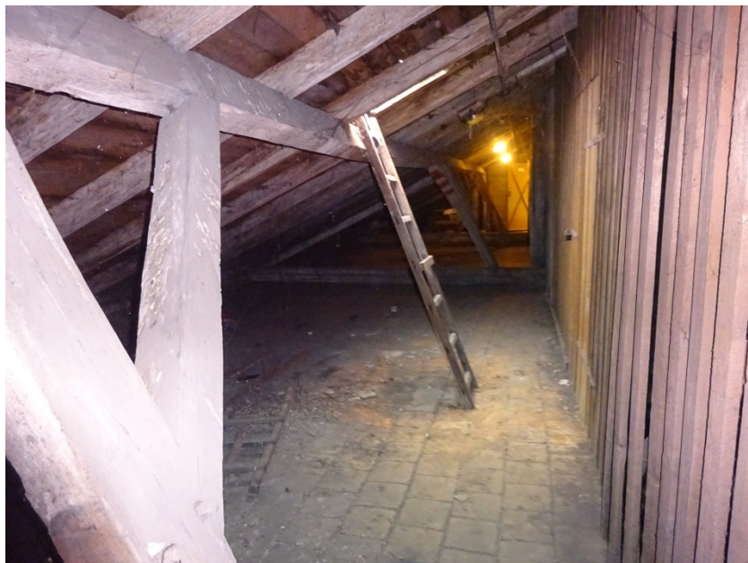
Konstrukce krovu ležaté stolice
