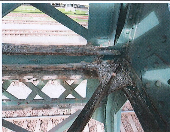
Foto č. 6 Konstrukce K 05 –1. příčné ztužení dolní pásnice vlevo – štěrbinová koroze.
