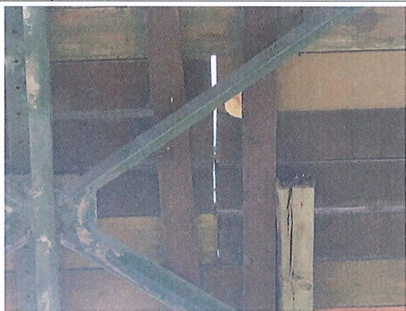
Foto č. 11 - Konstrukce K 02 – podhled -vlevo houba
