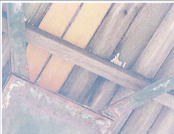
Foto č. 12 Konstrukce K 05 – 1. pole houba.
