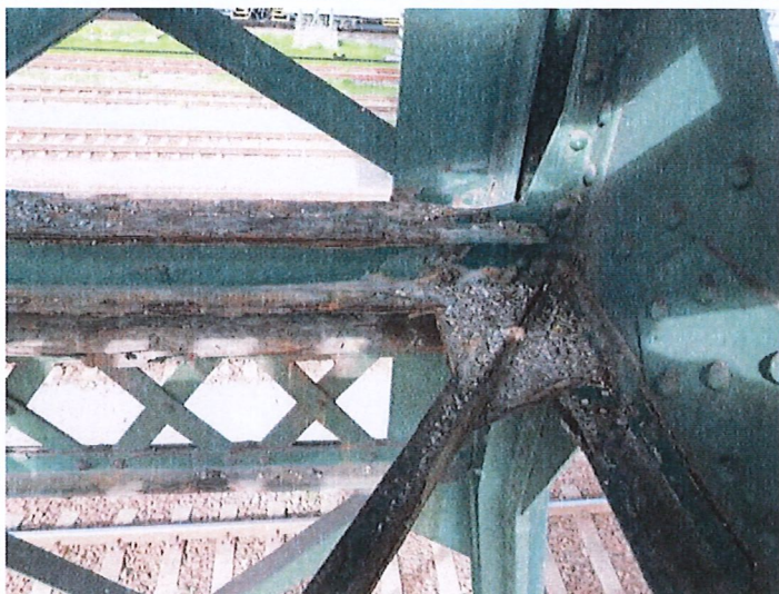
Foto č. 6 Konstrukce K 05 – 1. příčné ztužení dolní pásnice vlevo – šterbinová koroze.
