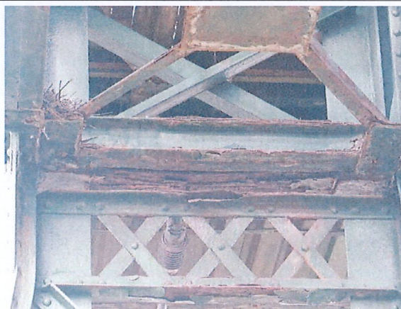
Foto č. 10 Podpěra P 06 – příhradový nosník – oslabení.
