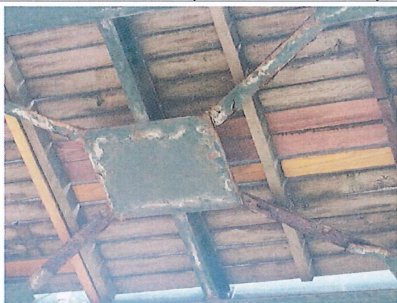
Foto č. 5 Konstrukce K 05 – podhled – podélné ztužení vpravo – plátková koroze, nátěr.
