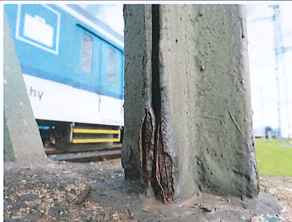
Foto č. 9 Podpěra P 05 – dolní část - konec –oslabení – štěrbinová koroze.
