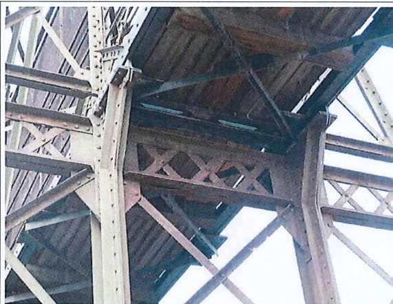
Foto č. 8 Podpěra P 02 – příhradový nosník – oslabení.
