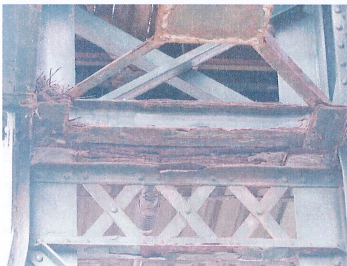
Foto č. 10 Podpěra P 06 – příhradový nosník – oslabení.
