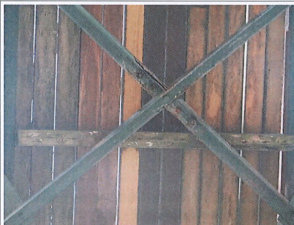
Foto č. 4 Konstrukce K 04 –1. příčné ztužení vlevo– štěrbinová koroze
