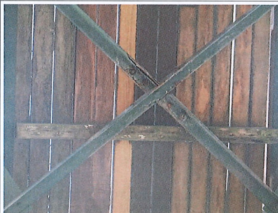
Foto č. 2 Konstrukce K 01 – podhled – vlevo – podélné ztužení hlavních nosníků – štěrbinová koroze
