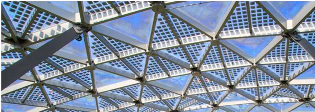
Obrázek 3 - Příklad řešení zasklení s fotovoltaickými články
