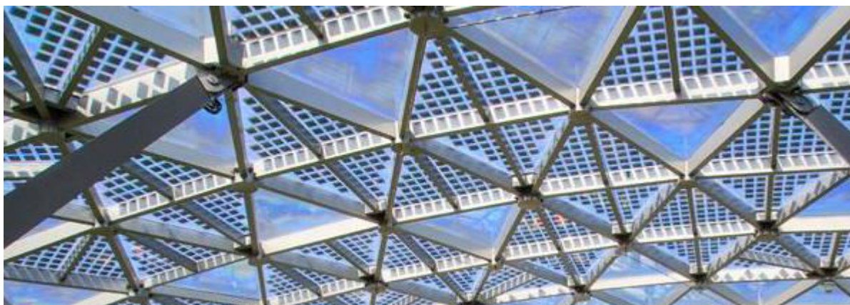
Obrázek 3 - Příklad řešení zasklení s fotovoltaickými články
