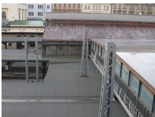
Návaznost zastřešení nástupišť na halu C1 a C2
