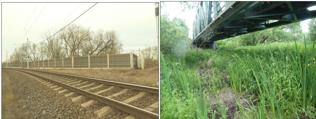
Obr. 22: Vlevo protihlukové zábrany sloužící jako zábrany proti rušení druhů využívajících k hnízdění rákosinu mezi železnicemi, vpravo železniční most přes Pustějovský potok
