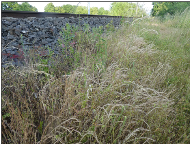
Obr. 14: Mrvka myší ocásek na železničním náspu
