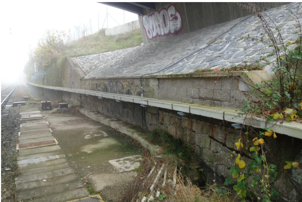
Obrázek 8 – uložení kabelových tras na jižní opěře silničního nadjezdu II/150 v km 232,675 (říjen 2020)
