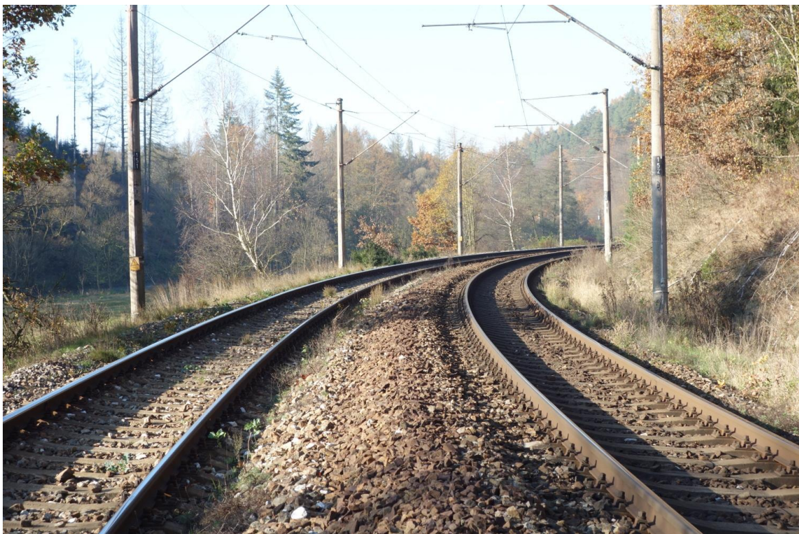
Obrázek 30 - oblouk malého poloměru R=258\text{m} s propadem traťové rychlosti v km 237,500 (říjen 2020)
