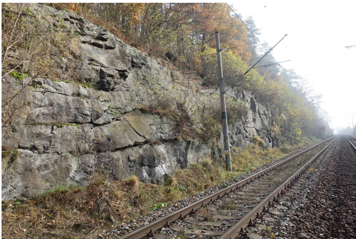
Obrázek 21 – odtěžený horninový svah v km 235,500 (říjen 2020)
