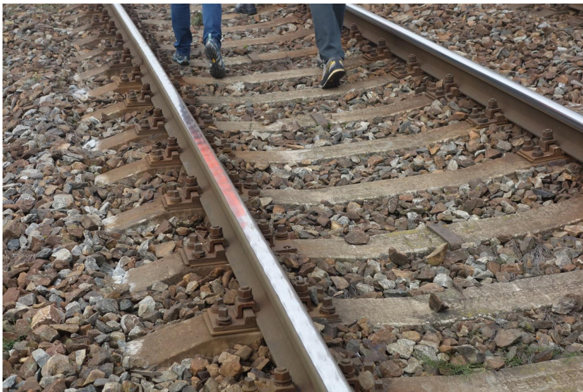
Obrázek 19 – vlnkovitost na nepřevýšeném kolejnicovém pásu v oblouku o poloměru 275m v km 234,100 (říjen 2020)
