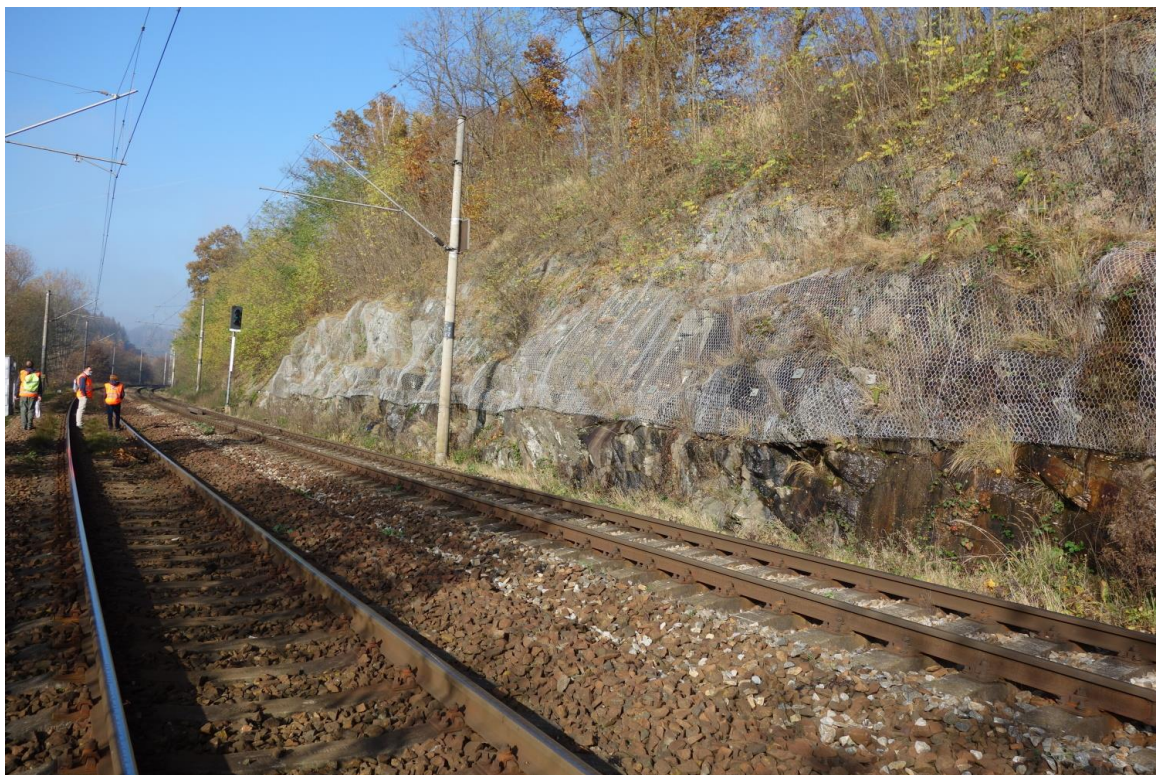
Obrázek 23 - stabilizované horninové svahy v km 236,000 (říjen 2020)
