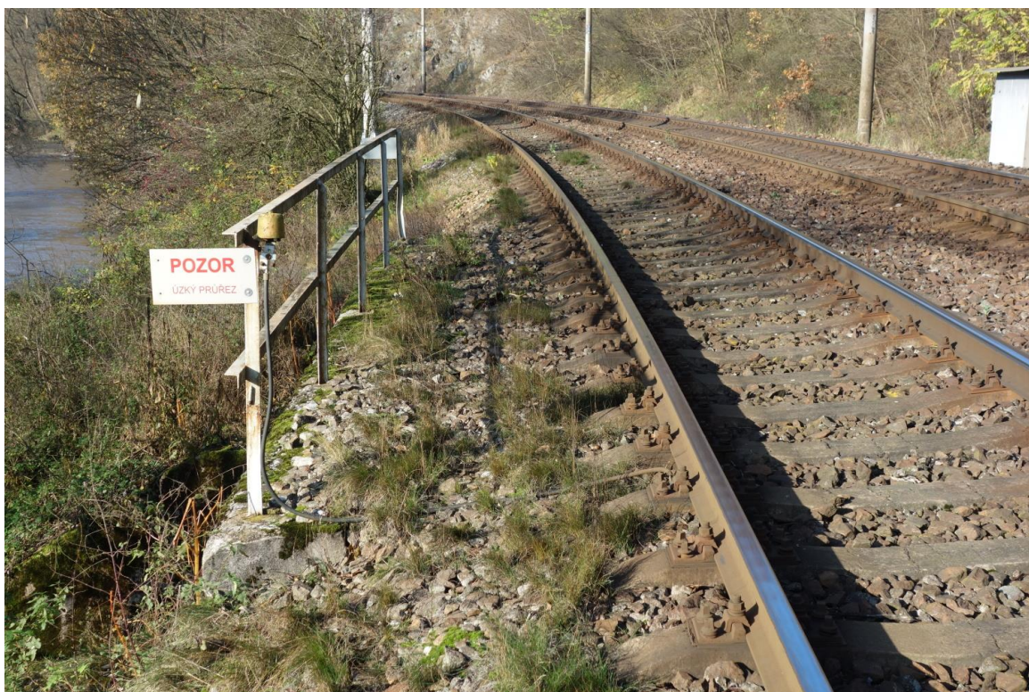
Obrázek 26 – most v místě oblouku s projektovaným zvětšením poloměru a odstraněním propadu traťové rychlosti v km 236,650 (říjen 2020)
