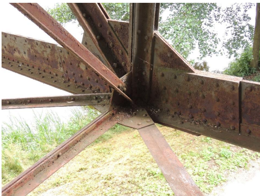
Detail počínající koroze ocelové konstrukce mostu
