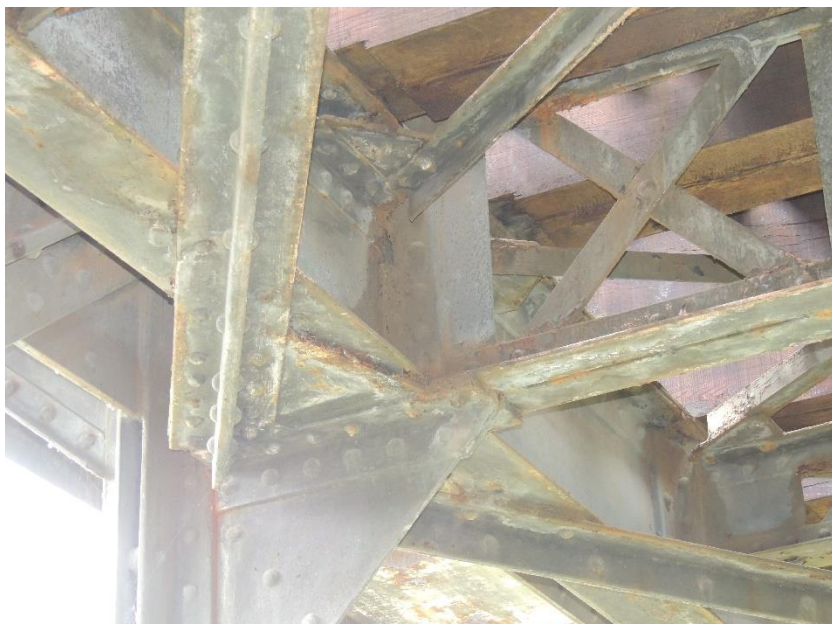
Detail počínající koroze ocelové konstrukce mostu
