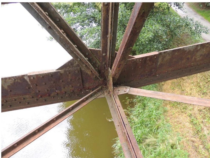
Detail počínající koroze ocelové konstrukce mostu
