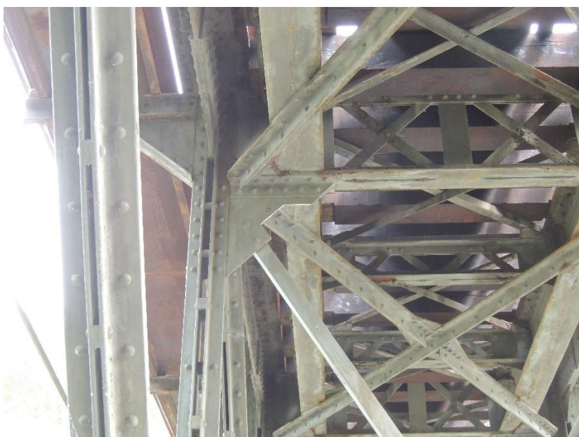
Místo odběru vzorku číslo 6 pro tahové zkoušky oceli
