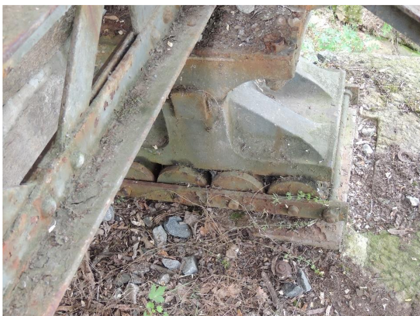
Pohled na ložisko ocelové konstrukce K01 na opěře O01
