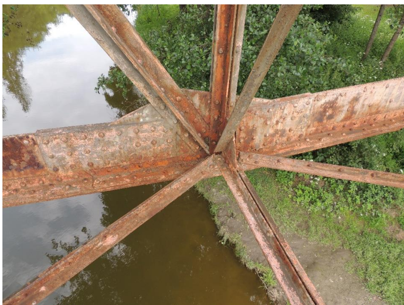
Detail počínající koroze ocelové konstrukce mostu
