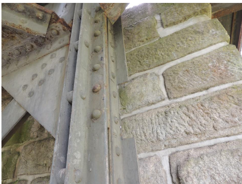
Místo odběru vzorku číslo 3 pro tahové zkoušky oceli
