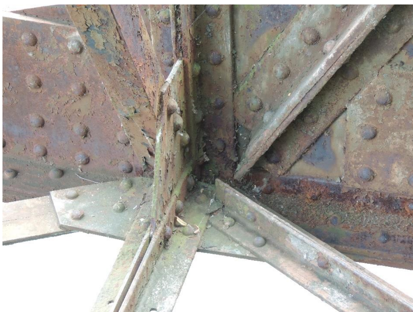
Detail loupající se protikorozní ochrany, ulpěných nečistot a koroze ocelové konstrukce vlivem zadržování srážkové vody na konstrukci
