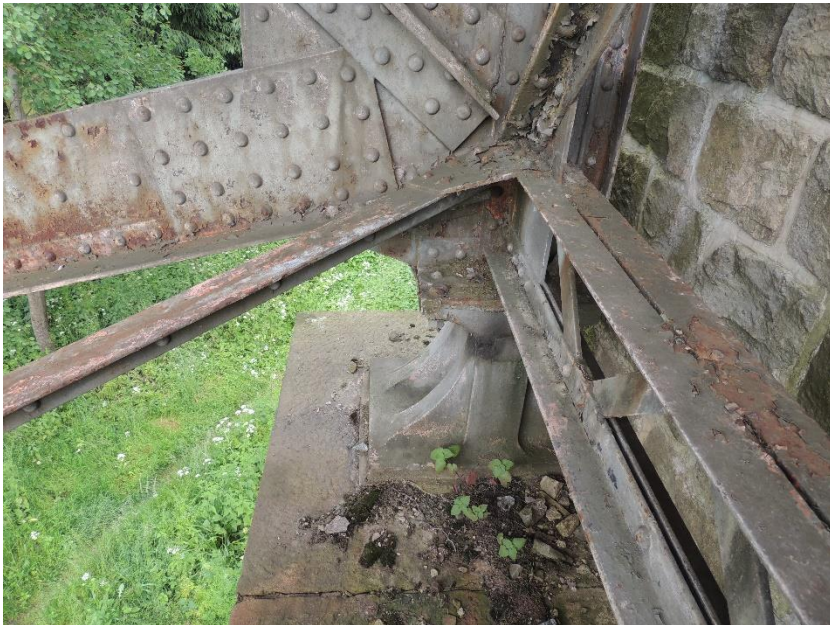
Pohled na pevné ložisko mostu na opěře O02
