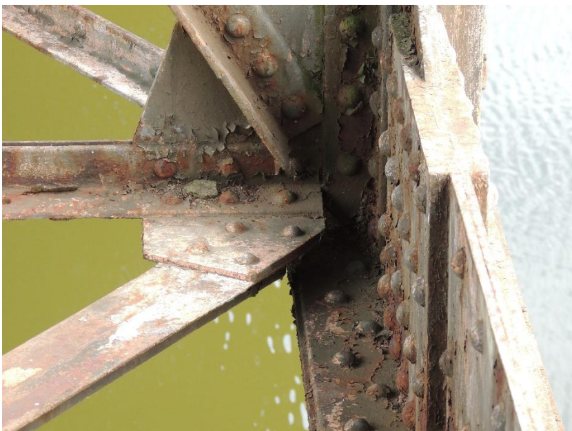
Detail loupající se protikorozi ochrany, ulpěných nečistot a koroze ocelové konstrukce vlivem zadržování srážkové vody na konstrukci
