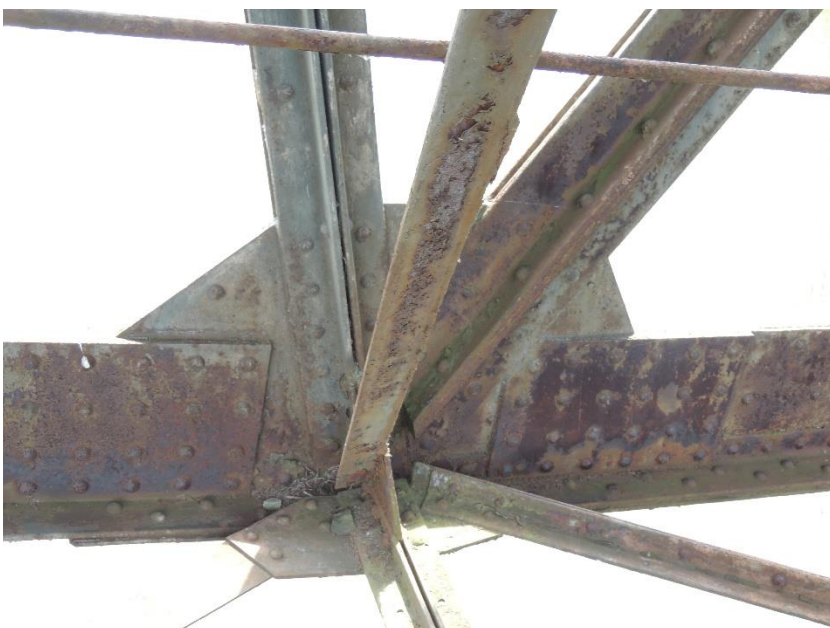
Detail počínající koroze ocelové konstrukce mostu
