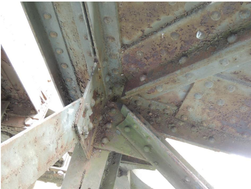
Detail loupající se protikoroziční ochrany, ulpěných nečistot a koroze ocelové konstrukce vlivem zadržování srážkové vody na konstrukci
