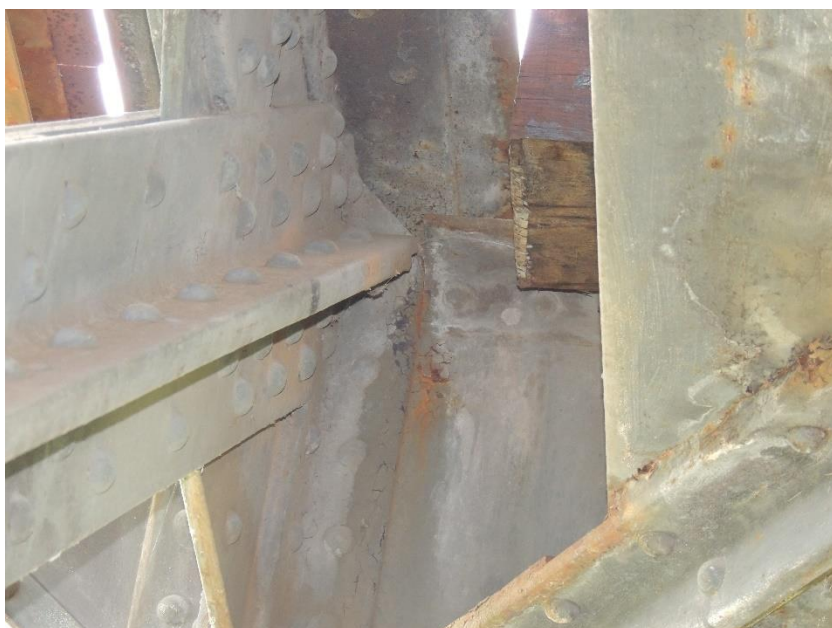
Detail počínající koroze ocelové konstrukce mostu
