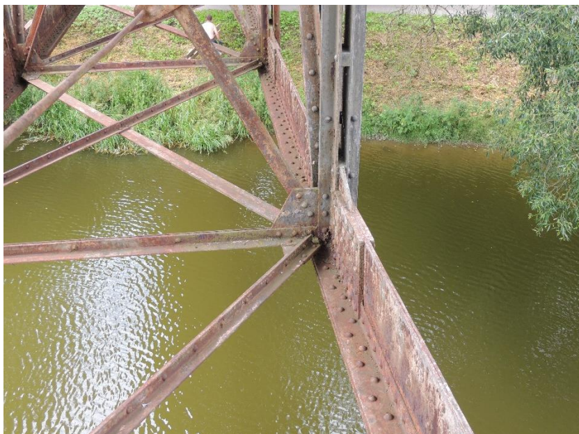
Detail počínající koroze ocelové konstrukce mostu
