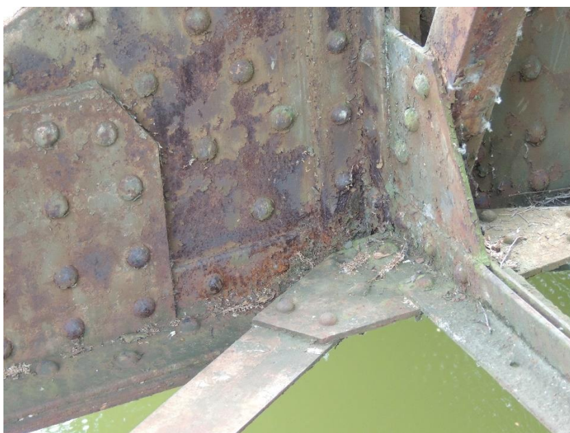
Detail loupající se protikoroziční ochrany, ulpěných nečistot a koroze ocelové konstrukce vlivem zadržování srážkové vody na konstrukci
