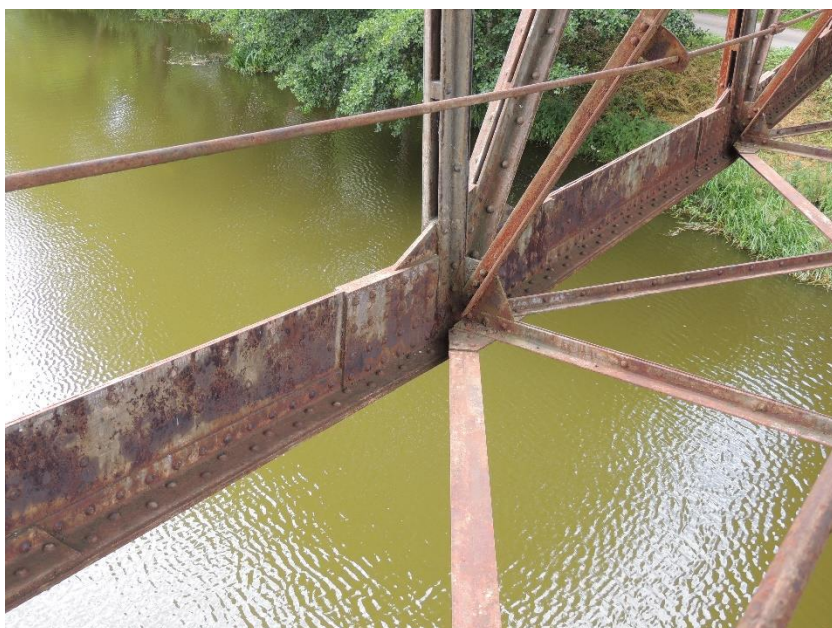
Detail počínající koroze ocelové konstrukce mostu
