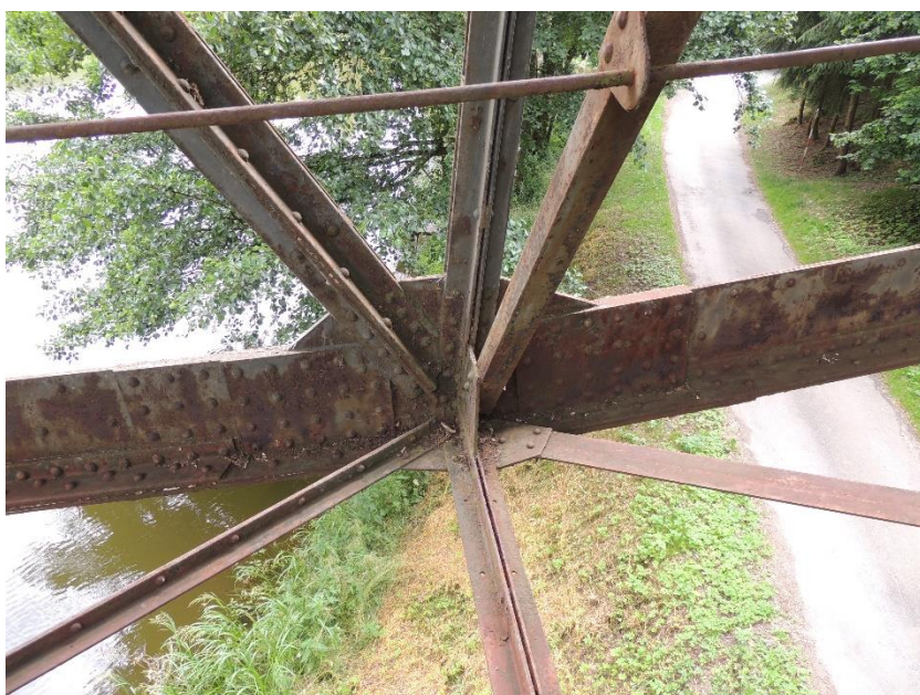
Detail počínající koroze ocelové konstrukce mostu
