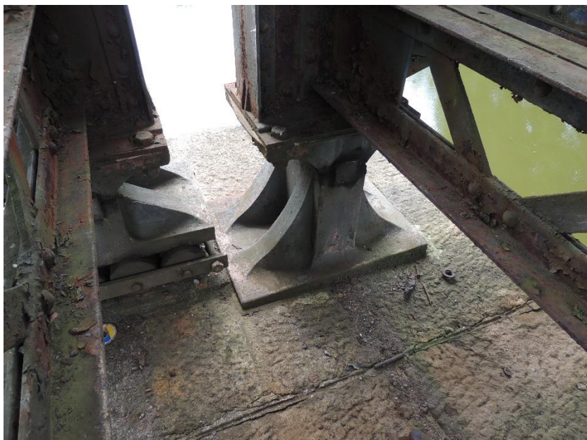
Detail ložiska ocelové konstrukce K01 na pilíři P01
