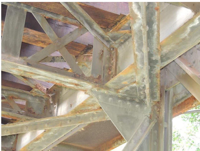
Detail počínající koroze ocelové konstrukce mostu
