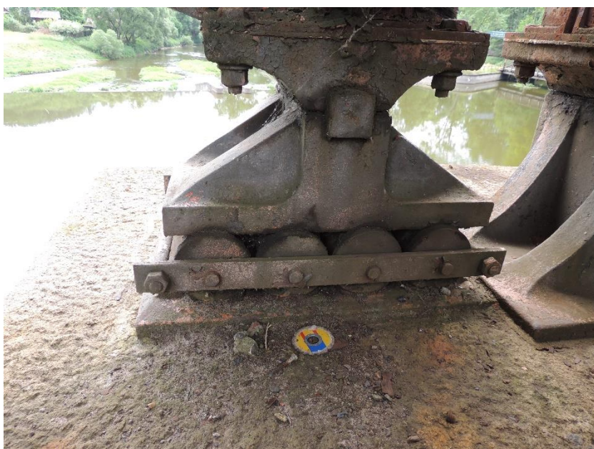
Detail ložiska ocelové konstrukce K02 na pilíři P01
