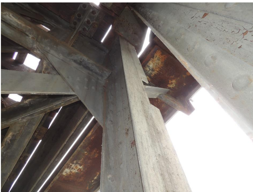
Místo odběru vzorku číslo 2 pro tahové zkoušky oceli
