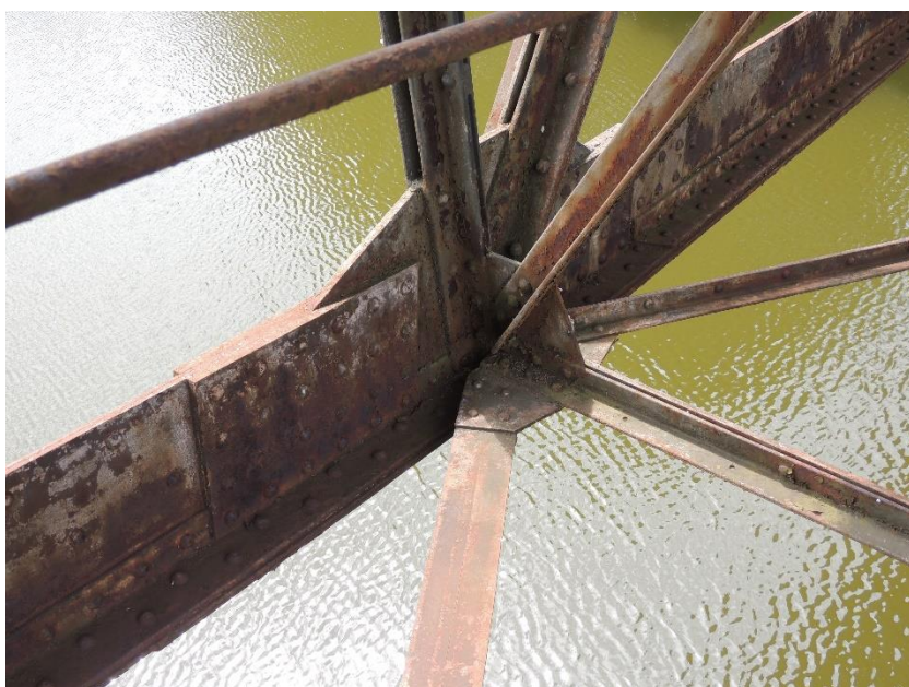
Detail počínající koroze ocelové konstrukce mostu
