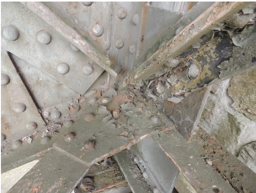
Detail popraskané a loupající se protikoroziční ochrany ocelové konstrukce mostu
