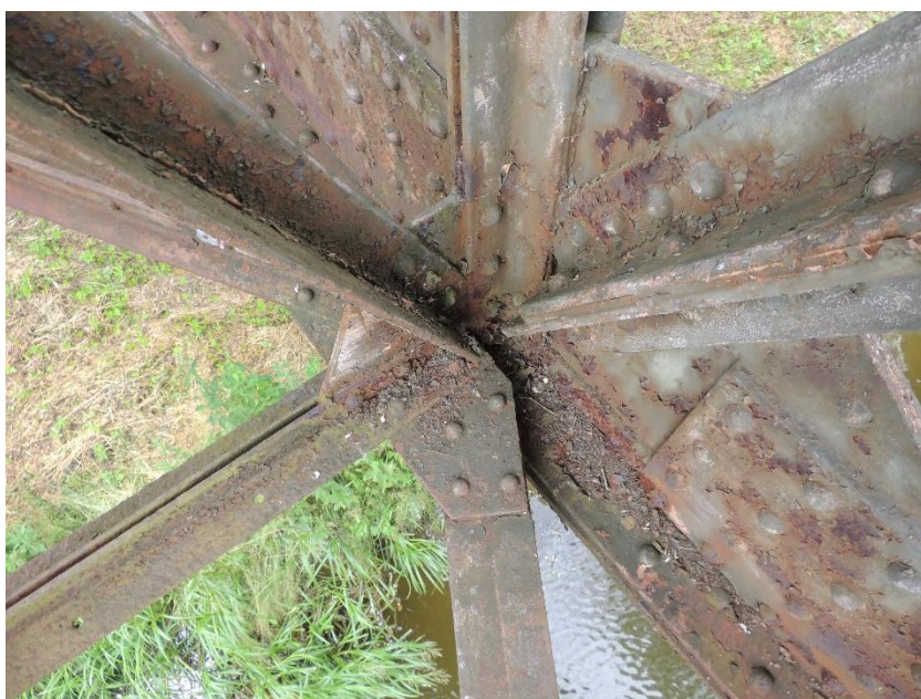
Detail loupající se protikorozi ochrany, ulpěných nečistot a koroze ocelové konstrukce vlivem zadržování srážkové vody na konstrukci
