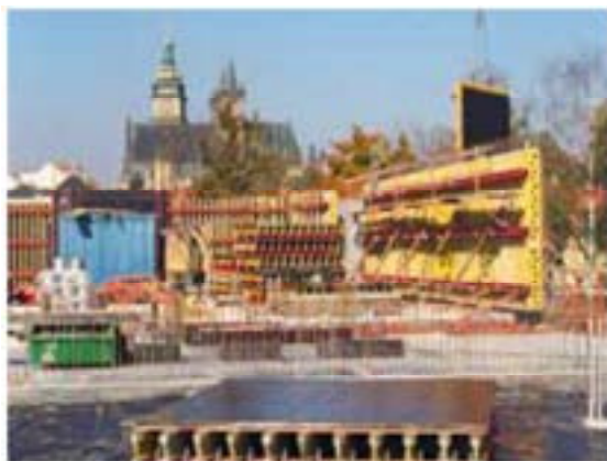
(25) Obr. F.4 – Nosníkové bednění
