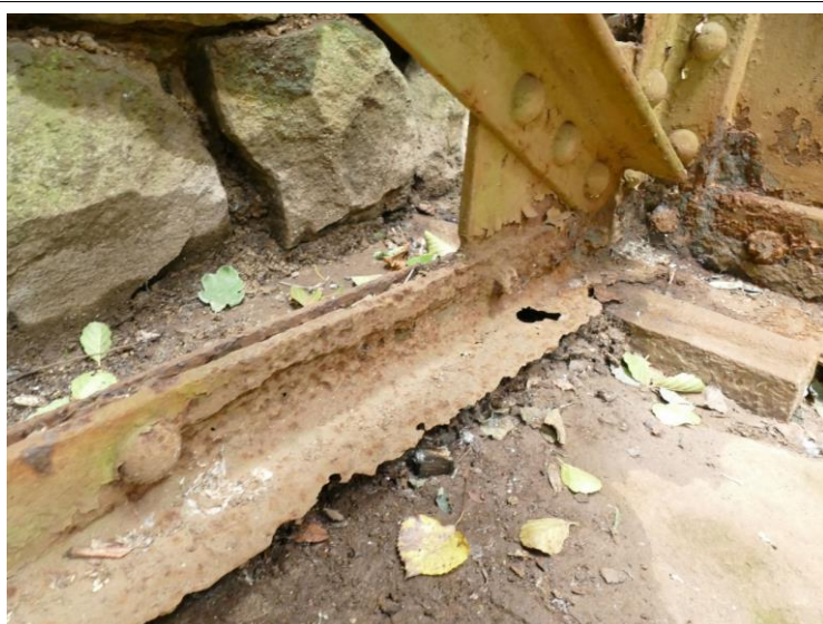
Konstrukce K 01: Korozní oslabení dolního krčního úhelníku 8. příčného ztužení
