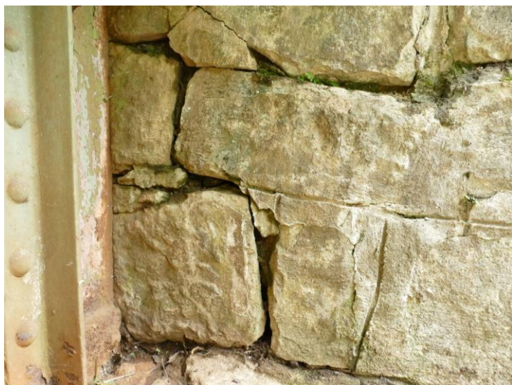
Opěra O 01: Vypadané spárování závěrné zdi
