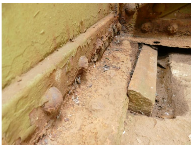
Konstrukce K 01: Zešikmené pravé ložisko na opěře O 01
