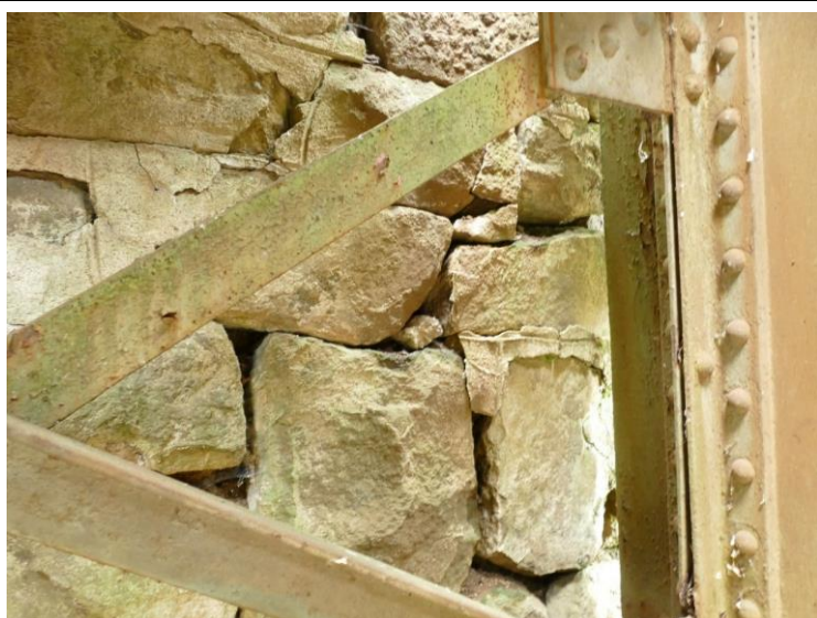
Opěra O 02: Vypadané spárování závěrné zdi
