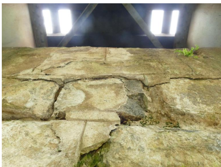
Opěra O 01: Počínající vysouvání zdiva dříku v horní části
