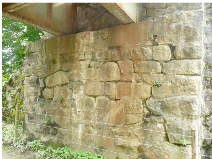
Opěra O 01: Vypadané spárování dříku
