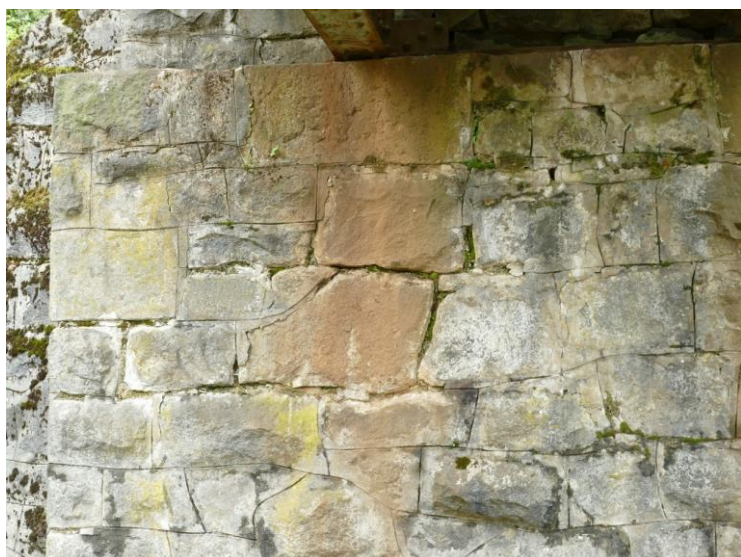
Opěra O 02: Vypadané spárování dříku
