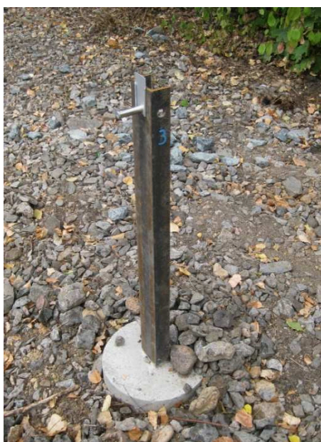
Obrázek 20 Otevřený profil konstrukce sloupku ŽPSV
