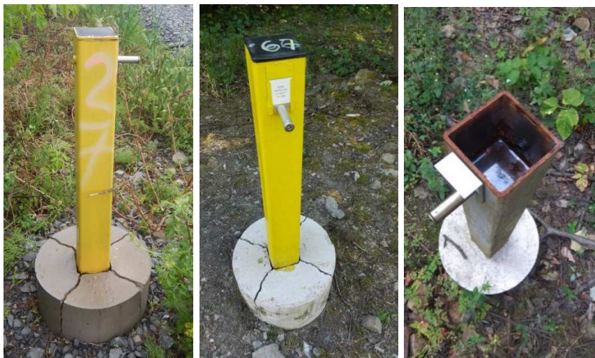
Obrázek 19 Popraskané betonové základy zajišťovacích značek ŽPSV
