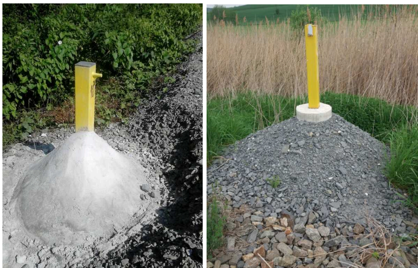
Obrázek 17 Řešení zhotovitele pro zvýšení stability zajišťovací značky
