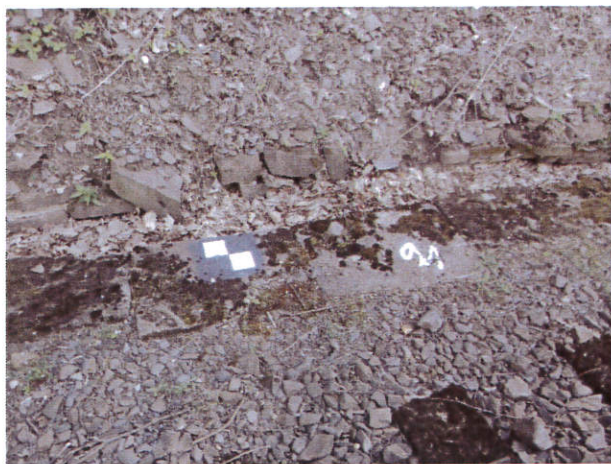
Foto 1 – na železničních pražcích je nános jemnozrné zeminy ze splachu povrchové vody ze svahu minimální
