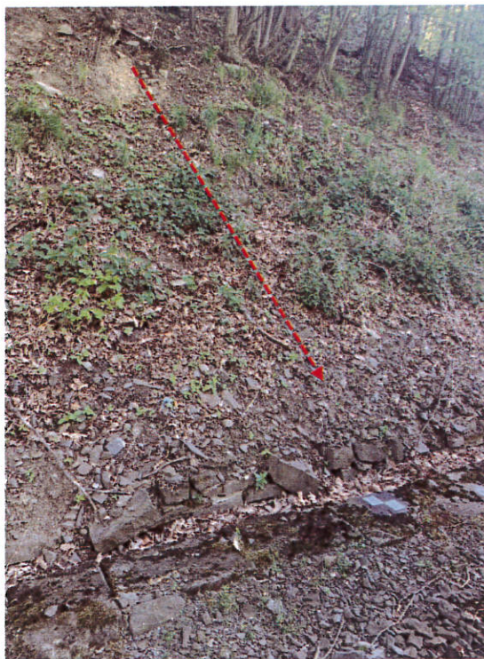
Foto 1 – na železničních pražcích je nános jemnozrné zeminy ze splachu povrchové vody ze svahu minimální
