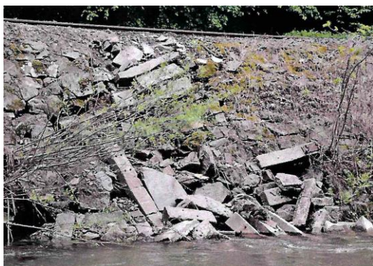
Střední část opěrné zdi – sesutí
