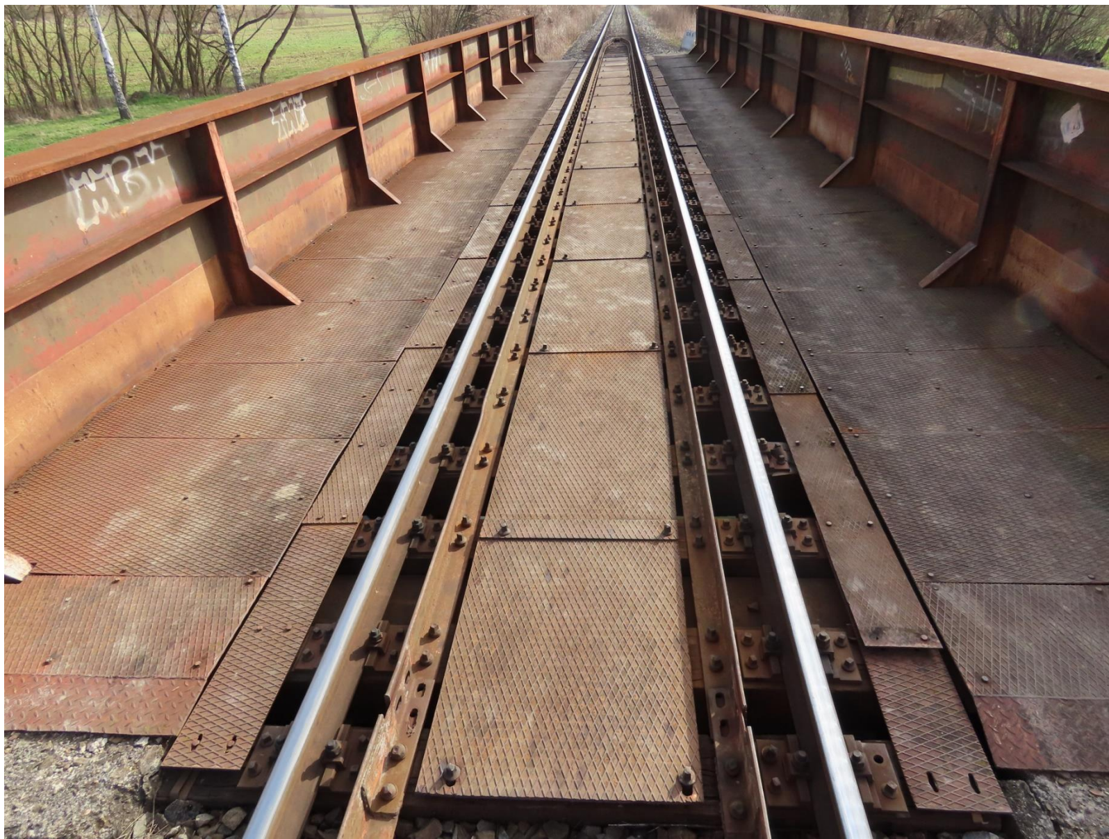
Most v km 108,580 pohled na nosnou konstrukci a podlahové plechy
