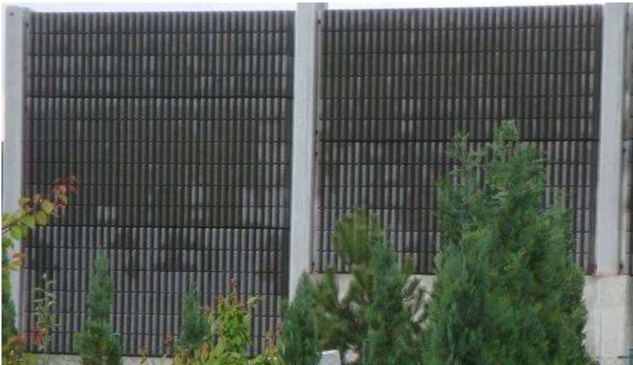
Obr. Realizace akustického obkladu s LA blokem
