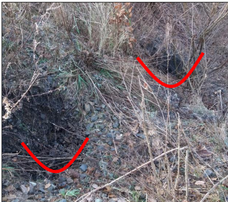
Obrázek č. 10: Km 48,200, pravá strana (ve směru staničení); Povrchové projevy tvorby kaveren uvnitř násypového tělesa; Foto autor
