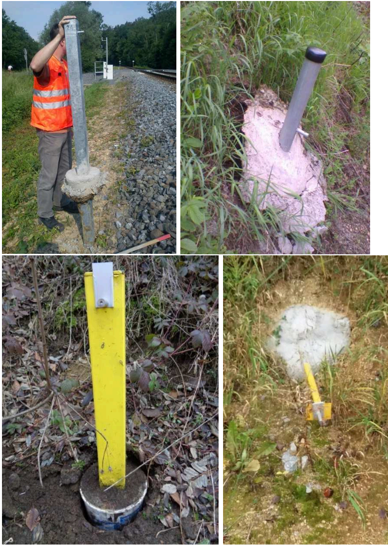
Obrázek 18 Ukázka neschválených, nestabilních a vyloženě nevhodných zajištění PPK
