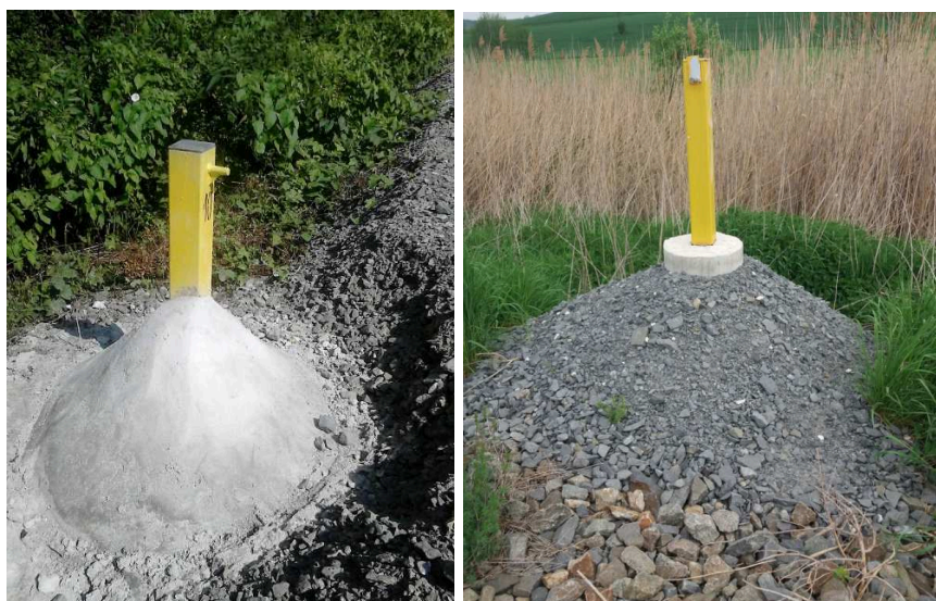
Obrázek 17 Řešení zhotovitele pro zvýšení stability zajišťovací značky
