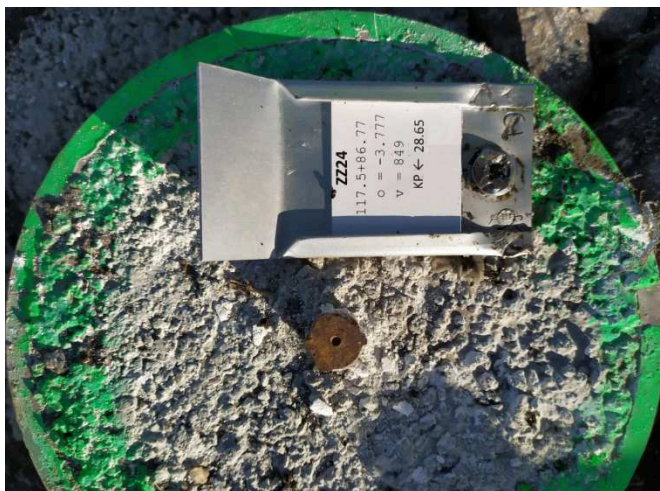
Obrázek 33 Roxor v betonovém bloku (základní odlehčená stabilizace)
