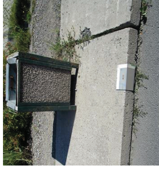
Obr. 2 - Zakrytí úchytů a prostupů betonových panelů (například, provizorní zastávky ND/NAD)
