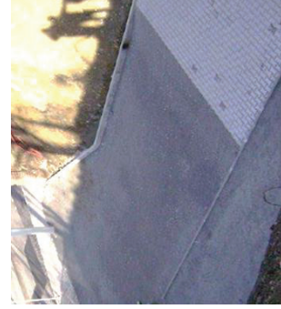
Obr. 1 - Dočasné zřízení komunikace - stanovený výškový rozdíl maximálně 20 mm (zámková dlažba, asfaltový, atd.)
