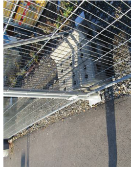
Obr. 11 - Patky oplocení v místě styku s komunikací jsou umístěny mimo provizorní komunikaci určenou cestujícím
