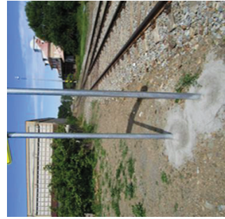
Obr. 5 - Stanovené pevné upevnění výstražné tabule – dočasného (provizorního) přechodu přes koleje
