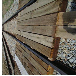
Obr. 4 - Provizorní přechod přes koleje - dřevěný
