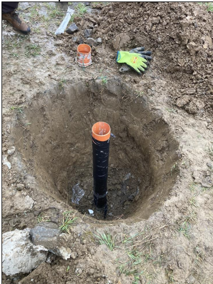
Obrázek 1 – přetěsnění vrtu HG6
