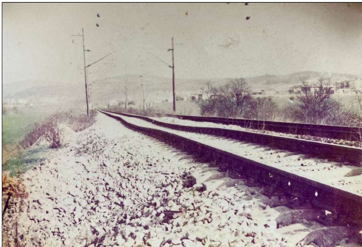
Obrázek č. 2 Nestabilní svah cca km 24,300 v roce 2003 (archiv. traťmistr Konečný)
