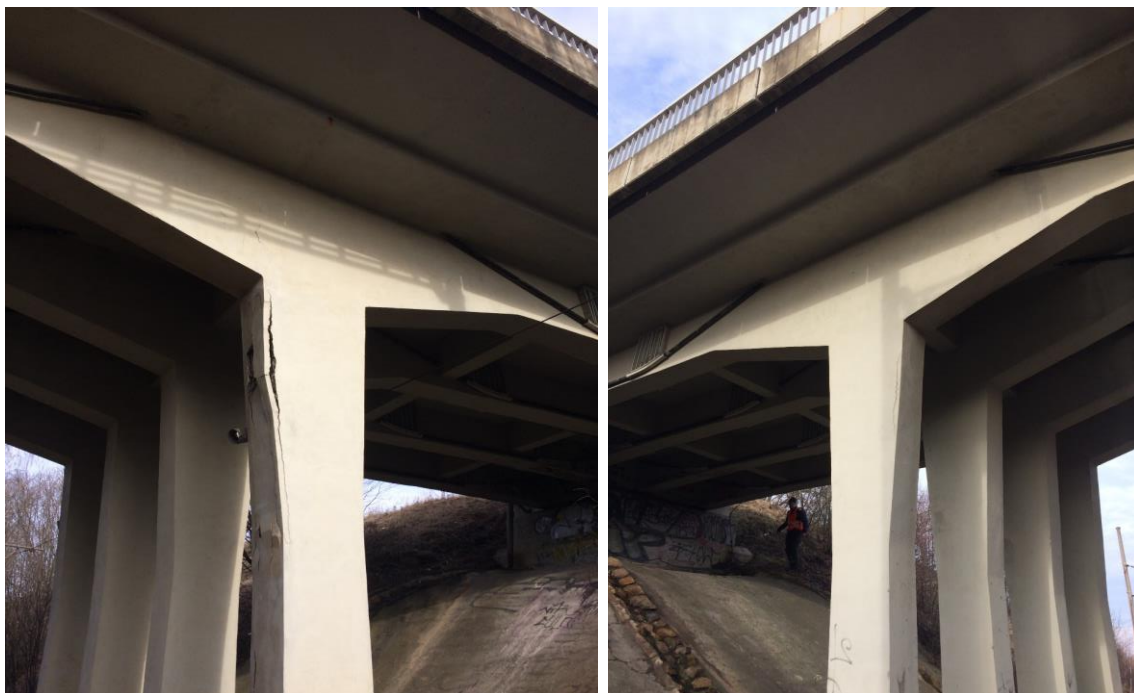
Pohled na porušení rámového rohu v pravé vnější stojce a pohled na levou stojku nadjezdu
