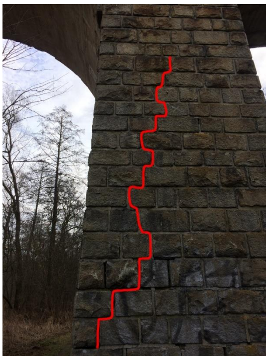
Vyznačení trhliny v kamenném zdivu pilíře P4
