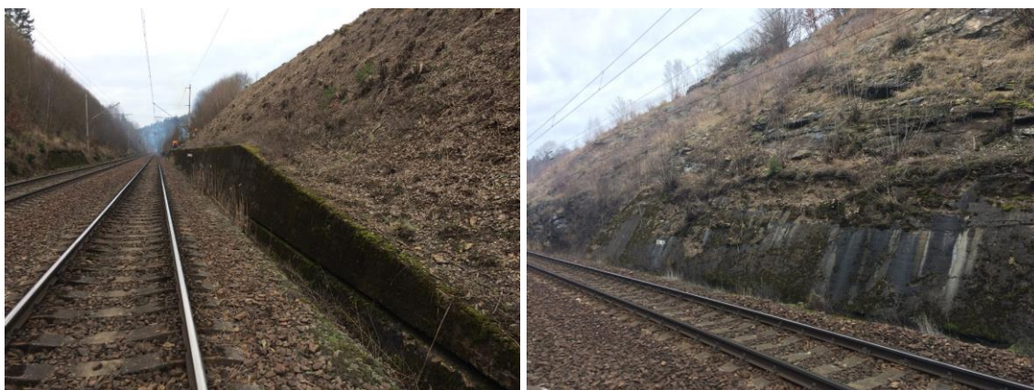
Společný pohled na zárubní zdi vpravo (91,565 – 91,911) i vlevo (km 91,598 – 91,617) trati a silně degradovaný koncový úsek zdi vpravo
