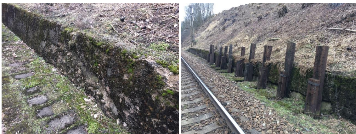
Pohled na degradovanou část zdi a provizorní zajištění podélné trhliny v posledním úseku
