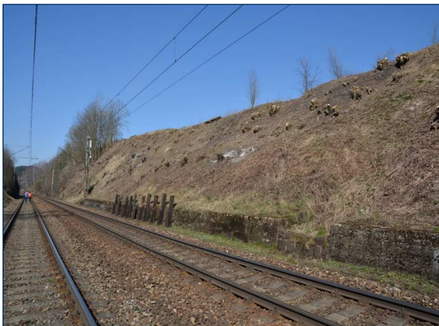
Obrázek 1 – zářezový svah vpravo trati km 90,800 – 90,850 se zárubní zdi
