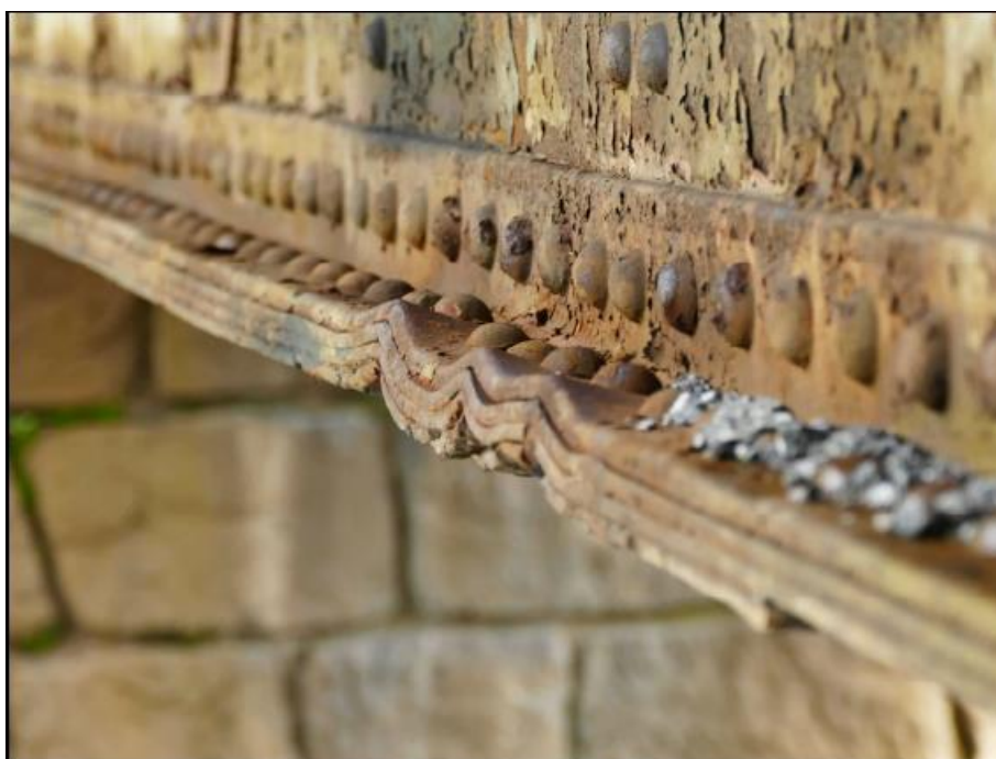
Obrázek č. 2 K 01 – hlavní nosník vpravo, deformace pásnice směrem vzhůru
