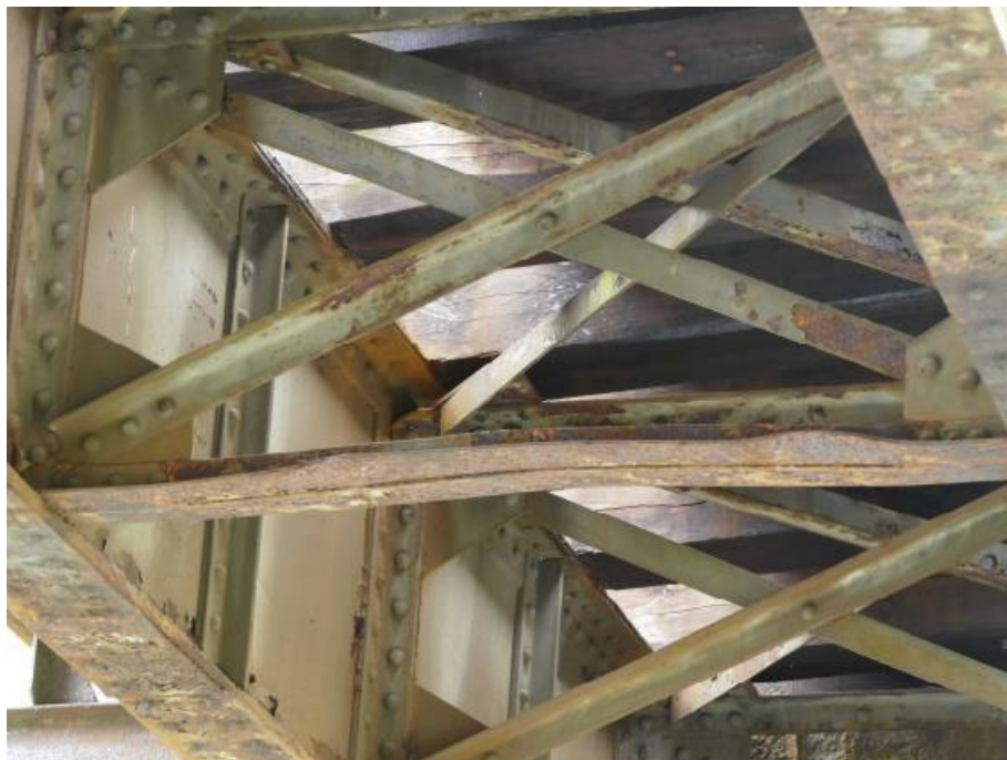
Obrázek č. 6 K 01 - příčné ztužení č. 5, dolní úhelník deformace v celé délce
