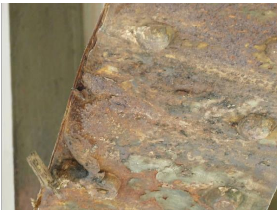
Obrázek č. 4 K 01 – hlavní nosník vpravo, tržená pásnice, vrypy, usmyknutý nýt.
