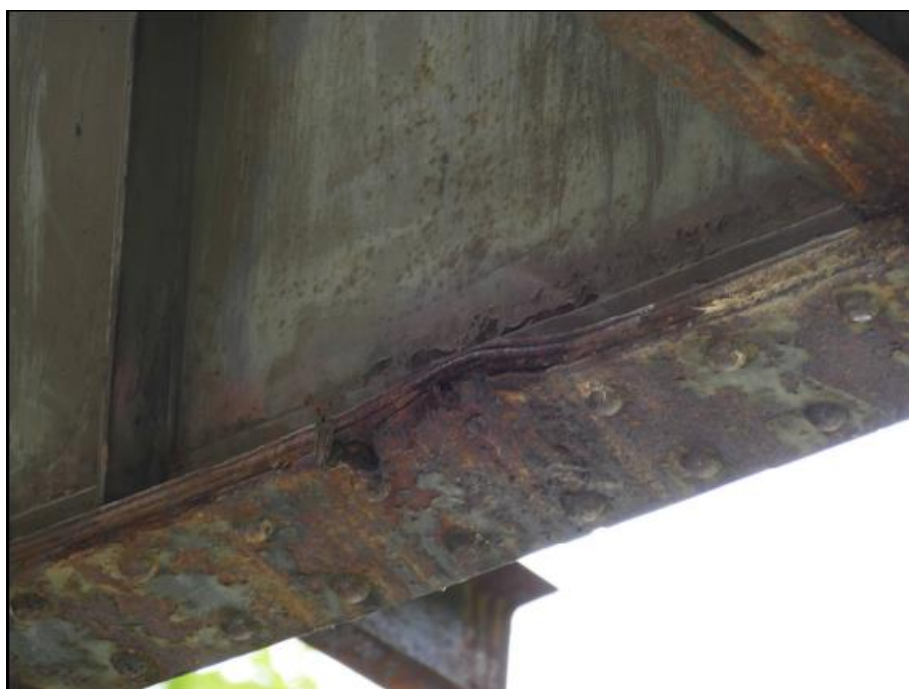
Obrázek č. 3 K 01 - hlavní nosník vpravo, dolní pásnice ve 3. poli, tržená pásnice.
