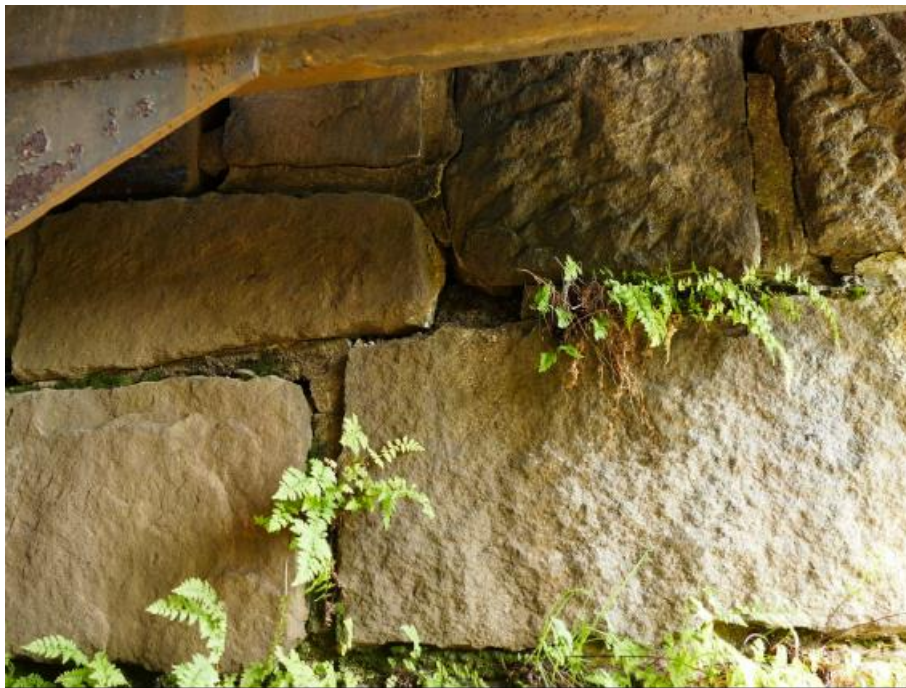
Obrázek č. 7 Opěra O 01 – závěrná zeď vlevo, vypadané spárování, mírné průsaky.
