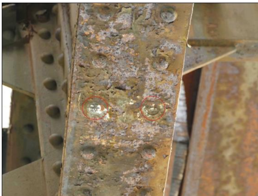
Obrázek č. 5 K 01 – hlavní nosník vlevo, dolní pásnice v 5. poli, usmyknutý nýty.
