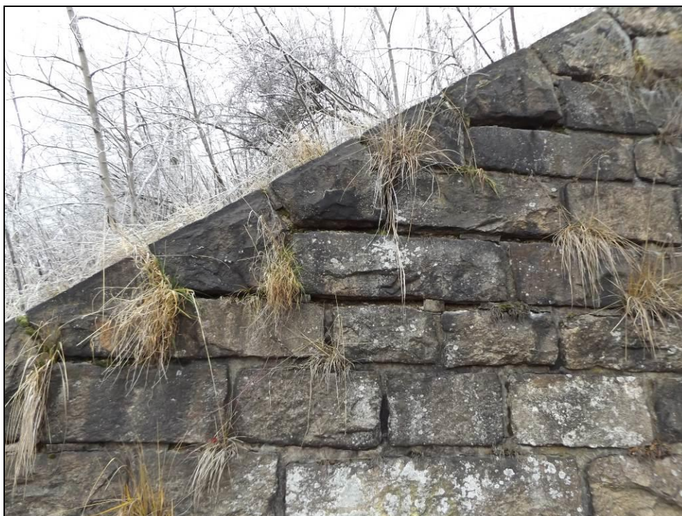
Obr. č. 12 - detailní pohled na vypadané vyspárování a rozvolněné kamenivo ve svrchní části vybraného křídla objektu
