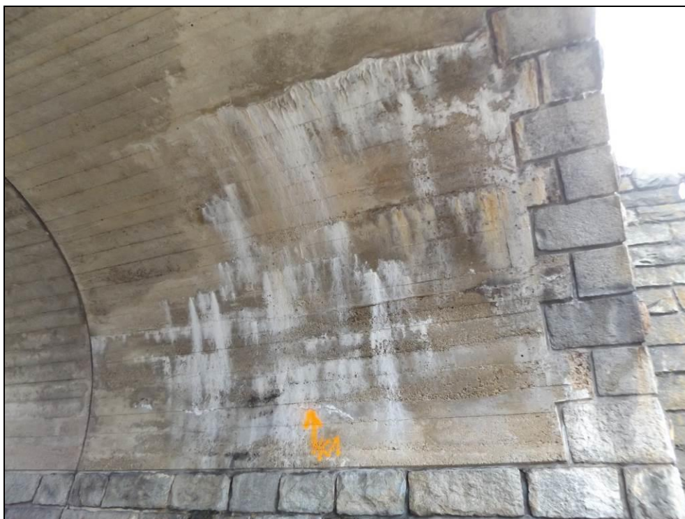
Obr. č. 10 - detailní pohled na průsaky nosnou konstrukcí objektu
