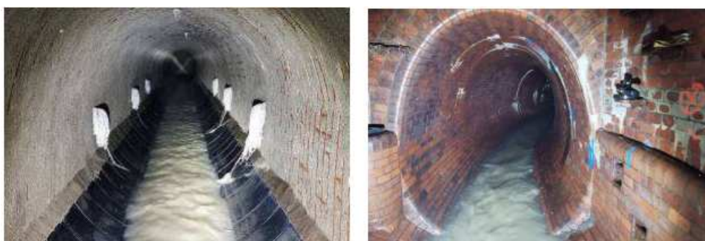
Obr. 5 a 6: vlevo sanovaný profil o rozměrech 1750/1950 mm, vpravo profil HP1800/2250ZCI
