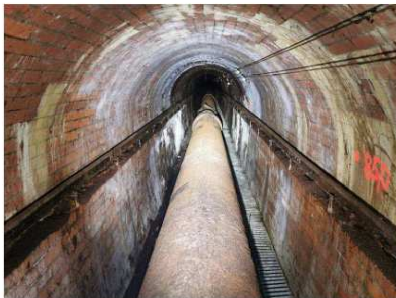
Obr. 3: fotografie profilu vodovodního kolektoru 2100/1300ZCI pod Masarykovým nádražím
