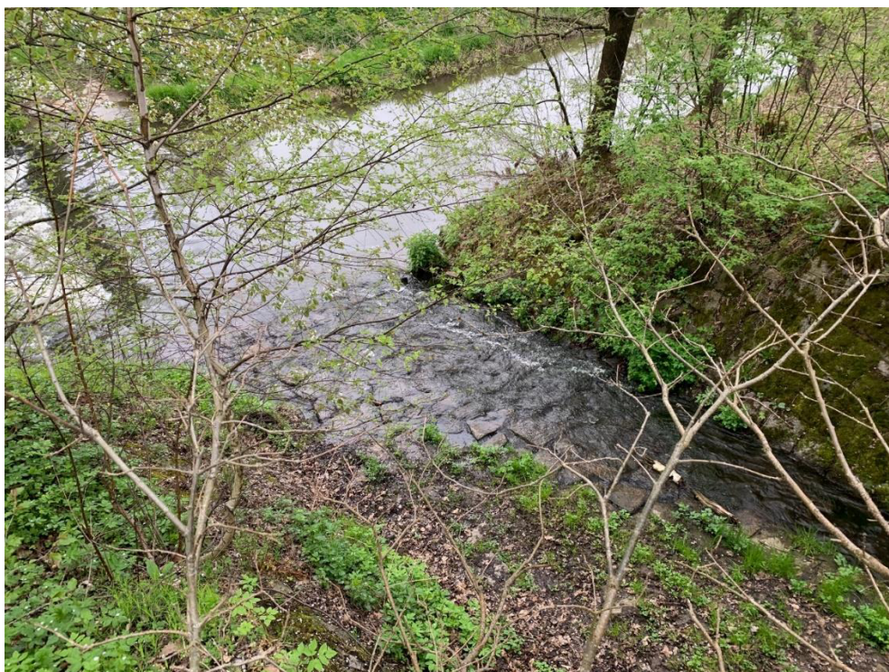
Obr. 44: Dlažbou zpevněné místo vtoku Dluhoveského potoka do Sázavy.
