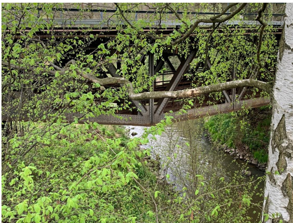
Obr. 40: Železniční most v ev. km 109,495 – pohled do podmostí. Šířka mostu i přirozený charakter břehu Sázavy splňuje parametry pro migraci širokého spektra živočichů.
