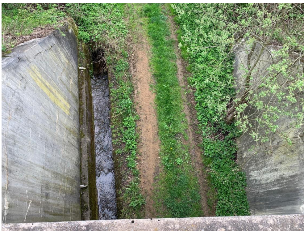
Obr. 24: Železniční most v ev. km 106,229. Je patrný protékající vodoteč v samostatném umělém korytu a nezpevněná polní komunikace.
