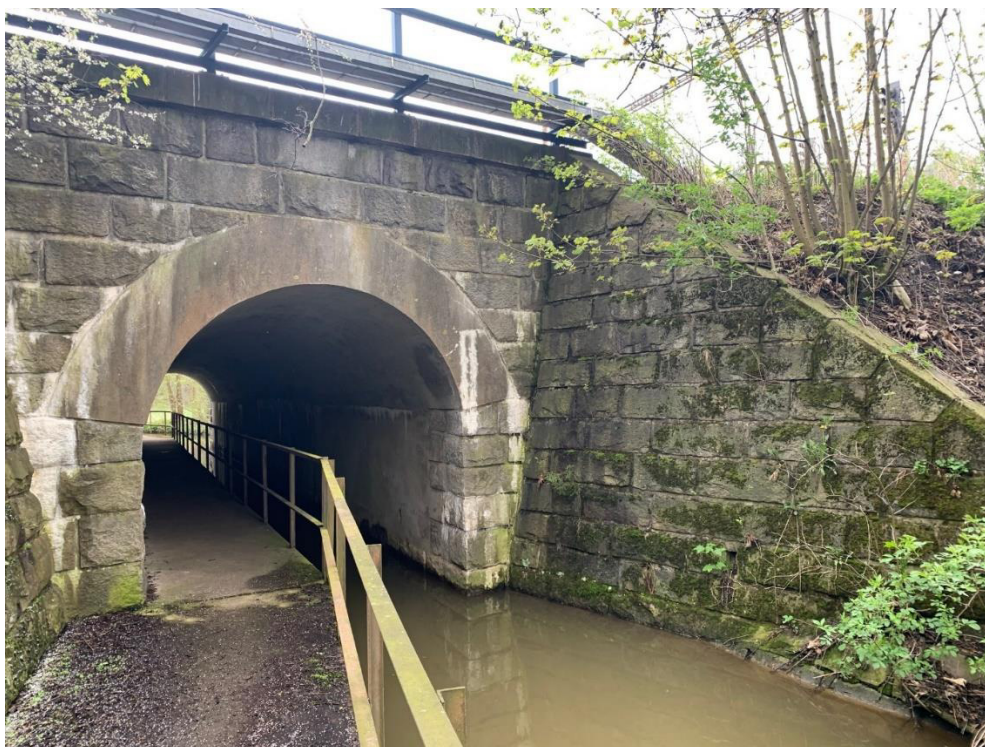
Obr. 8: Železniční most v ev. km 103,535, je patrný oddělený průtok potoka a stezka pro pěší.
