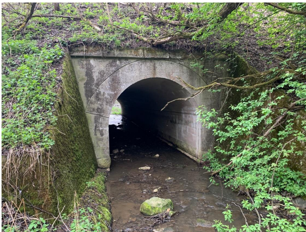
Obr. 20: Železniční most v ev. km 105,520. Celou šířku podmostí vyplňuje protékající vodní tok (Doberský potok). Bez suchých migračních lavic je migrace suchozemských živočichů limitována.
