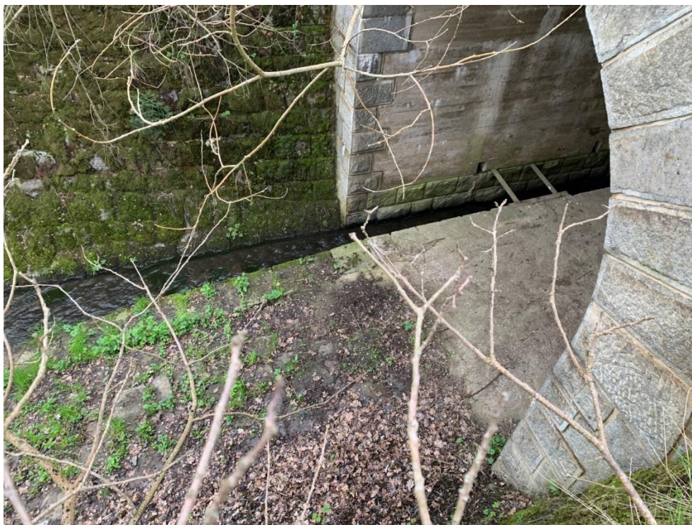
Obr. 43: Železniční most v ev. km 109,982. Na snímku je patrné zpevněné podmostí a Dluhoveský potok protékající v odděleném kanálku.
