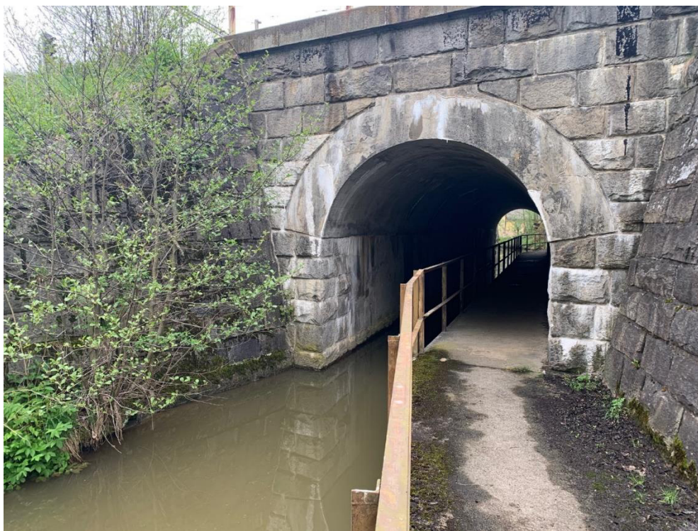
Obr. 7: Železniční most v ev. km 103,535, je patrný oddělený průtok potoka a stezka pro pěší.
