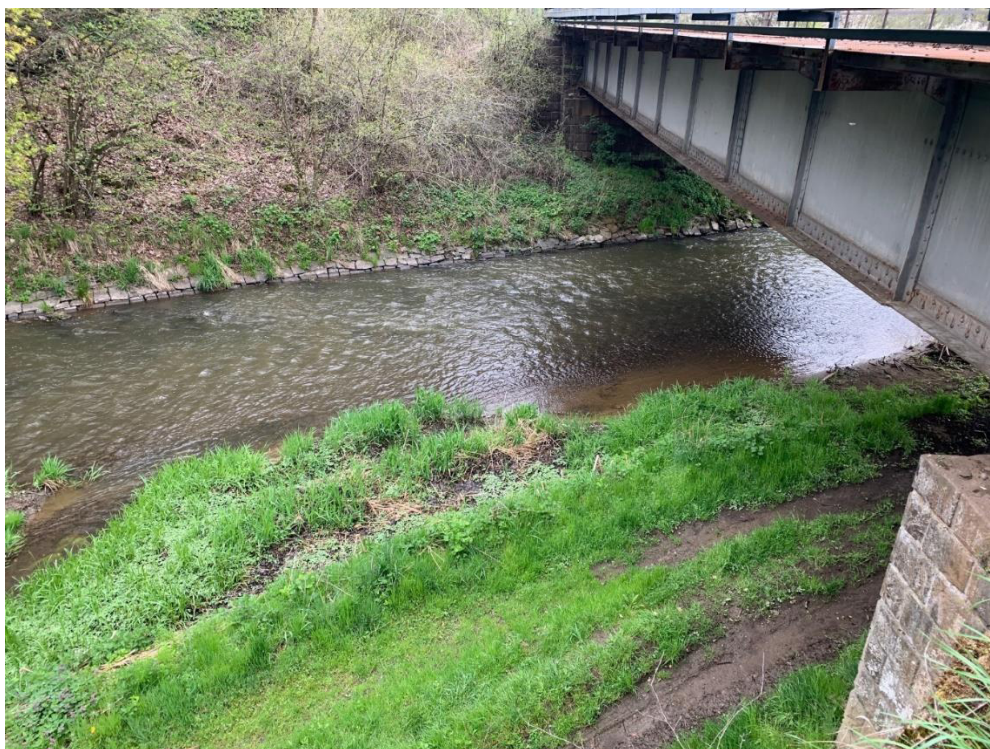
Obr. 27: Železniční most v ev. km 107,032, překonávající tok Sázavy. Je patrný zpevněný břeh, ale i bahnité náplavy na protilehlé straně a břehová lavice v podmostí.
