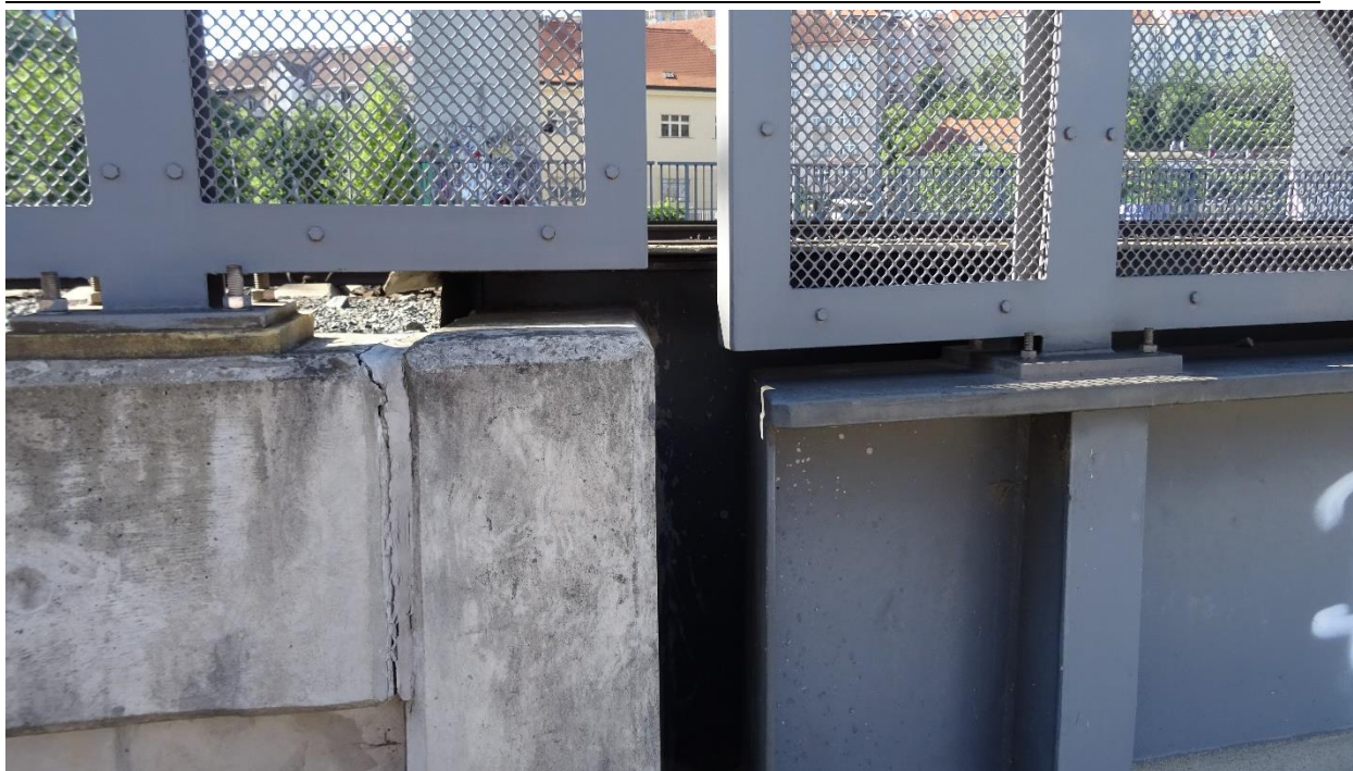
Obrázek 7: Detail napojení stávající zdi na závěrnou zídku mostu
