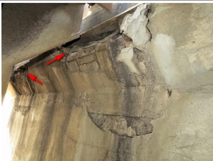
Foto č. 8 O 02 - závěrná zed' za K 05, vylomení horní hrany pod oběma kolejnicemi.
