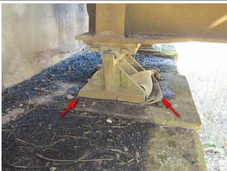
Foto č. 3 K 06 - uložení nad O 02 vlevo, sešikmení ložiska, vypodložení ložiska se vytlačuje ven.
