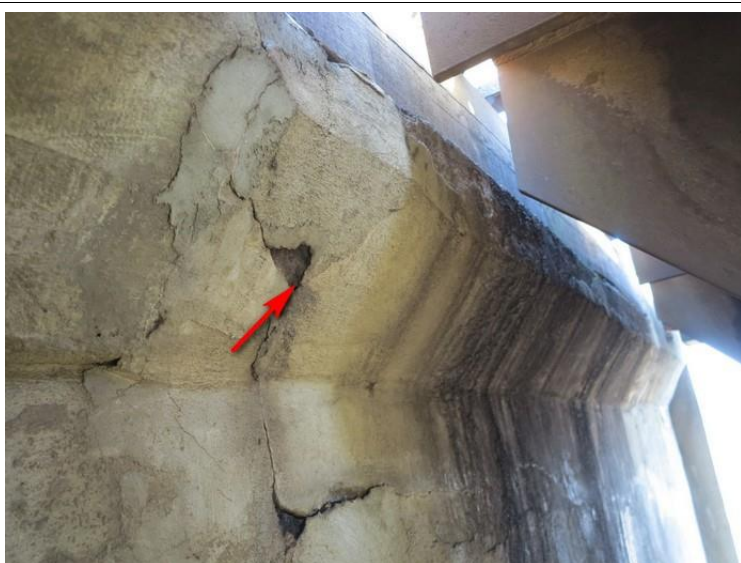
Foto č. 9 O 02 - závěrná zed' za K 06, vzdutá povrchová úprava, začíná odpadávat, od zatékání vlhkosti.
