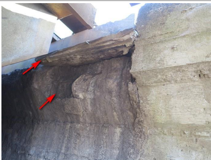
Foto č. 4 O 01 - závěrná zed' za K 01, vytačený plastbeton pod pozednicí a vylomení horní hrany (návaznost na poruchy v železničním svršku v předpolí).
