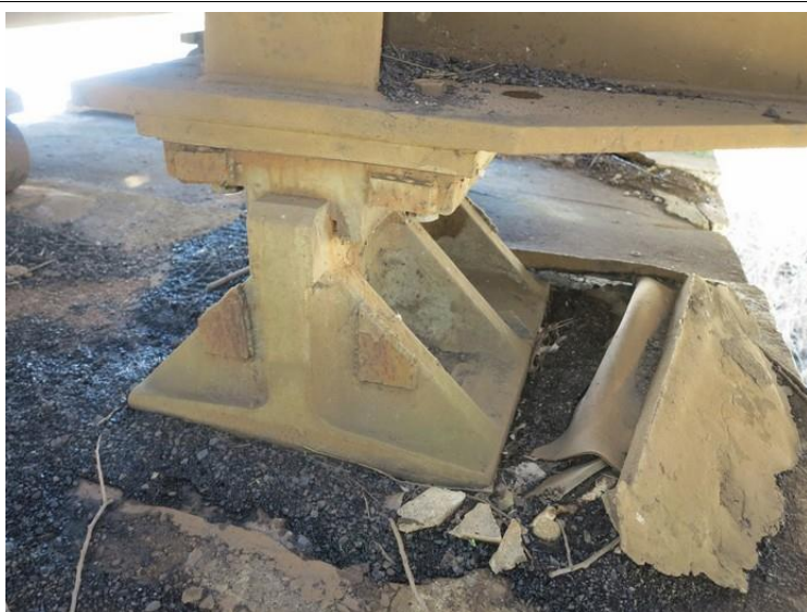
Foto č. 2 K 02 - uložení nad P 01 vlevo, obetonování chybí, není dostatečně zajištěno proti posunu, vypodložení ložiska se vytlačuje ven.
