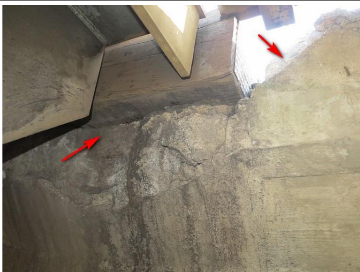
Foto č. 5 O 01 - závěrná zed' za K 02, vylomení horní hrany, včetně degradace betonu v horní části (u pozednice).
