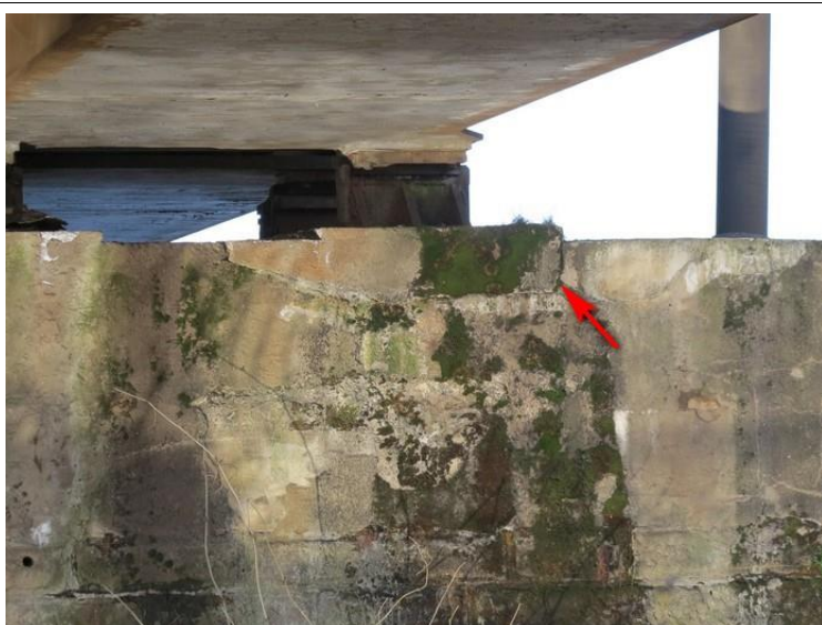
Foto č. 6 P 01 - úložný práh pod K 02 vpravo, trhlinami odpojená horní hrana, při rozvíjení poruchy dojde k odpadnutí hrany.
