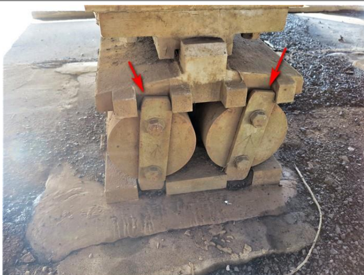
Foto č. 1 K 01 - uložení nad P 01 vpravo, sešikmení válců (rozdílné).
