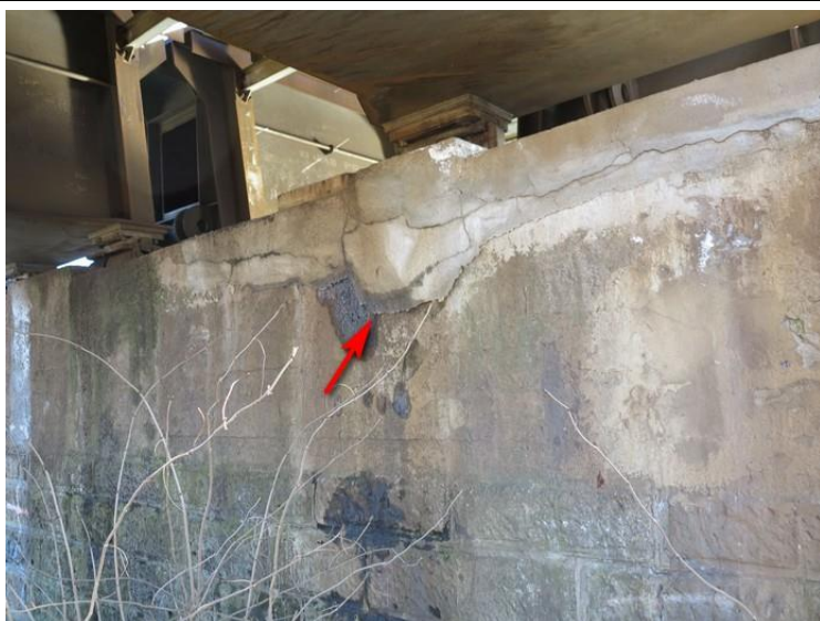
Foto č. 7 P 02 - úložný práh pod K 05, rozvíjení poruch v sanované hraně od zatékající vlhkosti, hrozí odpadnutí hrany až k ložisku vpravo.
