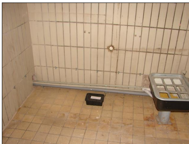
Foto 106 a 107: Místnost C.N1.24, soc. zařízení, ŽB skelet, výplňové zdivo, zamalované luxfery ve stěně, plastové potrubí, obklad z dřevotřískových desek, keramický obklad, keramická dlažba na podlaze
