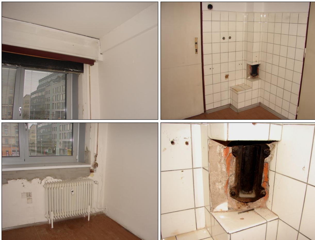
Foto 299 - 302: Místnost C.N2.16, ŽB skelet, výplňové zdivo, keramický obklad, na podlaze PVC, hliníková okna, litinový svod
