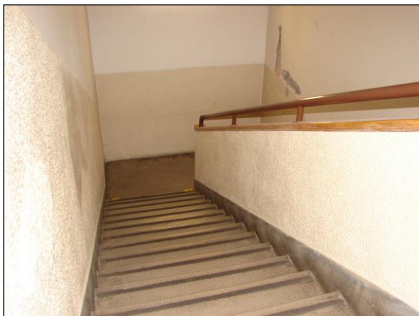
Foto 75 a 76: Místnost C.N1.34, pošta, schodiště do 2.NP, ŽB skelet, výplňové zdivo, olejový nátěr, teraco na schodišťových stupních a podestách, dřevěné madlo
