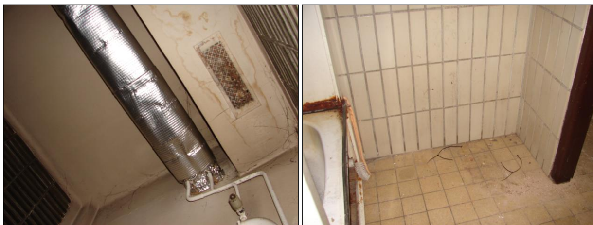
Foto 115 a 116: Místnost C.N1.21, soc. zařízení, ŽB skelet, výplňové zdivo, luxfery ve stěně, keramický obklad, keramická dlažba na podlaze, ocelová mřížka na větracím otvoru v průvlaku, ocelové potrubí s izolací z minerální vlny obalené kartonem a Al fólií
