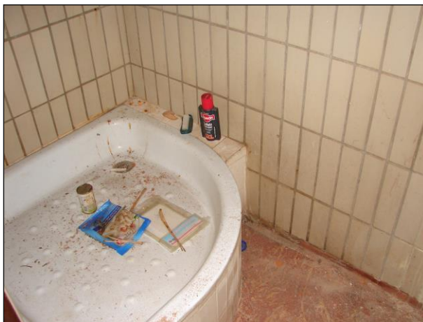
Foto 119 a 120: Místnost C.N1.19, soc. zařízení, ŽB skelet, výplňové zdivo, luxfery ve stěně, keramický obklad, PVC na podlaze, ocelové potrubí s izolací z minerální vlny obalené kartonem a Al fólií
