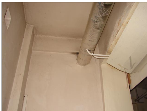
Foto 176 a 177: Místnost C.N1.01, zadní část místnosti, ŽB skelet, výplňové zdivo, kazetový podhled pod stropem, PVC a keramická dlažba na podlaze
