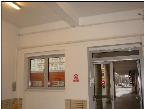
Foto 205 a 206: Místnost B.N1.23, hala, ŽB skelet, výplňové zdivo, keramický obklad, na podlaze kamenná dlažba, hliníkové okno a dveře
