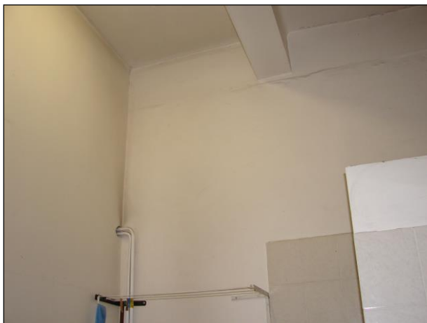
Foto 137 a 138: Místnost C.N1.12, soc. zařízení, ŽB skelet, výplňové zdivo, keramický obklad a keramická dlažba na podlaze
