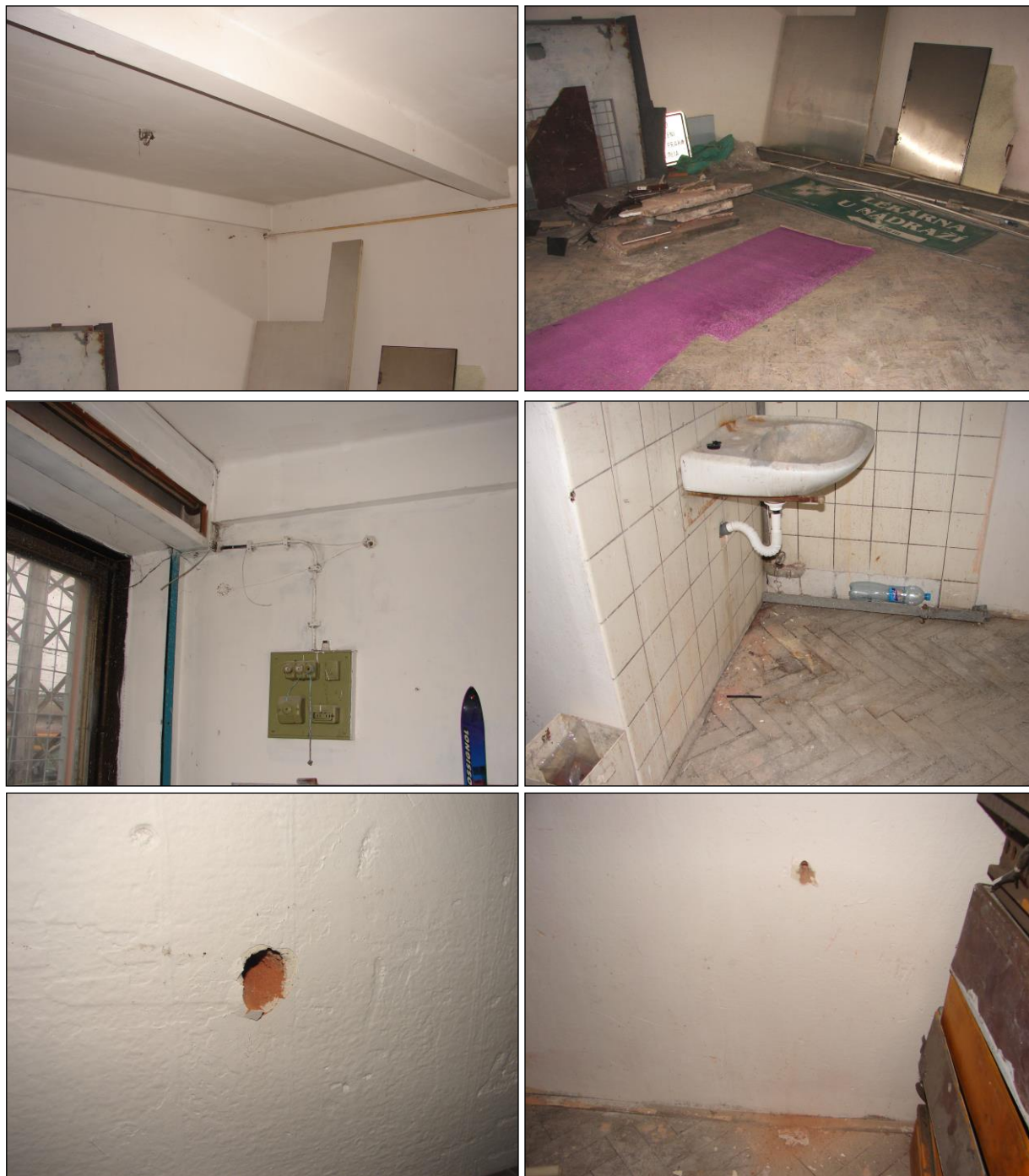
Foto 253 - 258: Místnost C.N2.30, ŽB skelet, výplňové zdivo, na podlaze parkety, el. rozvody na plastové desce, kovové okno a kovové dveře, keramický obklad, vrtané sondy pro ověření výplňového zdíva
