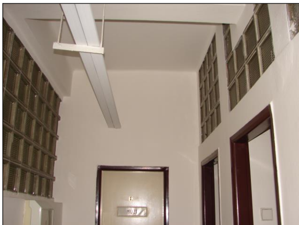
Foto 324 a 325: Místnost C.N2.10, WC, ŽB skelet, výplňové zdivo, luxfery, pod stropem plechová lávka, na podlaze keramická dlažba
