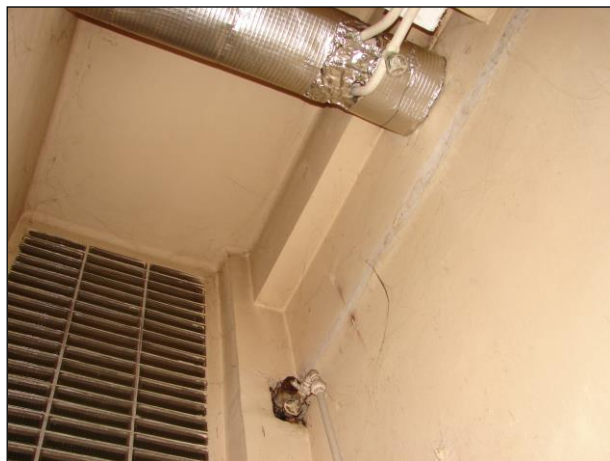
Foto 119 a 120: Místnost C.N1.19, soc. zařízení, ŽB skelet, výplňové zdivo, luxfery ve stěně, keramický obklad, PVC na podlaze, ocelové potrubí s izolací z minerální vlny obalené kartonem a Al fólií
