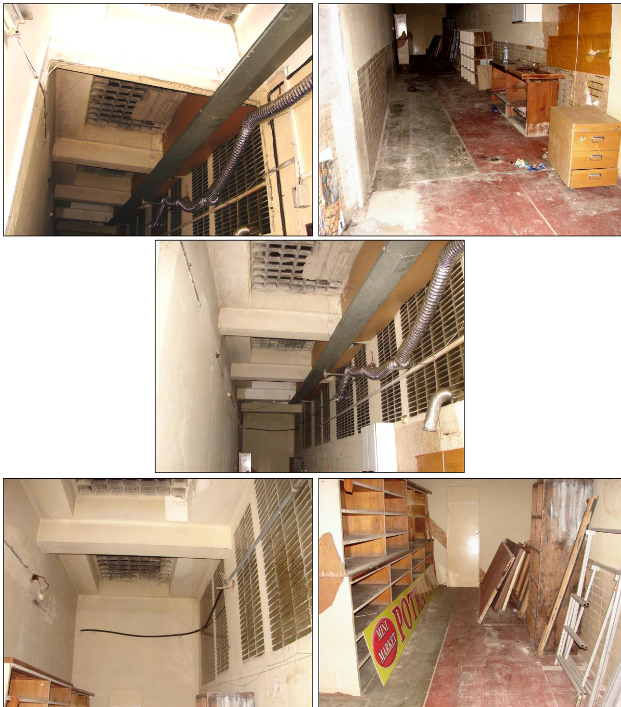
Foto 123 - 127: Místnost C.N1.17, ŽB skelet, výplňové zdivo, luxfery ve stropě i ve stěně, keramický obklad, PVC na podlaze, odvětrávací potrubí z Al fólie
