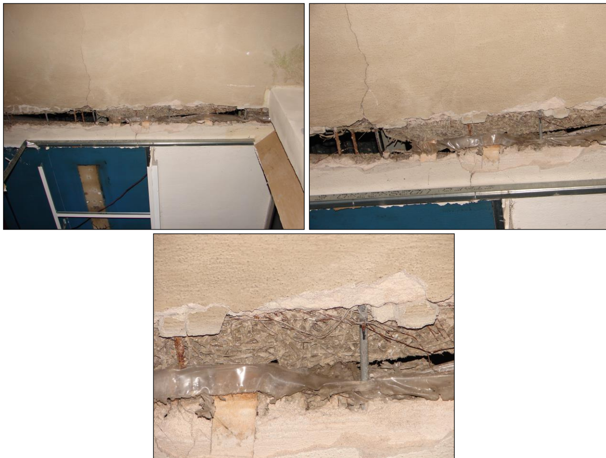
Foto 240 - 242: Místnost B.N1.35A , hranice posuzované části budovy, podhledu stropu z omítnutého heraklitu (částečně opatřený modrou malbou)
