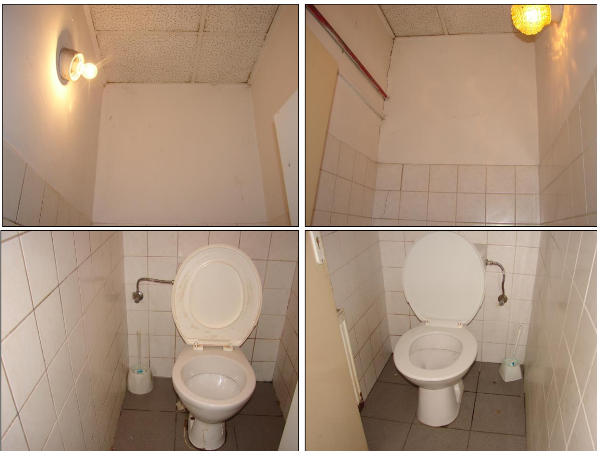
Foto 39 - 42: Místnost C.N1.43, WC v místnosti řidičů DP, ŽB strop s kazetovým podhledem, zděné stěny, keramický obklad, keramická dlažba na podlaze
