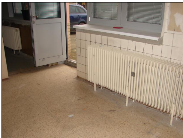
Foto 279 - 282: Místnost C.N2.22, ŽB skelet, výplňové zdivo, keramický obklad, hliníková okna a dveře, na podlaze PVC, plastové potrubí
