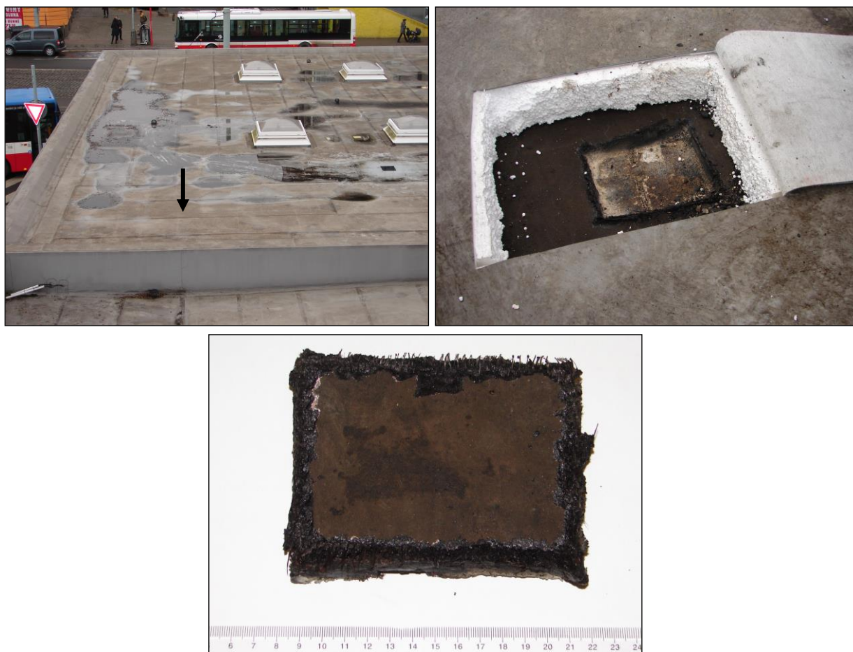
Foto 435 - 437: Střecha, baldachýn, přístavba z 80. let 20. stol., místo sondy a odběru vzorku, sonda a vzorek hydroizolačního souvrství (viz foto 397 - 406), 4x hydroizolační asfaltový pás s tkaninou na bázi přírodních polymerů (všechny pásy souvrství jsou shodné) přítomnost azbestu (plnivo): pozitivní, chryzotil - identifikace (A), kap. 5.3
