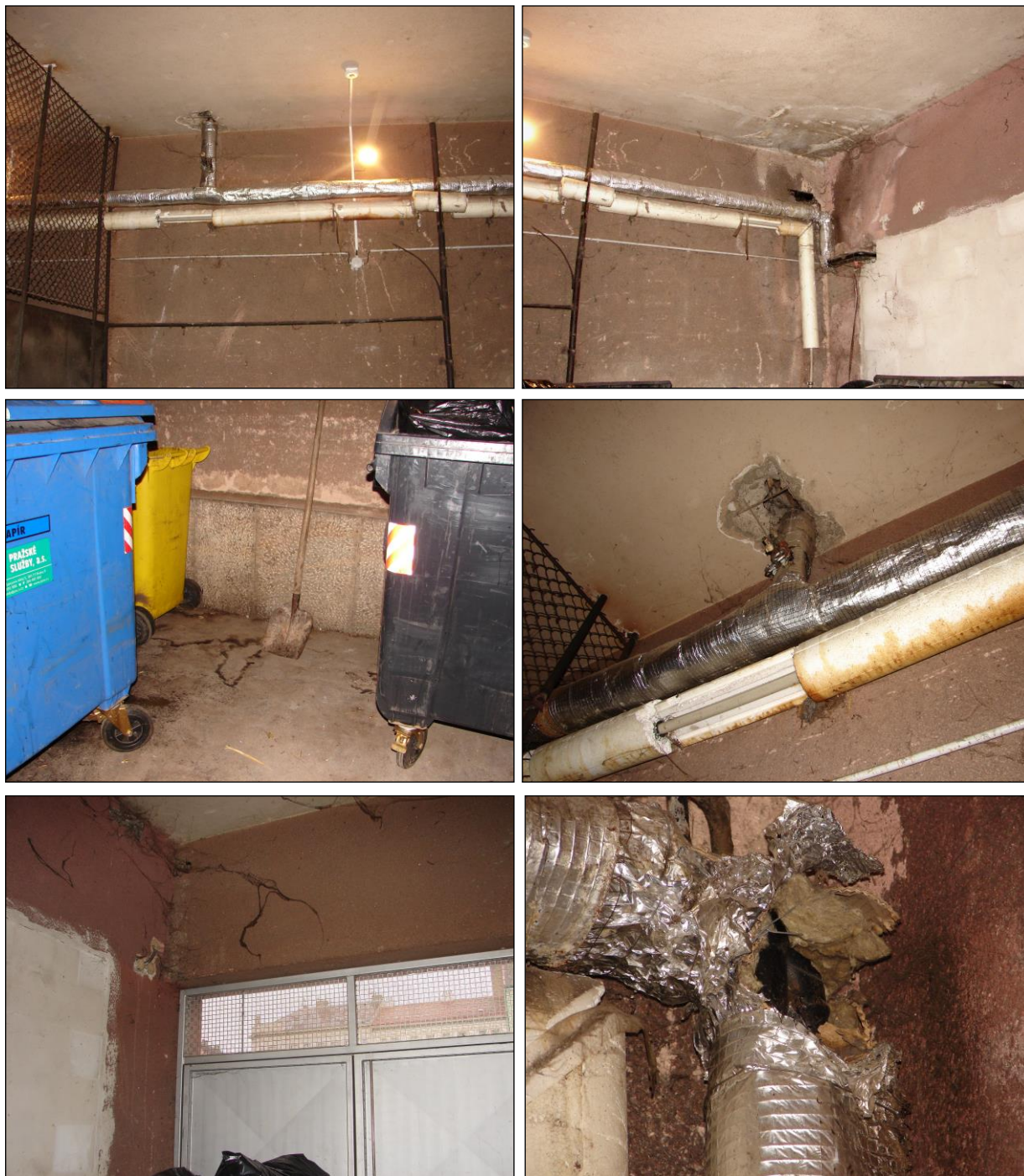
Foto 43 - 48: Místnost C.N1.42, umístěny plastové kontejnery na odpad, ŽB strop, zděné stěny, podlaha betonová, pískovcový sokl, ocelové drátěné mříže a plechová přepážka, ocelová vrata, ocelové potrubí s izolací z minerální vlny obalené kartonem a Al fólií a plastové potrubí izolované polystyrenem
