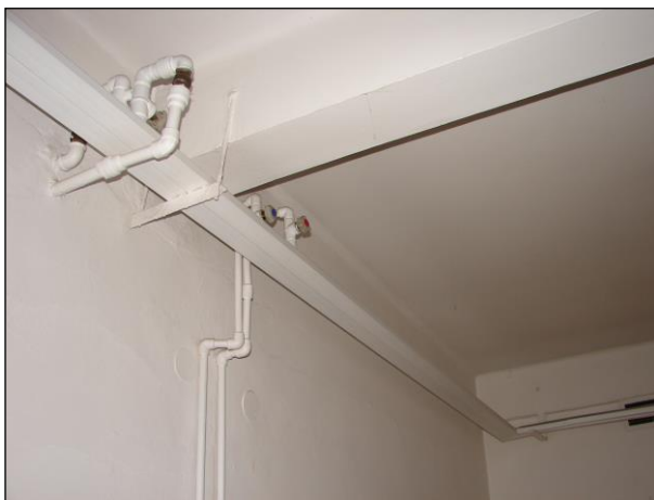
Foto 279 - 282: Místnost C.N2.22, ŽB skelet, výplňové zdivo, keramický obklad, hliníková okna a dveře, na podlaze PVC, plastové potrubí
