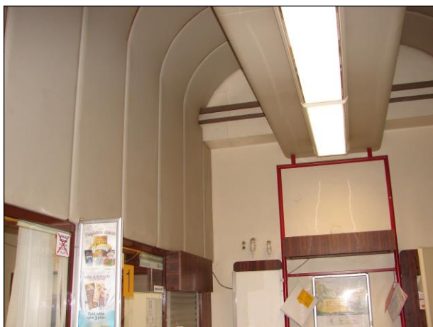
Foto 77 a 78: Místnost C.N1.33, pošta, hala s přepážkami pro veřejnost, ŽB skelet, výplňové zdivo, keramická dlažba na podlaze, koženkové obložení
