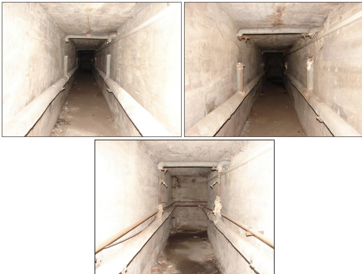
Foto 1 - 3: Technologický kanál B.PI.22, pohledy od místa vstupu (Příloha 1.1) směrem k severu, na foto dole kanál pokračuje pravoúhlým zalomením vpravo, konstrukce kanálu je železobetonová monolitická, podlaha betonová
