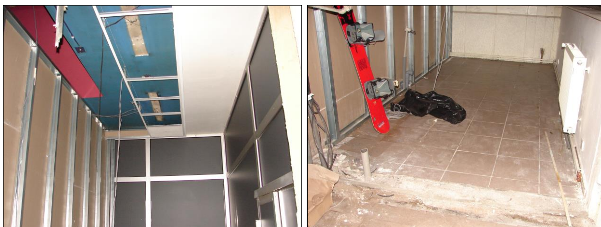
Foto 238 a 239: Místnost B.N1.35A, sádkartonová příčka, podhled z omítnutého heraklitu (částečně opatřený modrou malbou), keramická dlažba na podlaze
