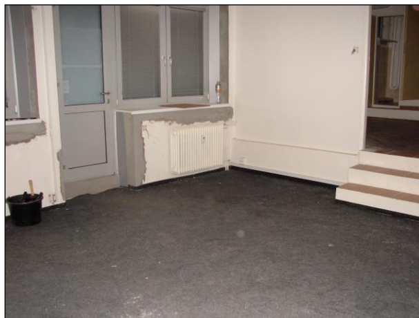
Foto 342 a 343: Místnost C.N2.03, ŽB skelet, výplňové zdivo, hliníková okna a dveře, na podlaze koberec, na schodišťových stupních keramická dlažba
