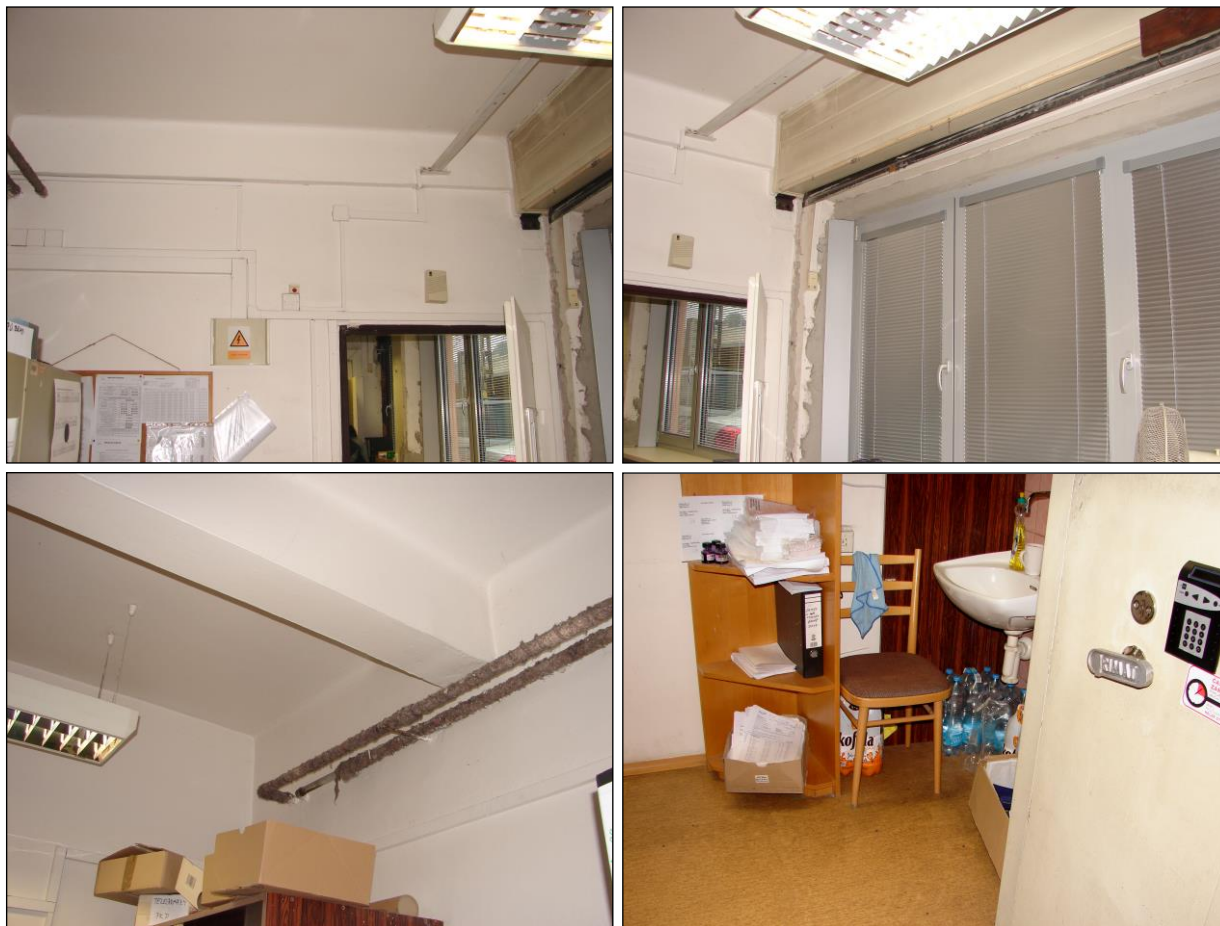
Foto 263 - 266: Místnost C.N2.27, pošta, ŽB skelet, výplňové zdivo, na podlaze PVC, hliníkové okno, ocelové potrubí obalené textilií, el. rozvody v plastové skříni a lištách
