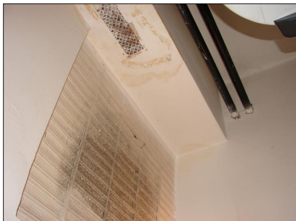
Foto 98 a 99: Místnost C.N1.27, pošta, sprcha, ŽB skelet, výplňové zdivo, luxfery ve stěně, kovová větrací mřížka, plastové potrubí, keramický obklad, keramická dlažba na podlaze
