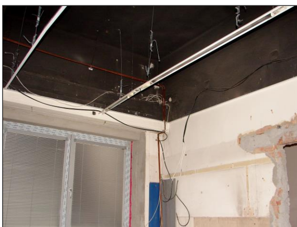
Foto 84 a 85: Místnost C.N1.31, pošta, prostor za přepážkami, ŽB skelet, výplňové zdivo, hliníkové okno
