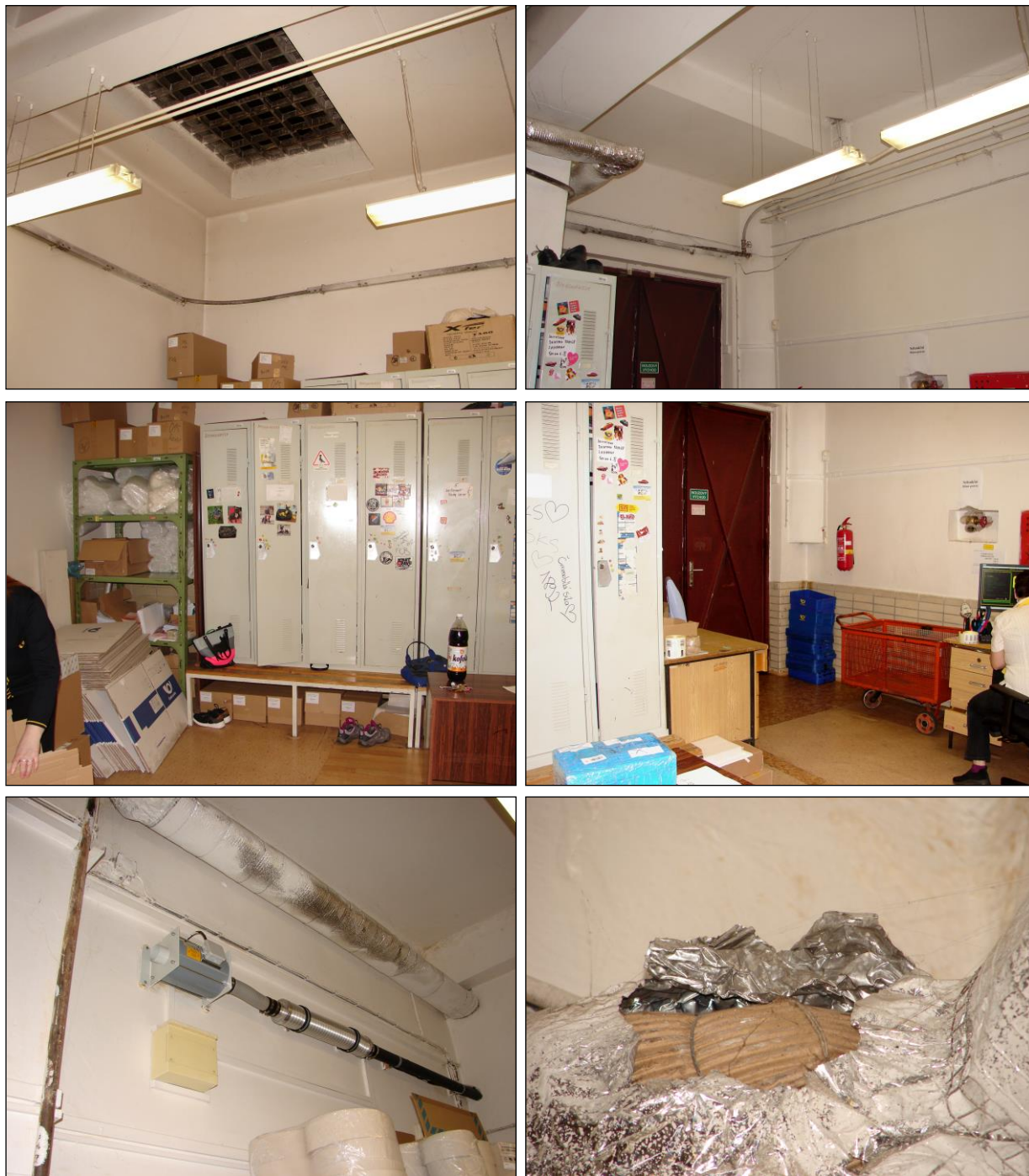
Foto 65 - 70: Místnost C.N1.38, ŽB skelet, výplňové zdívko, luxfery ve stropě, PVC na podlaze, ocelová vrata, ocelové potrubí s izolací z minerální vlny obalené kartonem a Al fólií
