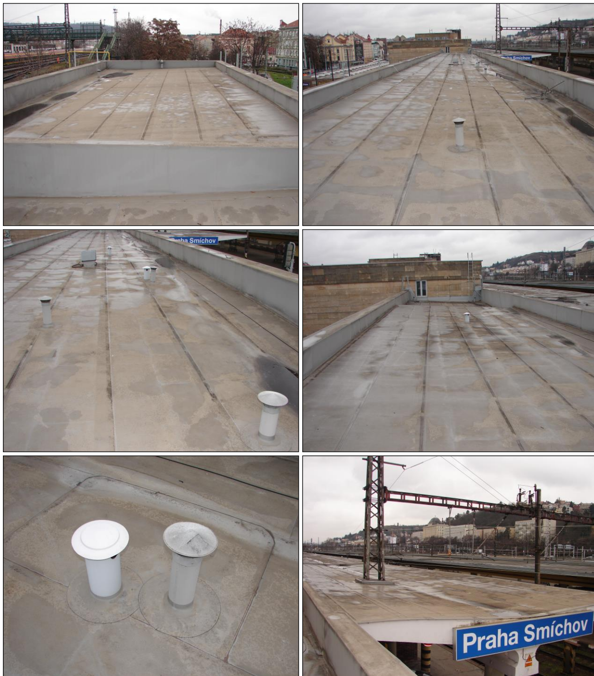
Foto 379 - 384: Střecha, severní křídlo, svrchní hydroizolační vrstva z PVC fólie, fólie je přetažená na atiky, odvětrání kanalizace z plastu, příp. plechu, (skladba střešního pláště viz další strana), na zastřešení nástupiště rovněž hydroizolační PVC fólie
