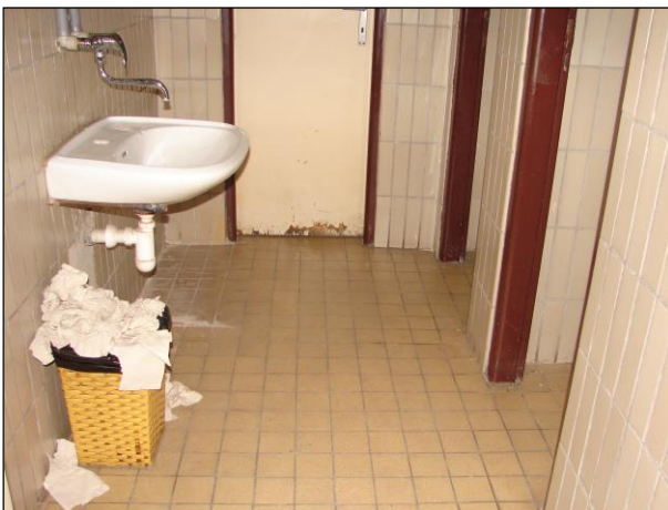
Foto 324 a 325: Místnost C.N2.10, WC, ŽB skelet, výplňové zdivo, luxfery, pod stropem plechová lávka, na podlaze keramická dlažba
