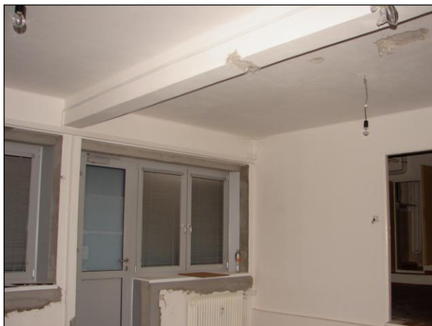
Foto 342 a 343: Místnost C.N2.03, ŽB skelet, výplňové zdivo, hliníková okna a dveře, na podlaze koberec, na schodišťových stupních keramická dlažba
