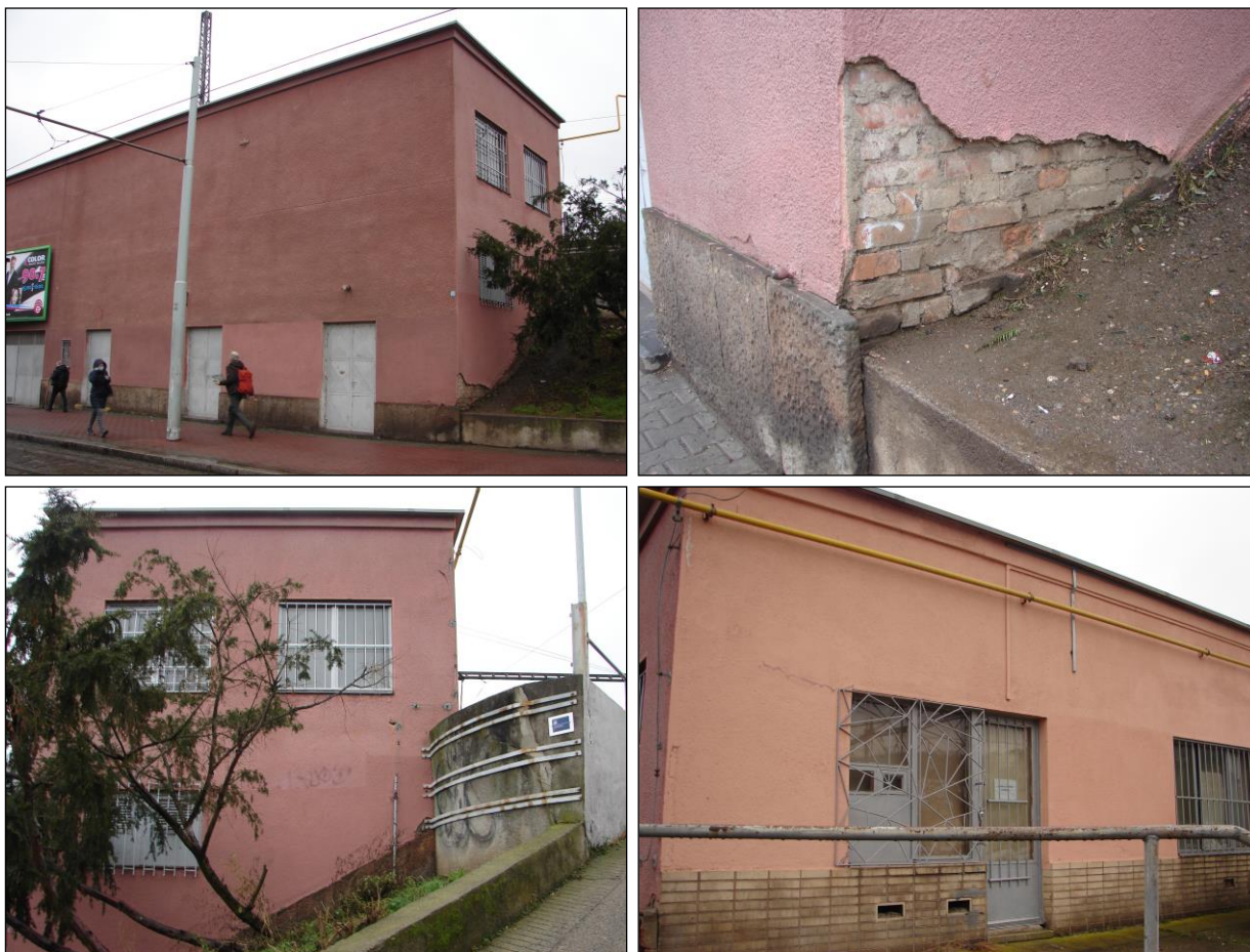
Foto 348 - 351: Fasáda, severní křídlo, zděná část, zdivo z CP, směrem do ulice sokl z pískovce a ocelová vrata, na štítové stěně částečně sokl z pískovce, ke štítové stěně přiléhá oblouková betonová opěrná zeď s navazující betonovou nájezdovou rampou, směrem ke kolejišti na soklu keramický obklad, ocelová okna a dveře a ocelové plynové potrubí
