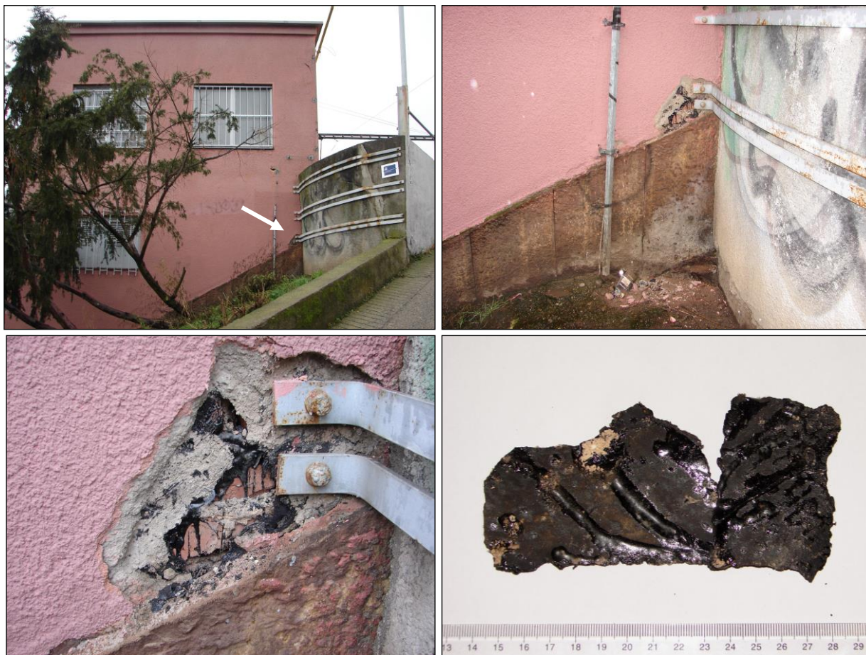
Foto 423 - 426: 1.NP, izolace spodní stavby, štítová stěna, místo odběru vzorku, sonda a vzorek, hydroizolace je tvořena asfaltovou lepenkou a litým asfaltem, přítomnost azbestu: negativní - identifikace (B), (C), kap. 5.3
