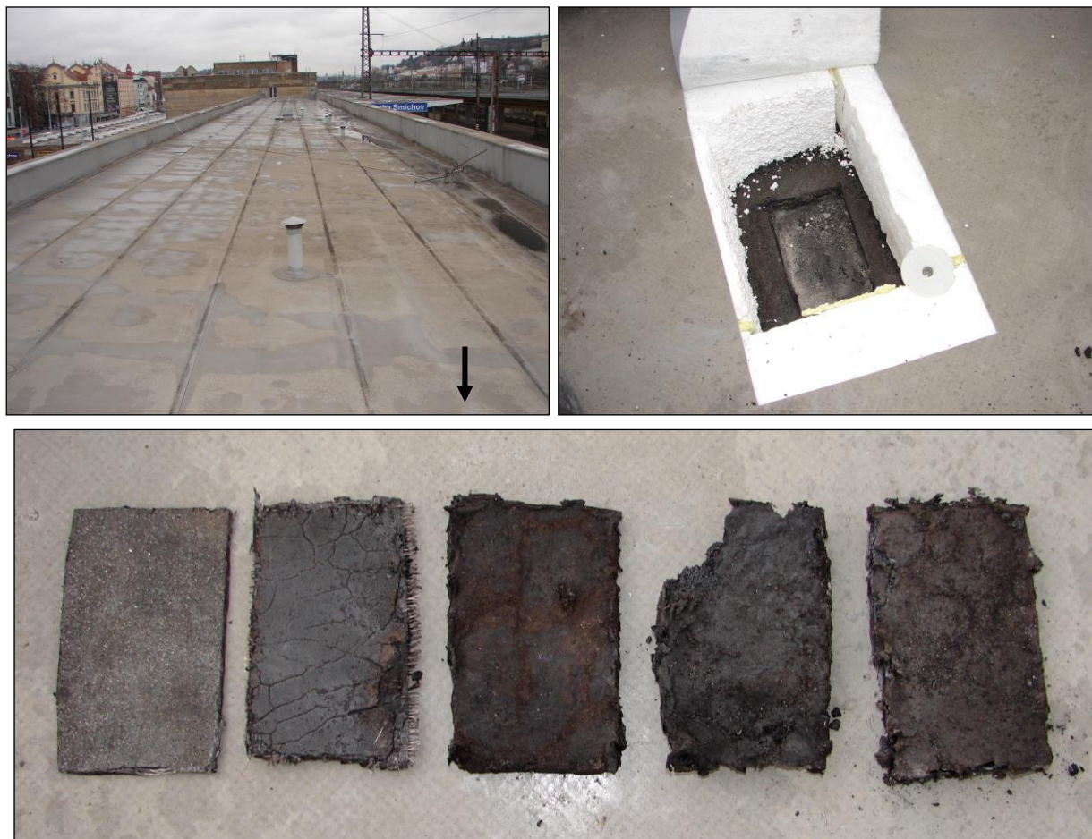
Foto 427 - 429: Střecha, severní křídlo, místo sondy a odběru vzorku, sonda a vzorky hydroizolačního souvrství (viz foto 379 - 390), 1x hydroizolační asfaltový pás novodobý, 1x hydroizolační asfaltový pás původní a 3x asfaltová lepenka s asfaltovými nátěry, zleva je pořadí vrstev shora dolů, (vzorky viz další strana)
