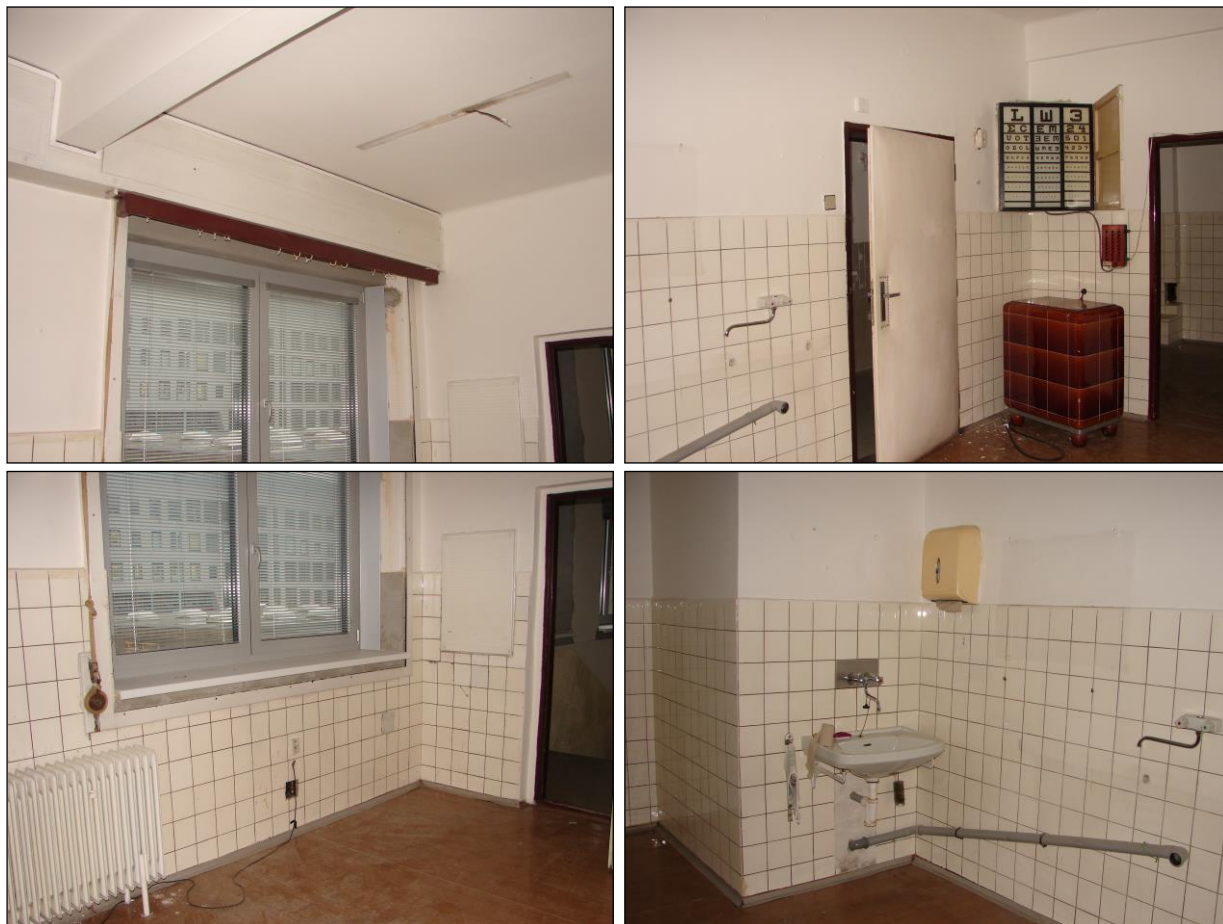
Foto 303 - 306: Místnost C.N2.15, ŽB skelet, výplňové zdivo, keramický obklad, na podlaze PVC, hliníková okna, plastové potrubí
