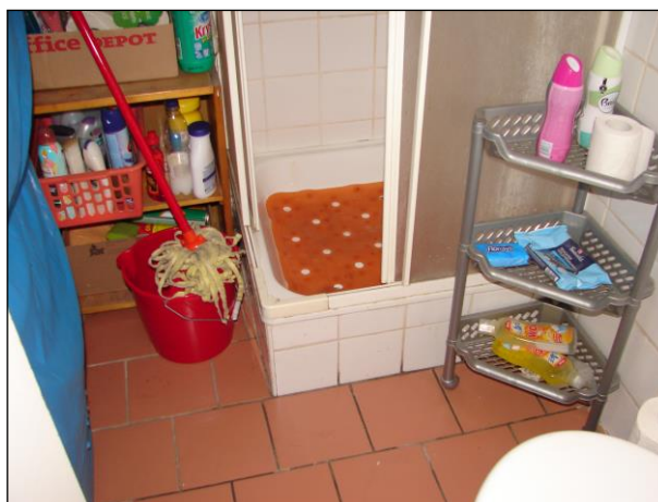
Foto 217 a 218: Místnost B.N1.29 , ŽB skelet, výplňové zdivo, keramický obklad, keramická dlažba na podlaze, ve stropě plastová průchodka
