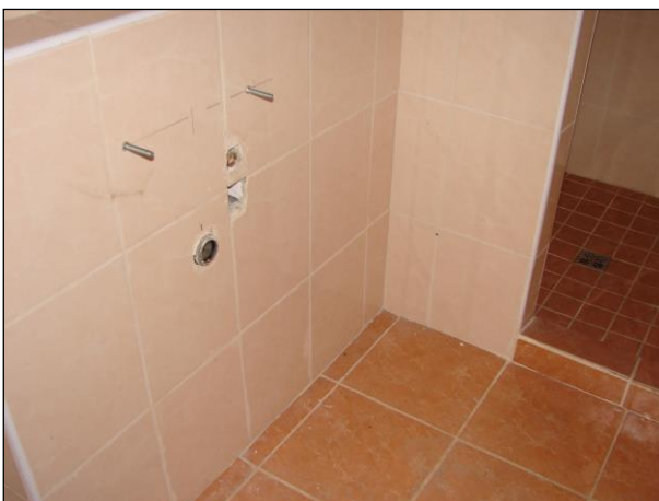
Foto 338 a 339: Místnost C.N2.05, umývárna a sprcha, ŽB skelet, výplňové zdivo, keramický obklad, na podlaze keramická dlažba
