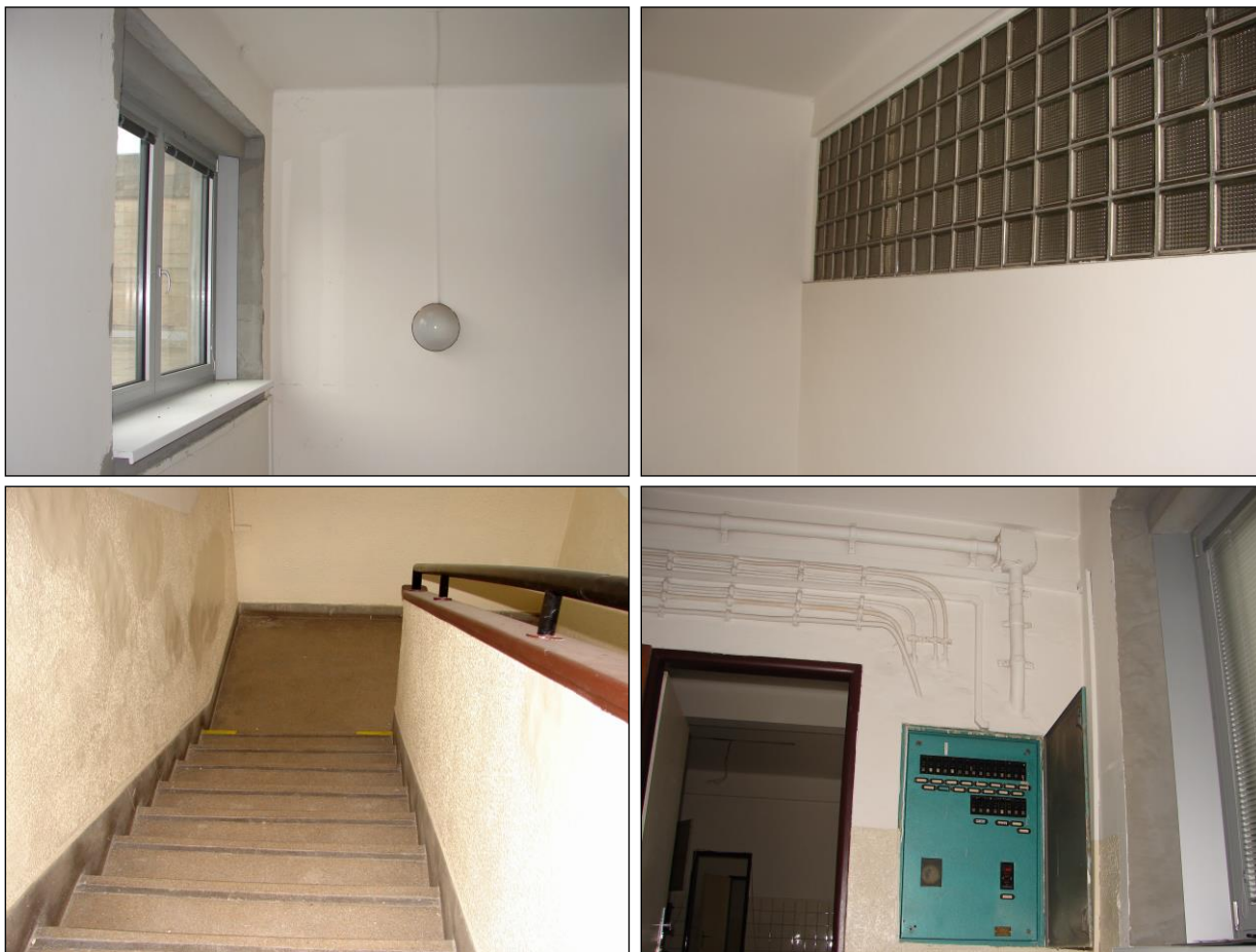
Foto 318 - 321: Místnost C.N2.12, schodiště do 1.NP, ŽB skelet, výplňové zdivo, luxfery, hliníková okna, na podestách a schodišťových stupních teraco, ocelové madlo, el. rozvody v plechové skříni
