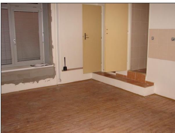
Foto 340 a 341: Místnost C.N2.04, ŽB skelet, výplňové zdivo, hliníkové okno, ocelové potrubí, na podlaze PVC, na schodišťovém stupni keramická dlažba
