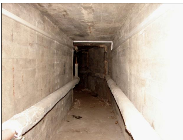
Foto 10 a 11: Technologický kanál B.P1.22, na foto vlevo povlovné zalomení kanálu u místa vstupu (Příloha 1.1), na foto vpravo přímý úsek kanálu, který pokračuje pravoúhlým zalomením vpravo (viz další foto)
