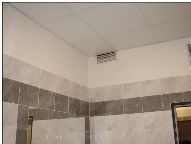
Foto 159 a 160: Místnost C.N1.06, umývárna na veřejném WC ženy, ŽB skelet, výplňové zdivo, keramický obklad, keramická dlažba na podlaze, pod stropem kazetový podhled
