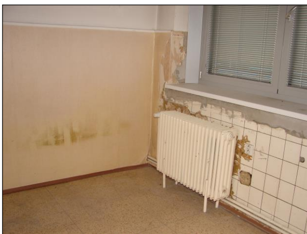
Foto 283 a 284: Místnost C.N2.21, ŽB skelet, výplňové zdivo, keramický obklad, hliníkové okno, na podlaze PVC
