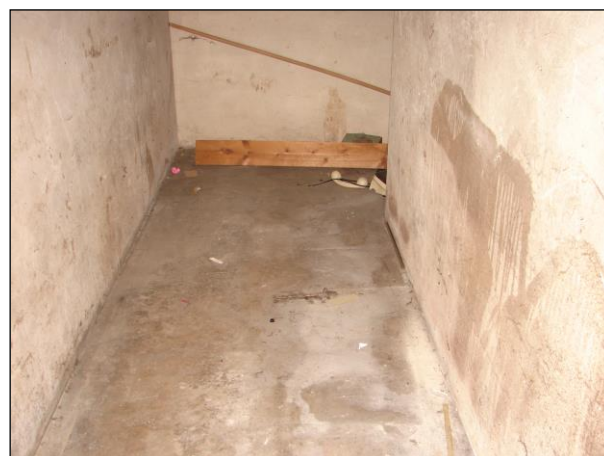
Foto 161 a 162: Místnost C.N1.05, místnost pod schodištěm do 2.NP, ŽB skelet, zděné stěny ŽB schodišťové rameno, betonová podlaha
