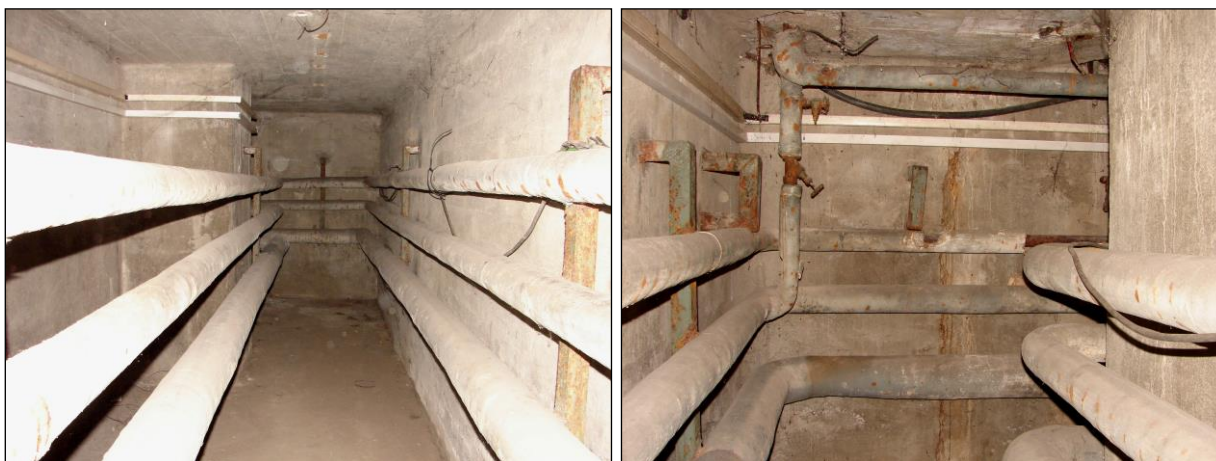
Foto 14 a 15: Technologický kanál B.P1.22 , na foto vlevo přímý úsek kanálu podél výtahu, který pokračuje pravoúhlým zalomením vlevo, na foto vpravo krátký úsek kanálu, který pokračuje pravoúhlým zalomením vpravo a pokračuje pod centrální část výpravní budovy
