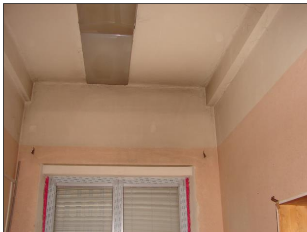
Foto 96 a 97: Místnost C.N1.28, ŽB skelet, výplňové zdivo, hliníkové okno, PVC na podlaze a pod ním parkety
