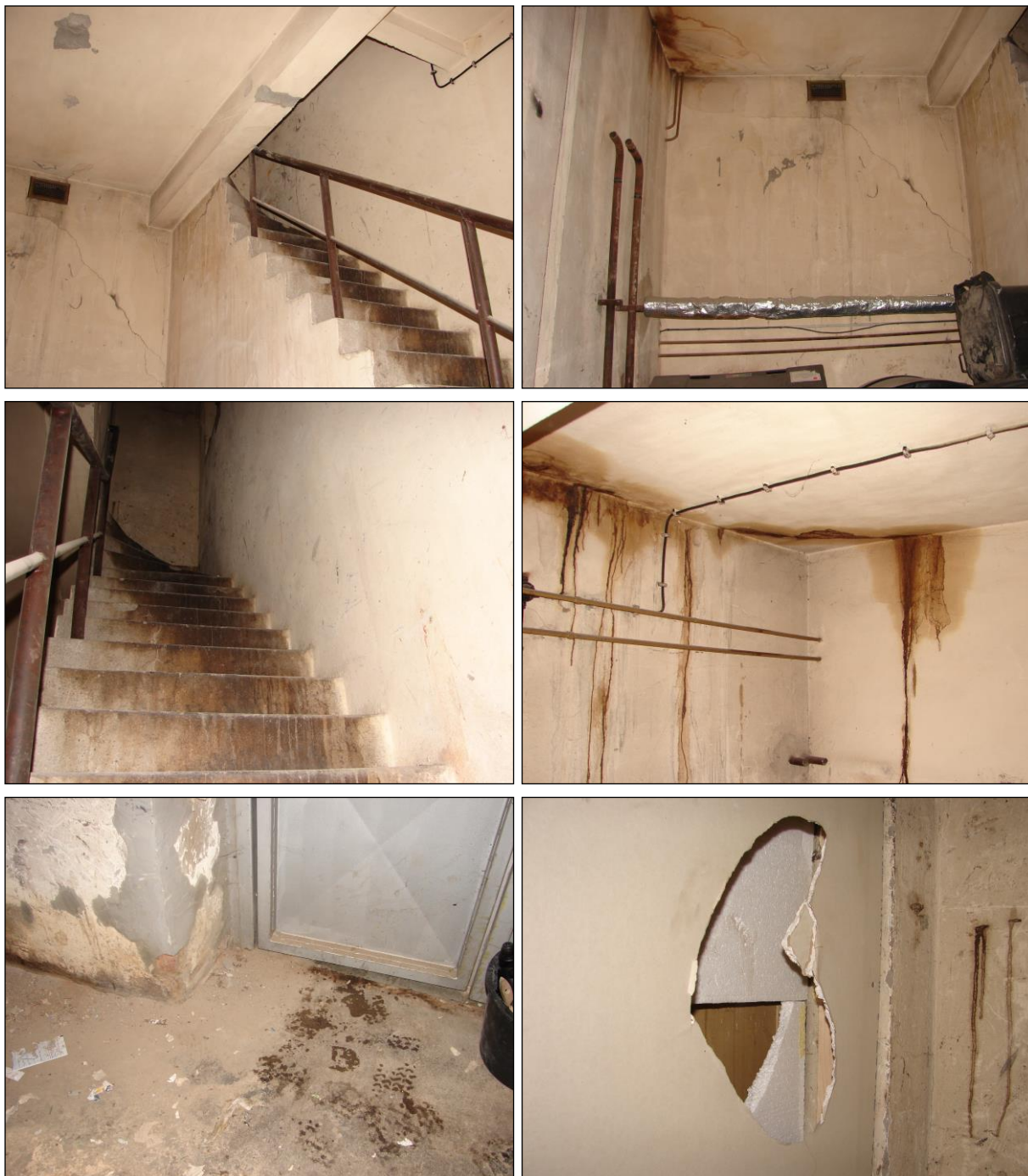
Foto 25 - 30: Místnost C.N1.46, umístěny plastové kontejnery na odpad, ŽB strop, zděné stěny, lokální znečištění olejovými produkty, podlaha betonová, ocelová vrata, ocelové zábradlí, betonové schodiště do 2.NP, dveře do 2.NP ocelové, překryté polystyrenem a sádkartonem
