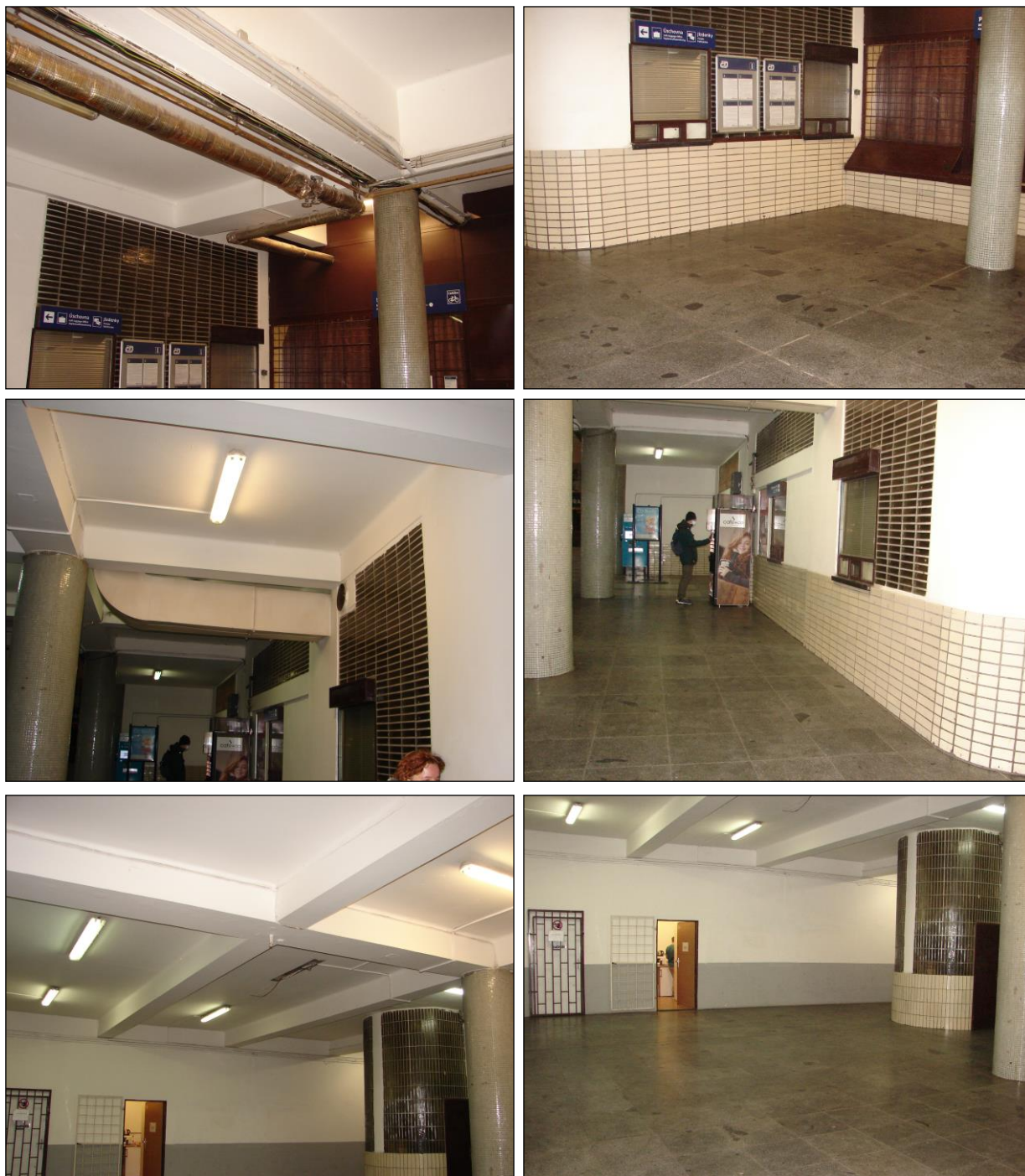
Foto 199 - 204: Místnost B.N1.23, hala, ŽB skelet, výplňové zdivo, luxfery, keramický obklad, na podlaze kamenná dlažba, hliníkové okno a dveře
