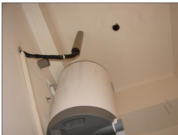
Foto 217 a 218: Místnost B.N1.29 , ŽB skelet, výplňové zdivo, keramický obklad, keramická dlažba na podlaze, ve stropě plastová průchodka
