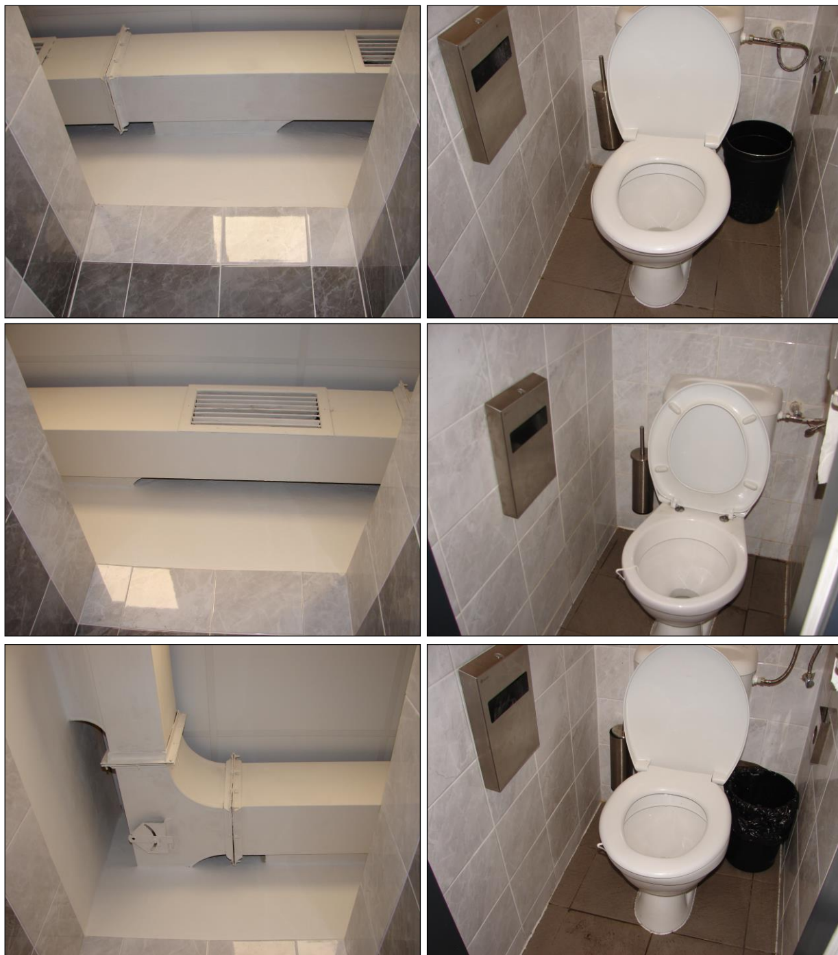
Foto 153 - 158: Místnost C.N1.07, veřejné WC ženy, tři kabiny WC, ŽB skelet, výplňové zdivo, keramický obklad, keramická dlažba na podlaze, pod stropem kazetový podhled, plechové VZT potrubí
