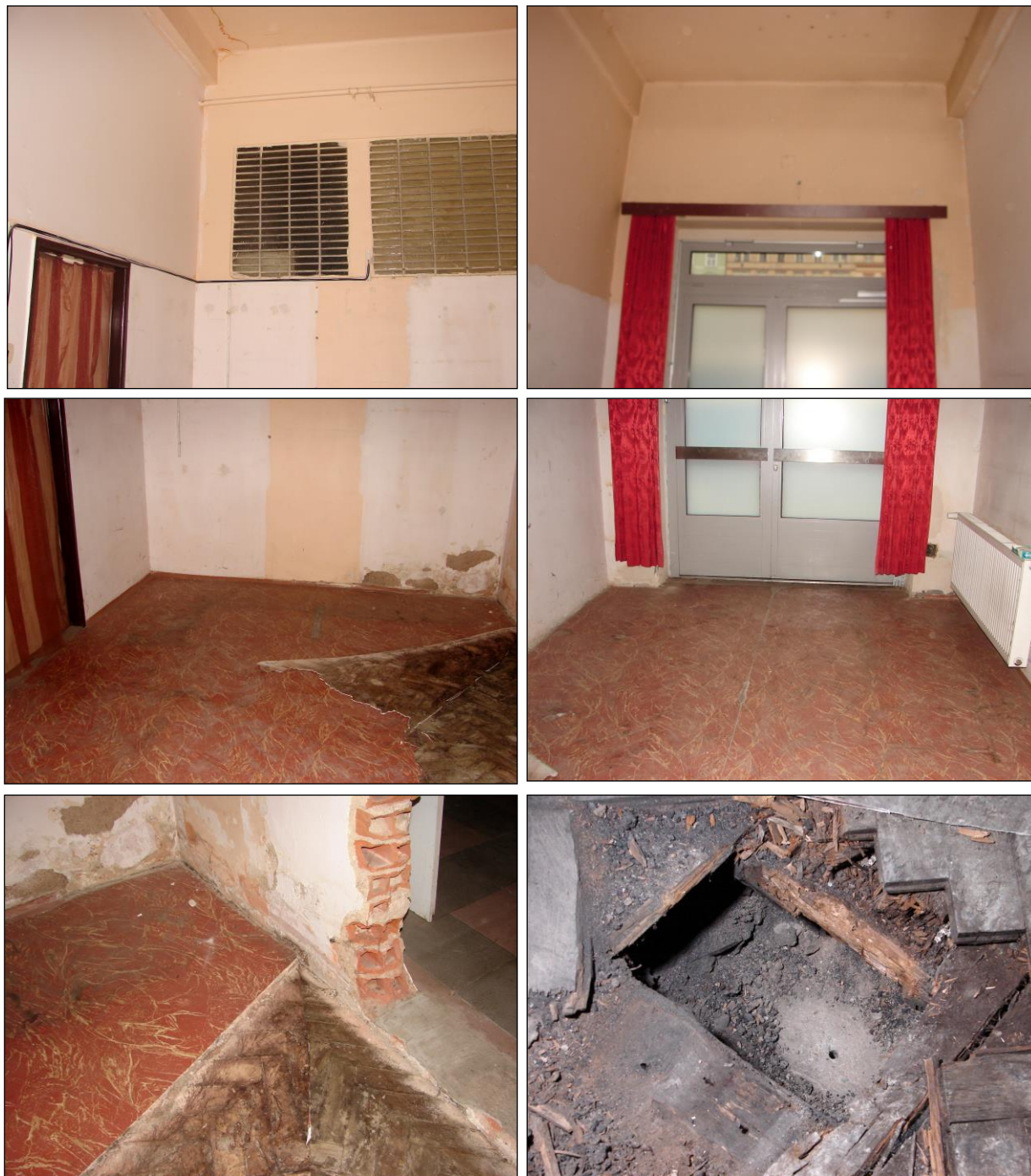
Foto 90 - 95: Místnost C.N1.29, ŽB skelet, výplňové zdivo, luxfery ve stěně, hliníkové dveře, PVC a parkety na podlaze, sonda do podlahy: parkety, prkna na podkladních trámech, škvárový násyp s příměsí suti, beton (150 - 200 mm)
