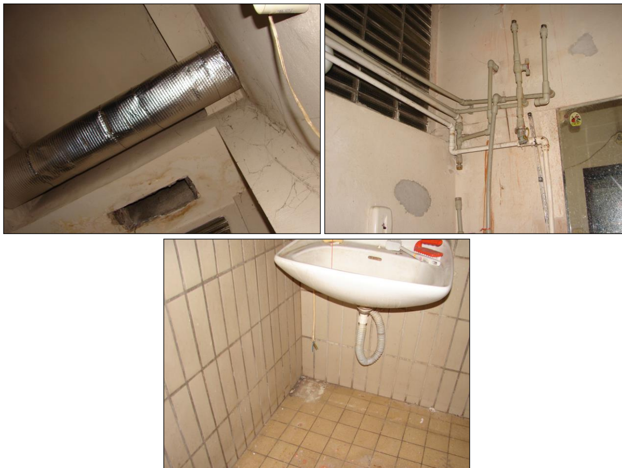
Foto 112 - 114: Místnost C.N1.22, soc. zařízení, ŽB skelet, výplňové zdivo, luxfery ve stěně, plastové potrubí, keramický obklad, keramická dlažba na podlaze, větrací otvor v průvlaku, ocelové potrubí s izolací z minerální vlny obalené kartonem a Al fólií
