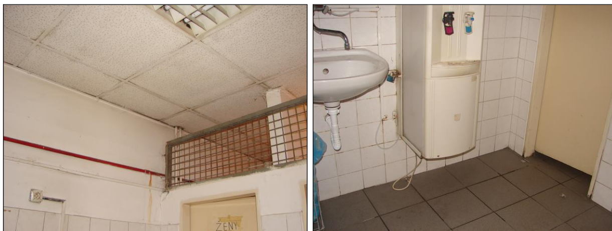
Foto 35 a 36: Místnost C.N1.43, místnost řidičů DP, ŽB strop s kazetovým podhledem, zděné stěny, keramický obklad, keramická dlažba na podlaze, ocelová drátěná mříž
