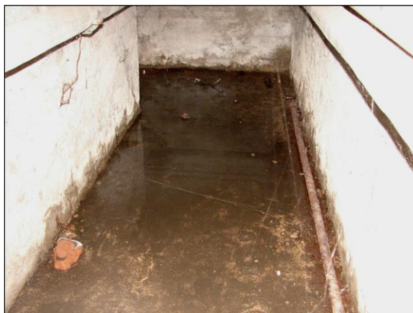
Foto 6 a 7: Technologický kanál B.P1.22, úsek v pravoúhlém zalomení (pokračování kanálu z foto 3), voda na podlaze, kanál pokračuje pravoúhlým zalomením vlevo
