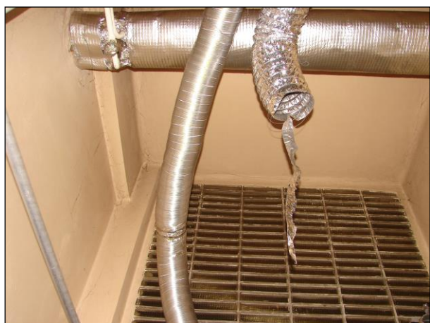
Foto 121 a 122: Místnost C.N1.18, soc. zařízení, ŽB skelet, výplňové zdivo, luxfery ve stěně, keramický obklad, PVC na podlaze, ocelové potrubí s izolací z minerální vlny obalené kartonem a Al fólií, plastové potrubí, odvětrávací potrubí z Al fólie
