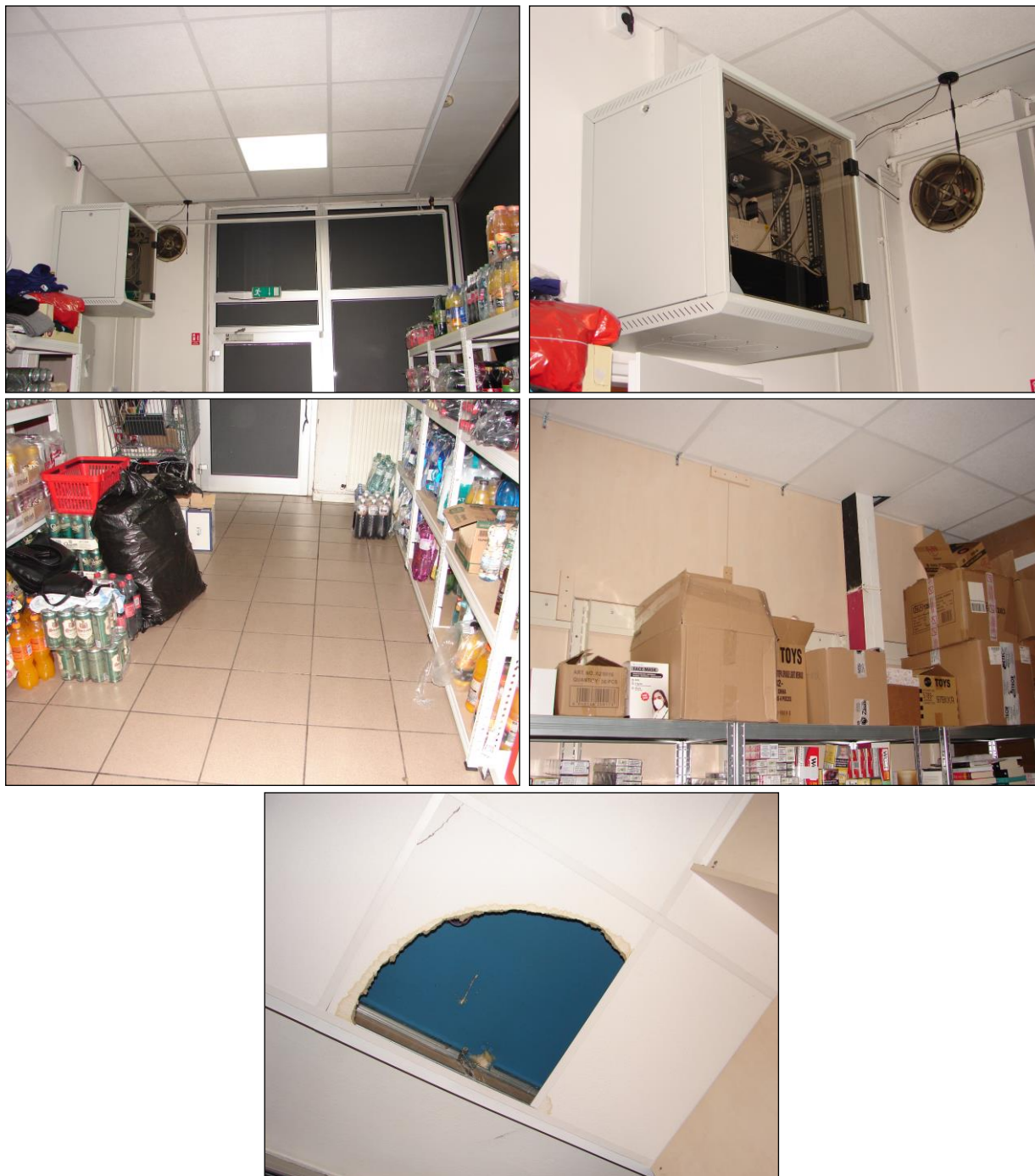
Foto 223 - 227: Místnost B.N1.31, zázemí trafiky, ŽB skelet, výplňové zdivo, keramická dlažba na podlaze, ocelový sloupek, hliníkové dveře, kazetový zavěšený podhled, rozvody sítí v kovové skříni
