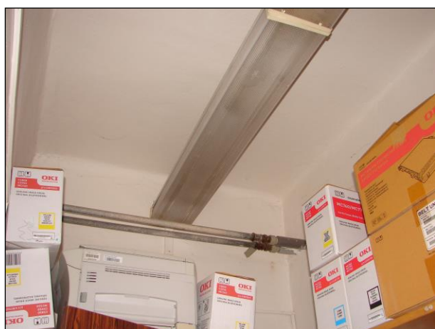
Foto 271 a 272: Místnost C.N2.25, pošta, ŽB skelet, výplňové zdivo, hliníkové okno, ocelové potrubí, (na podlaze PVC)
