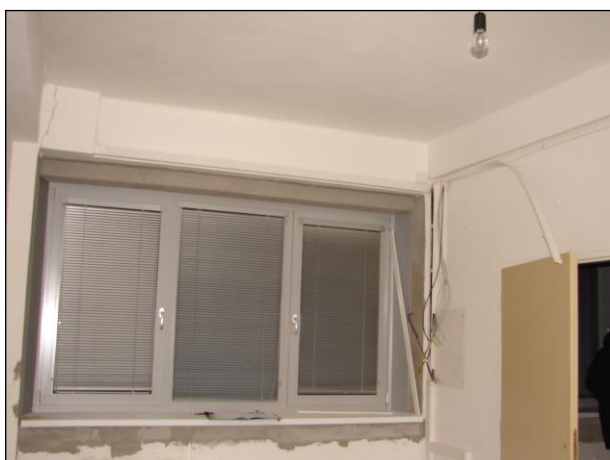
Foto 346 a 347: Místnost C.N2.01, ŽB skelet, výplňové zdivo, hliníkové okno, na podlaze koberec
