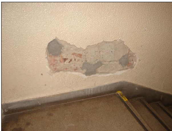
Foto 75 a 76: Místnost C.N1.34, pošta, schodiště do 2.NP, ŽB skelet, výplňové zdivo, olejový nátěr, teraco na schodišťových stupních a podestách, dřevěné madlo
