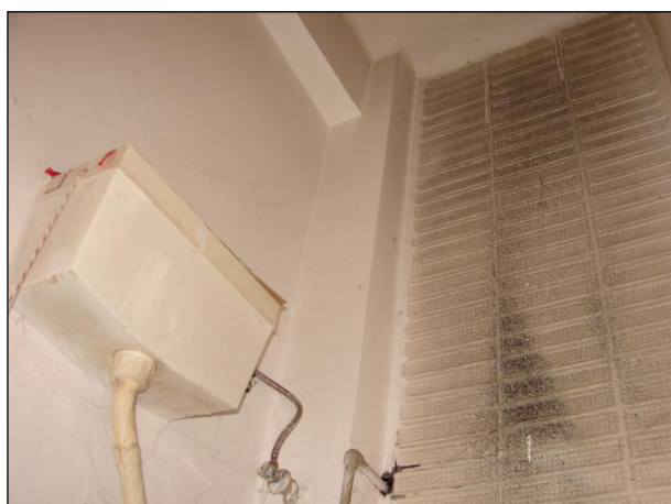
Foto 100 a 101: Místnost C.N1.26, pošta, WC, ŽB skelet, výplňové zdivo, luxfery ve stěně, plastové potrubí, keramický obklad, keramická dlažba na podlaze
