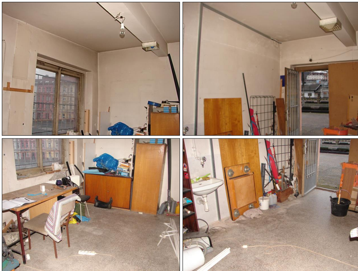
Foto 243 - 246: Místnost C.N2.39, zděné stěny, ŽB strop, na podlaze teraco, kovové okno a kovové dveře
