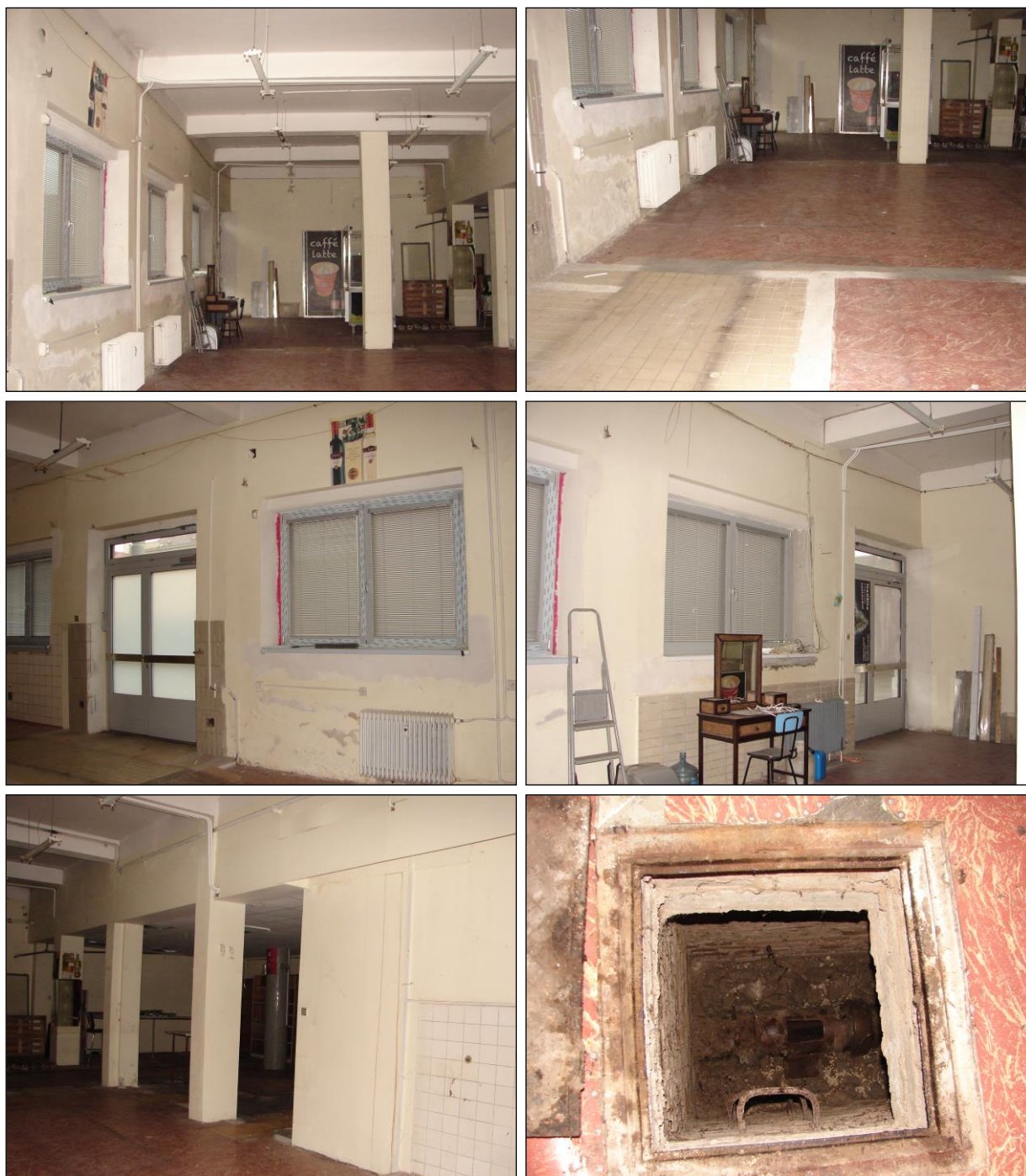
Foto 170 - 175: Místnost C.N1.01, část místnosti u obvodové stěny, ŽB skelet, výplňové zdivo, keramický obklad, hliníková okna a dveře, PVC a keramická dlažba na podlaze, zděná šachtice s kameninovou kanalizační rourou
