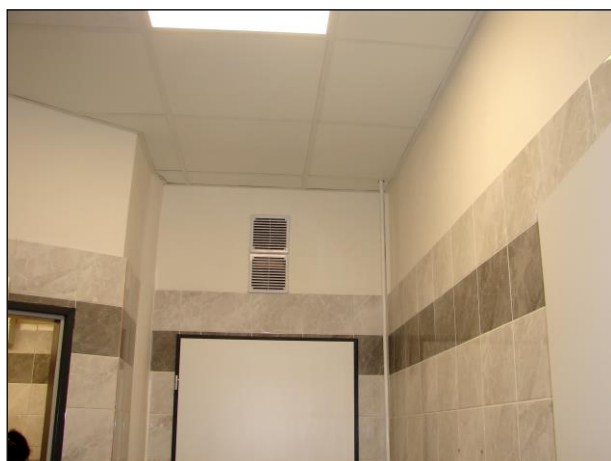
Foto 145 a 146: Místnost C.N1.10, umývárna na veřejném WC muži, ŽB skelet, výplňové zdivo, keramický obklad a keramická dlažba na podlaze, pod stropem kazetový podhled
