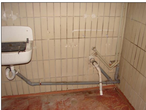
Foto 121 a 122: Místnost C.N1.18, soc. zařízení, ŽB skelet, výplňové zdivo, luxfery ve stěně, keramický obklad, PVC na podlaze, ocelové potrubí s izolací z minerální vlny obalené kartonem a Al fólií, plastové potrubí, odvětrávací potrubí z Al fólie
