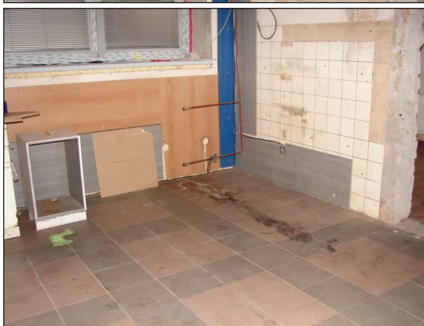
Foto 86 - 89: Místnost C.N1.30, ŽB skelet, výplňové zdivo, obklad z dřevotřískových desek a nad ním zamalované luxfery, keramická dlažba na podlaze, hliníkové okno
