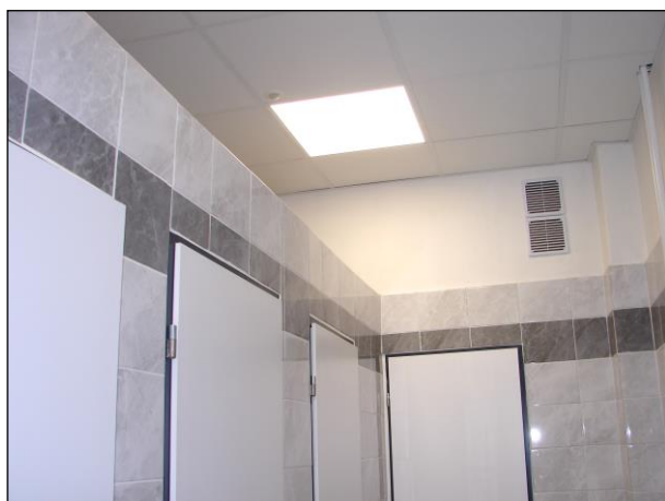
Foto 151 a 152: Místnost C.N1.07 , veřejné WC řeny, předsíň před třemi kabinami (kabiny viz další strana), řB skelet, výplňové zdiř, keramický obklad, keramická dlařba na podlaze, pod stropem kazetový podhled, plechové VZT potrubí
