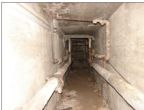
Foto 10 a 11: Technologický kanál B.P1.22, na foto vlevo povlovné zalomení kanálu u místa vstupu (Příloha 1.1), na foto vpravo přímý úsek kanálu, který pokračuje pravoúhlým zalomením vpravo (viz další foto)
