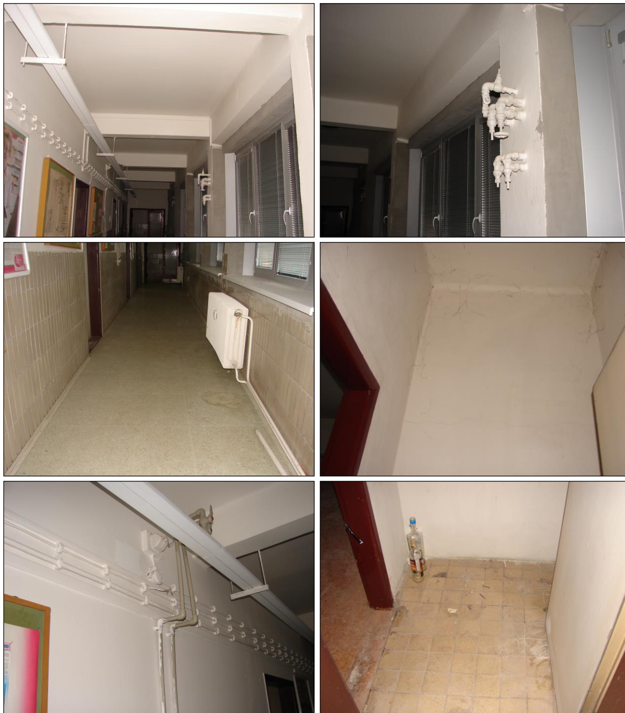
Foto 312 - 317: Místnost C.N2.13, ŽB skelet, výplňové zdivo, keramický obklad, hliníková okna, na podlaze PVC (v malé místnosti keramická dlažba), plastové potrubí, plechová lávka pod stropem
