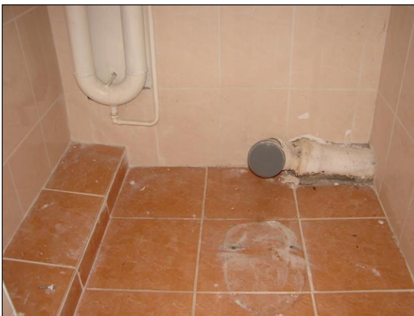
Foto 336 a 337: Místnost C.N2.06, WC, ŽB skelet, výplňové zdivo, keramický obklad, ocelové potrubí, litinová roura u podlahy, hliníkové okno, na podlaze keramická dlažba
