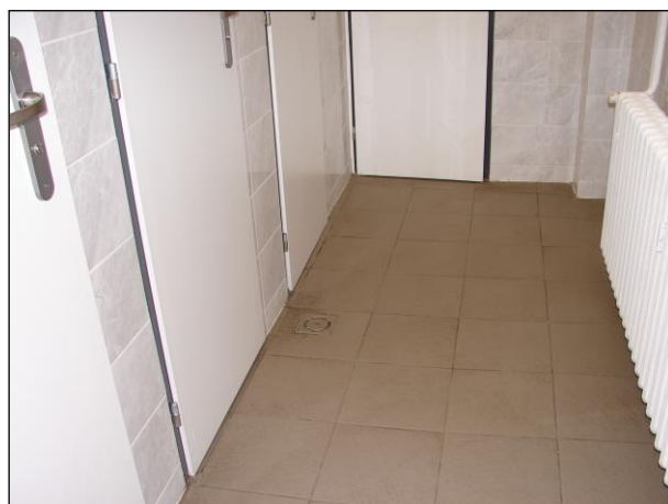
Foto 151 a 152: Místnost C.N1.07 , veřejné WC řeny, předsíň před třemi kabinami (kabiny viz další strana), řB skelet, výplňové zdiř, keramický obklad, keramická dlařba na podlaze, pod stropem kazetový podhled, plechové VZT potrubí
