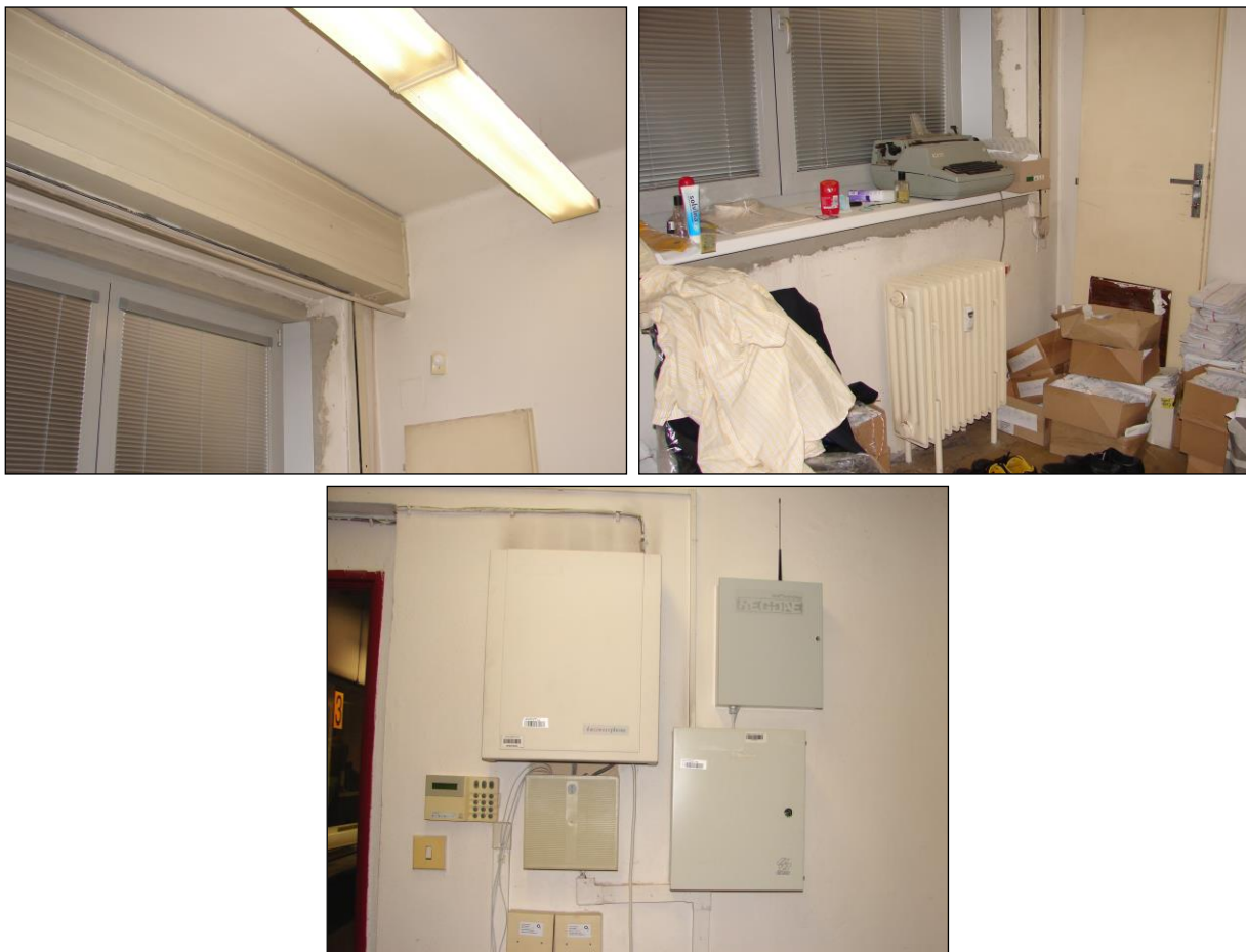
Foto 273 - 275: Místnost C.N2.24, pošta, ŽB skelet, výplňové zdivo, hliníkové okno, ocelové potrubí, na podlaze PVC, el. a slaboproudé rozvody v plastových skříních
