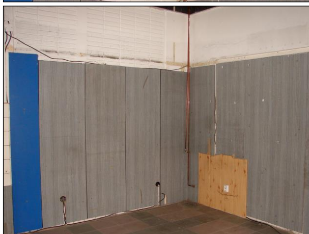
Foto 86 - 89: Místnost C.N1.30, ŽB skelet, výplňové zdivo, obklad z dřevotřískových desek a nad ním zamalované luxfery, keramická dlažba na podlaze, hliníkové okno
