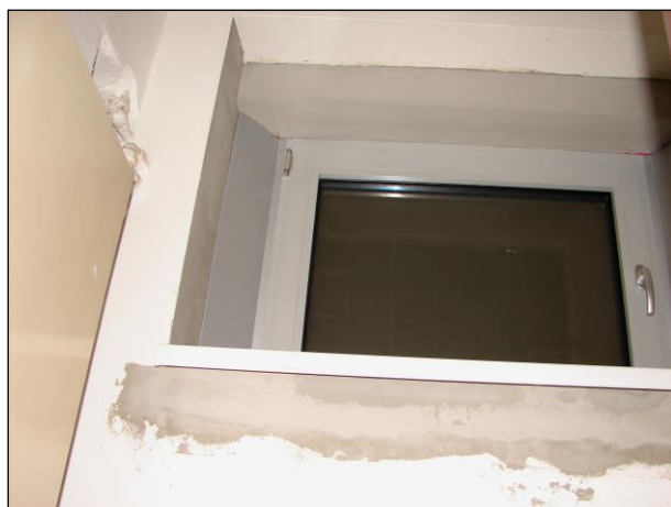
Foto 330 - 335: Místnost C.N2.07, WC pisoár a kabína, ŽB skelet, výplňové zdivo, luxfery, keramický obklad, plastové potrubí, litinový svod, hliníkové okno, na podlaže keramická dlažba
