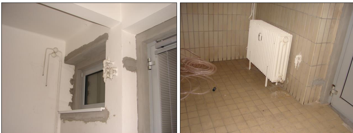
Foto 322 a 323: Místnost C.N2.11, ŽB skelet, výplňové zdivo, hliníkové okno a dveře, na podlaze keramická dlažba
