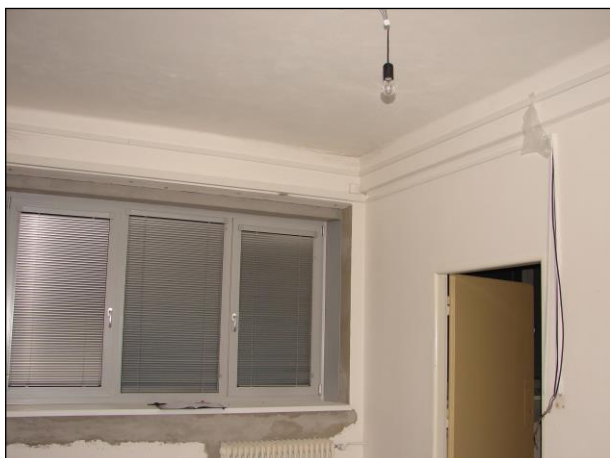
Foto 344 a 345: Místnost C.N2.02, ŽB skelet, výplňové zdivo, hliníkové okno, na podlaze koberec
