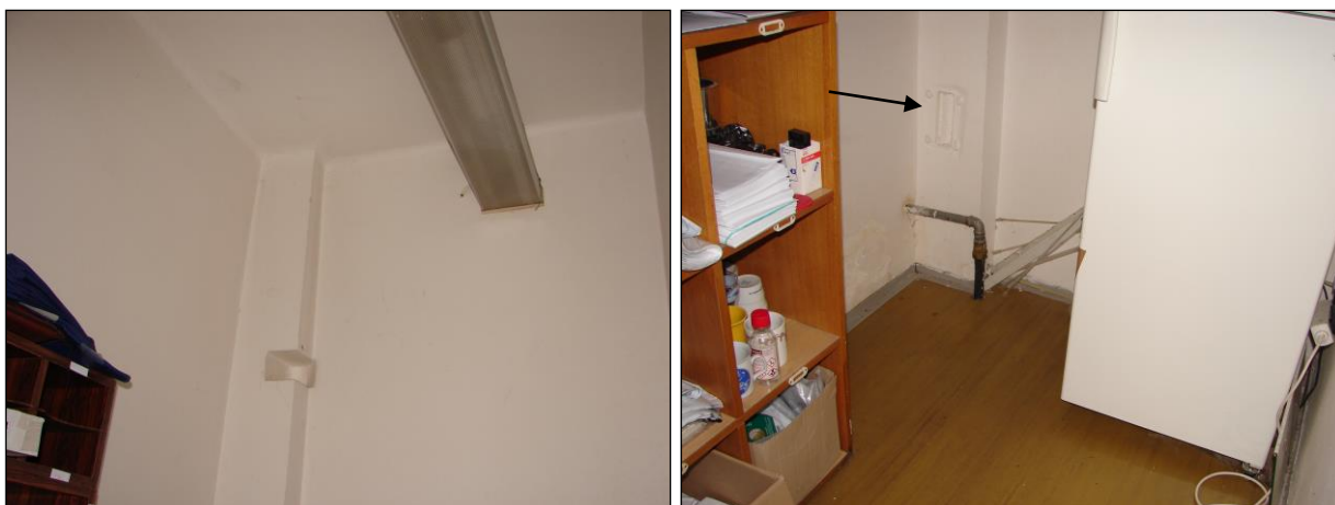
Foto 261 a 262: Místnost C.N2.28, pošta, ŽB skelet, výplňové zdivo, na podlaze PVC, litinový svod (šipkou vyznačen revizní otvor)
