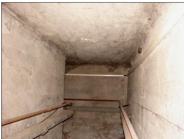
Foto 6 a 7: Technologický kanál B.P1.22, úsek v pravoúhlém zalomení (pokračování kanálu z foto 3), voda na podlaze, kanál pokračuje pravoúhlým zalomením vlevo
