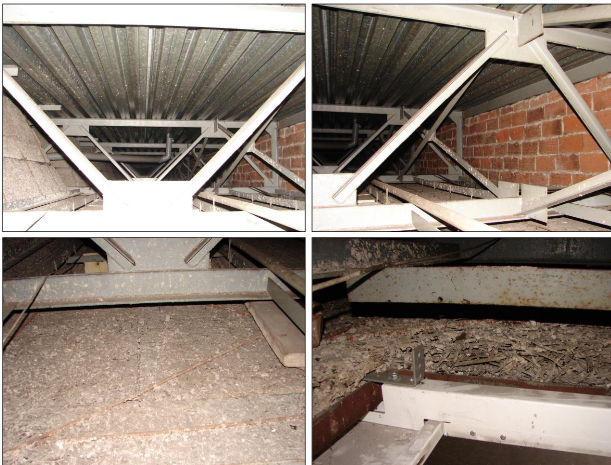
Foto 403 - 406: Střecha, baldachýn, přístavba z 80. let 20. stol., vnitřní prostor střechy, nosná ocelová příhradová konstrukce, trapézový plech (ocelobetonový strop), obvodové zdivo z CP, pohled z heraklitu
