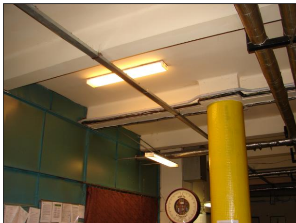
Foto 187 a 188: Místnost B.N1.22, ŽB skelet, výplňové zdivo, PVC na podlaze, ocelové potrubí
