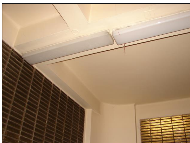
Foto 185 a 186: Místnost B.N1.22, ŽB skelet, výplňové zdivo, luxfery ve stěnách, el. rozvody na plastové desce
