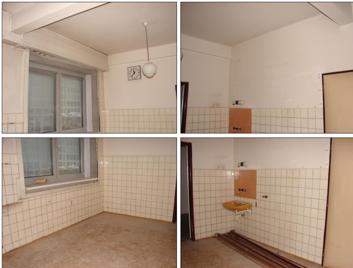
Foto 295 - 298: Místnost C.N2.17, ŽB skelet, výplňové zdivo, keramický obklad, na podlaze PVC, hliníková okna
