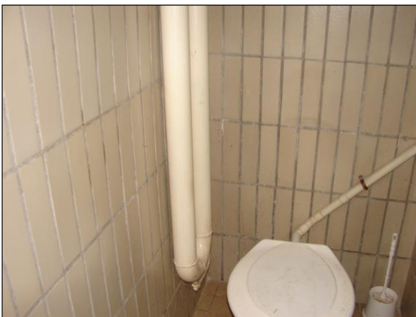
Foto 326 a 327: Místnost C.N2.09, WC a sprcha, ŽB skelet, výplňové zdivo, keramický obklad, hliníkové okno, ocelové potrubí, na podlaze keramická dlažba
