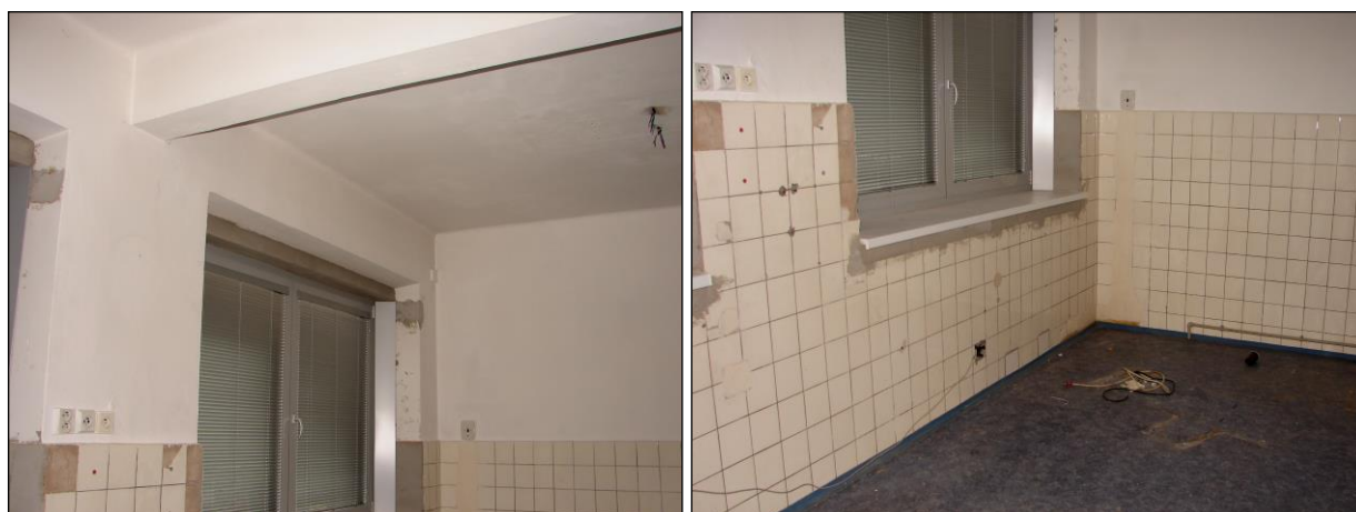
Foto 288 a 289: Místnost C.N2.19, ŽB skelet, výplňové zdivo, keramický obklad, na podlaze PVC, hliníková okna
