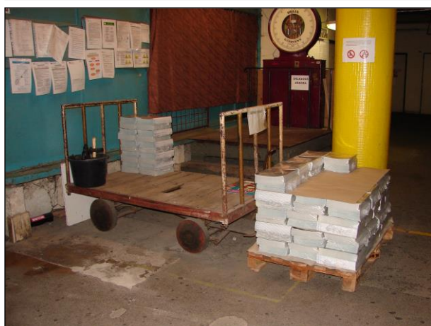
Foto 189 - 192: Místnost B.N1.23A (písmeno A k číslu místnosti přidáno zhotovitelem), ŽB skelet, výplňové zdivo, betonová podlaha, příčka z plechu, ocelové potrubí s izolací z minerální vlny obalené kartonem a Al fólií
