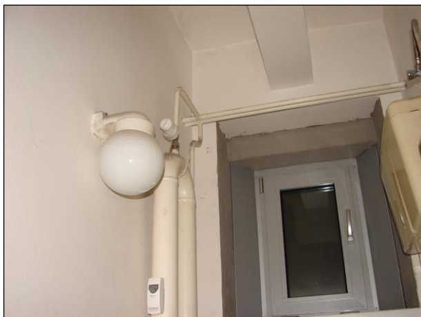
Foto 326 a 327: Místnost C.N2.09, WC a sprcha, ŽB skelet, výplňové zdivo, keramický obklad, hliníkové okno, ocelové potrubí, na podlaze keramická dlažba
