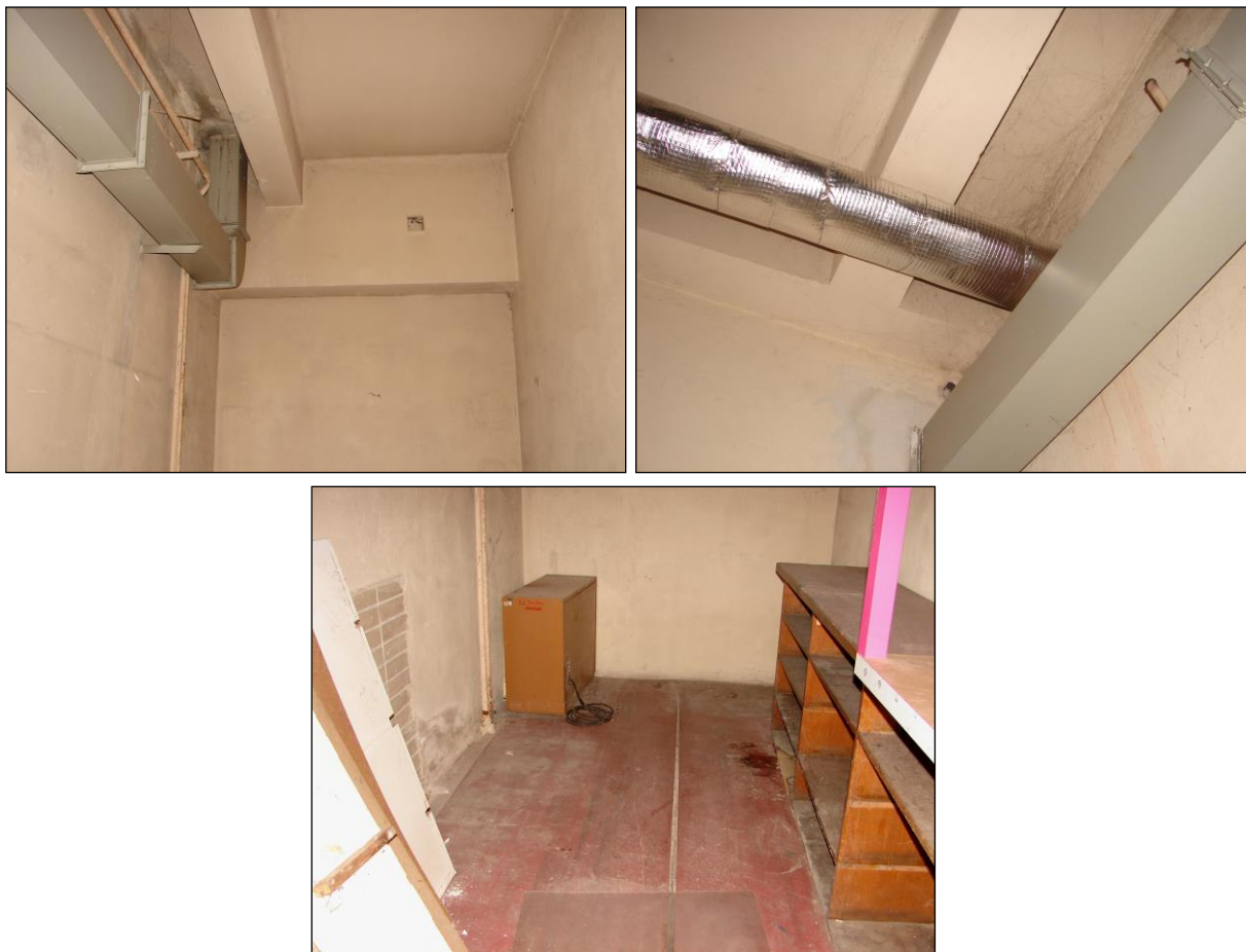
Foto 128 - 130: Místnost C.N1.16 , ŽB skelet, výplňové zdivo, keramický obklad, PVC na podlaze, plechové VZT potrubí, ocelové potrubí s izolací z minerální vlny obalené kartonem a Al fólií
