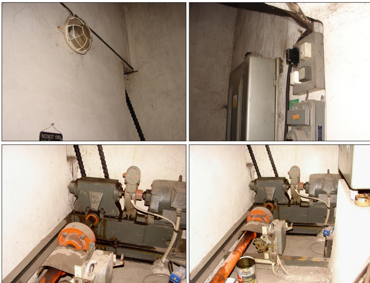
Foto 131 - 134: Místnost C.N1.14, strojovna výtahu, ŽB skelet, výplňové zdivo, betonová podlaha, el. rozvody v plastové a plechové skříně
