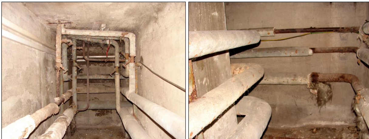
Foto 12 a 13: Technologický kanál B.P1.22 , na foto vlevo konec přímého úseku kanálu z předcházející foto, který pokračuje pravoúhlým zalomením vpravo, na foto vpravo krátký úsek kanálu, který pokračuje pravoúhlým zalomením vlevo kolem výtahu, patrná je tepelná izolace potrubí ze skelných vláken obalená kartonem a sádkou
