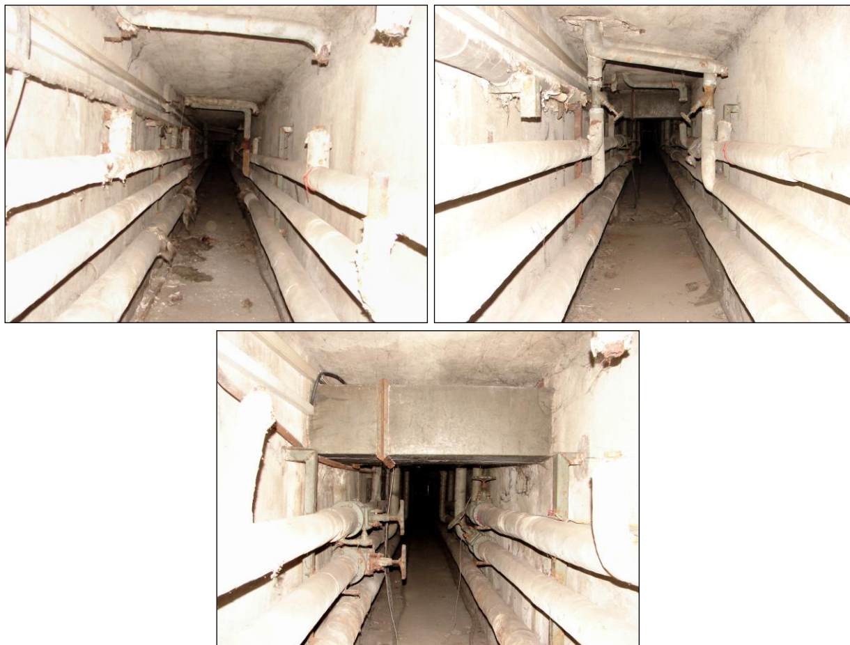
Foto 16 - 18: Technologický kanál B.P1.22 , přímý úsek kanálu za výtahem, který pokračuje pod centrální část výpravní budovy, na foto dole je pod stropem plechové VZT potrubí, v těchto místech přibližně končí posuzovaná část budovy, kanál pokračuje dále
