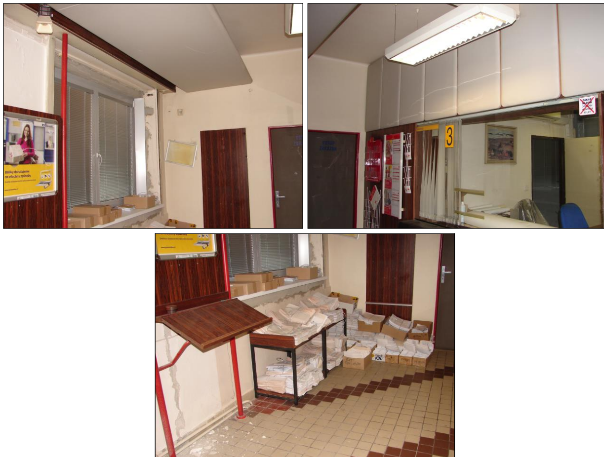
Foto 276 - 278: Místnost C.N2.23, pošta, prostor před přepážkou, ŽB skelet, výplňové zdivo, hliníkové okno, na podlaze keramická dlažba, nad přepážkou kazetový koženkový obklad (dtto nad oknem)
