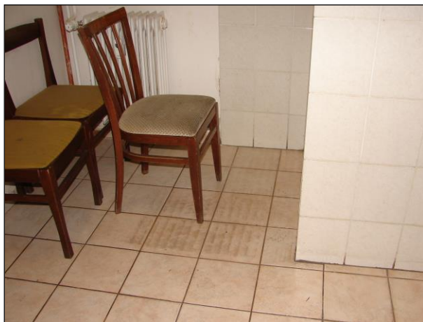
Foto 137 a 138: Místnost C.N1.12, soc. zařízení, ŽB skelet, výplňové zdivo, keramický obklad a keramická dlažba na podlaze
