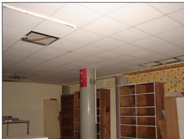
Foto 176 a 177: Místnost C.N1.01, zadní část místnosti, ŽB skelet, výplňové zdivo, kazetový podhled pod stropem, PVC a keramická dlažba na podlaze
