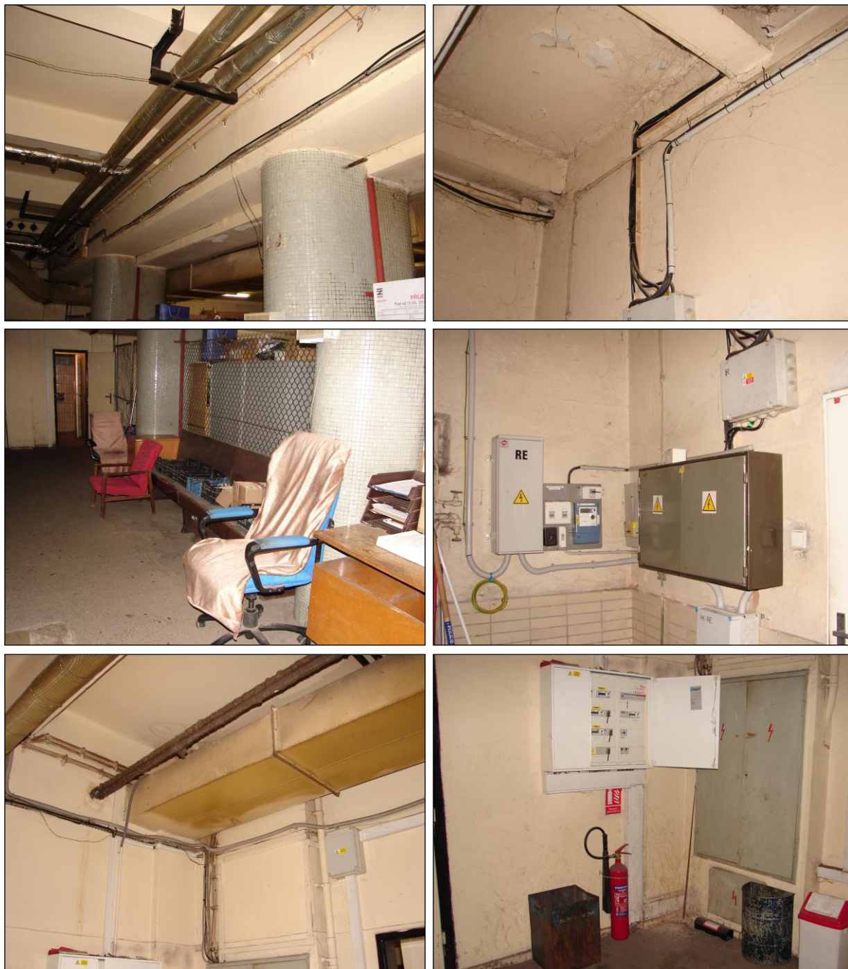
Foto 193 - 198: Místnost B.N1.23A (písmeno A k číslu místnosti přidáno zhotovitelem), ŽB skelet, výplňové zdivo, betonová podlaha, ocelové pletivo, ocelové potrubí s izolací z minerální vlny obalené kartonem a Al fólií, el. rozvody v kovových a plastových skříních, plechové VZT potrubí
