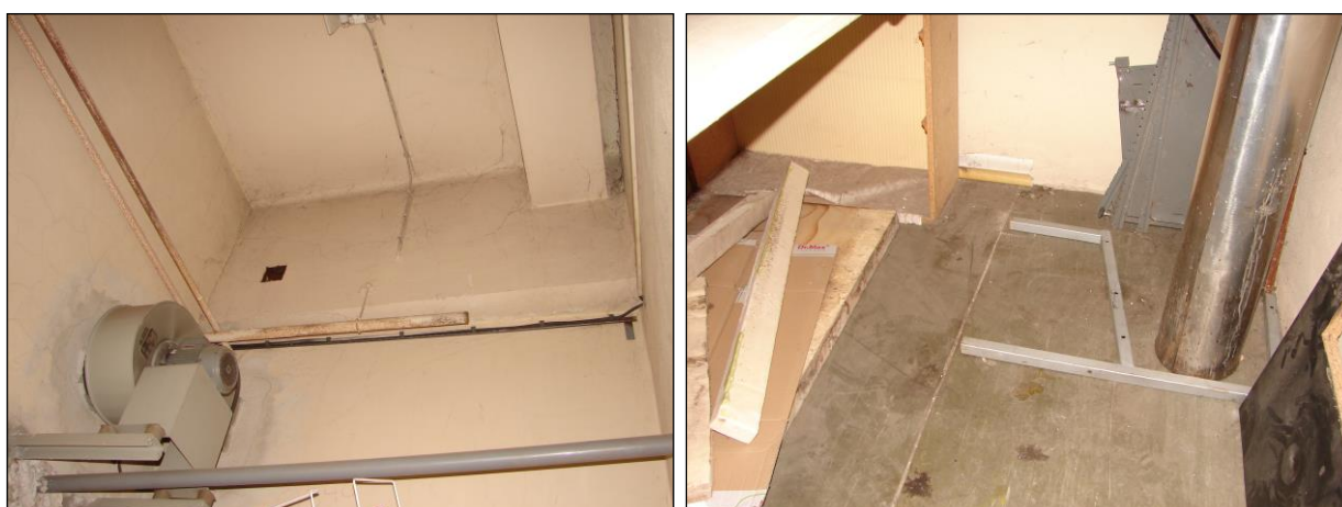
Foto 168 a 169: Místnost C.N1.02, ŽB skelet, výplňové zdivo, PVC na podlaze, plastové potrubí, kovový ventilátor
