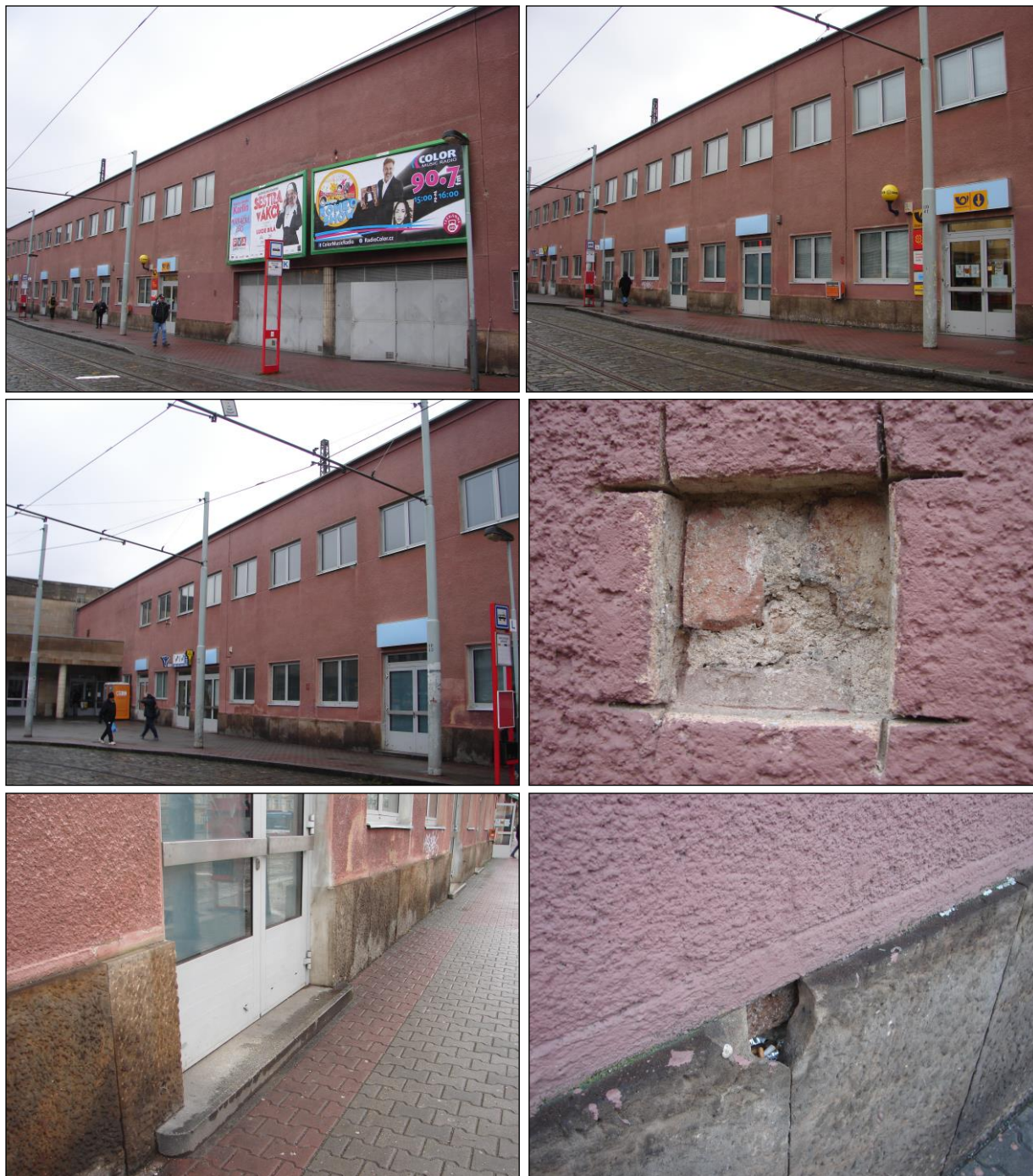
Foto 352 - 357: Fasáda, severní křídlo směrem k ulici, ŽB skelet s výplňovým zdivem z CP, ocelová vrata, hliníková okna a dveře, kamenný stupeň, sonda pro ověření zdiva z CP, sokl z pískovce, za soklem z pískovce zdivo z CP
