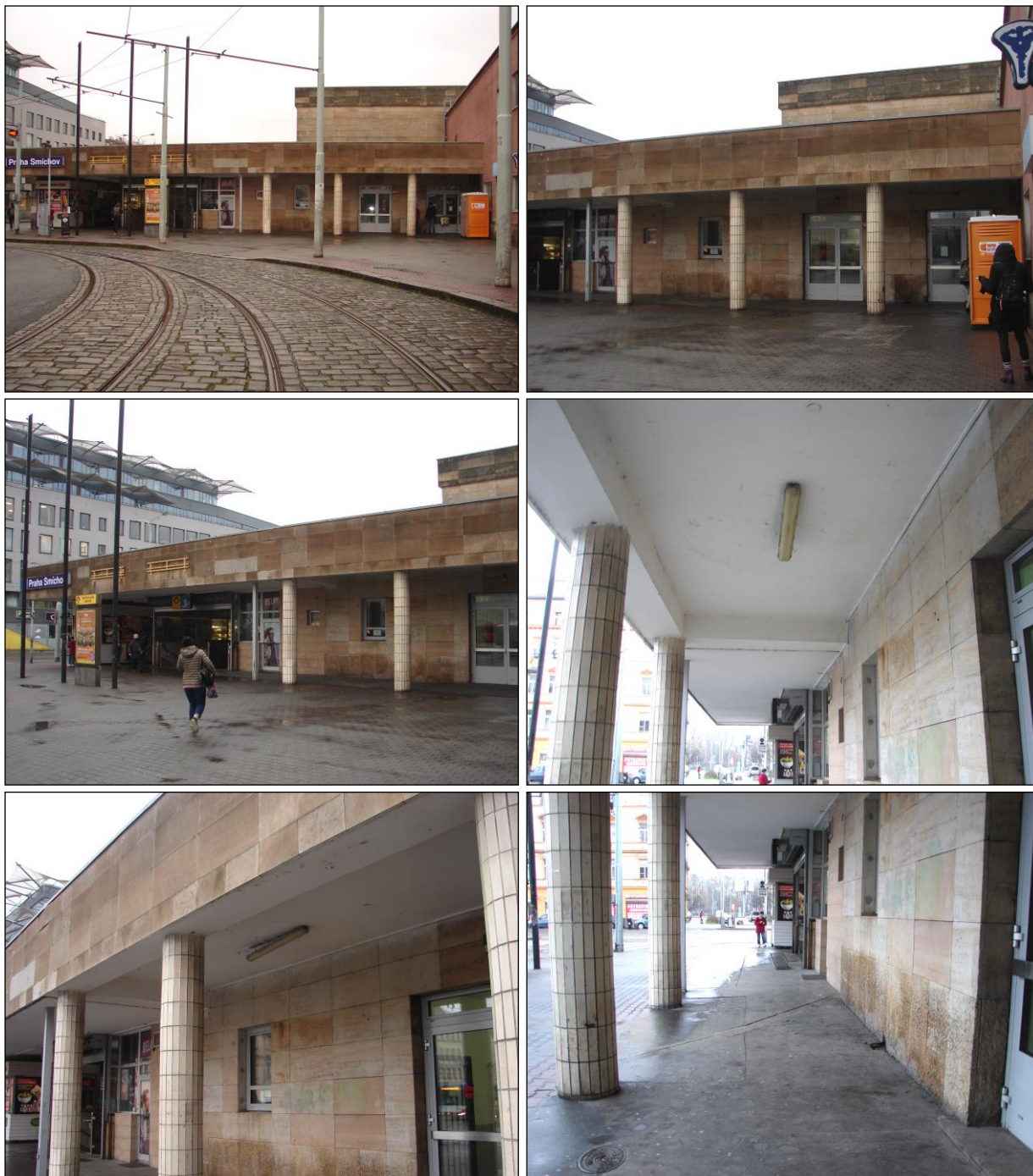
Foto 364 - 369: Fasáda, baldachýn, původní část ŽB skelet s výplňovým zdívem z CP, část z 80. let 20. stol. ocelové sloupky (konstrukce z oceli a betonu), hliníková okna a dveře, kamenný obklad, na ŽB sloupech keramický obklad,
