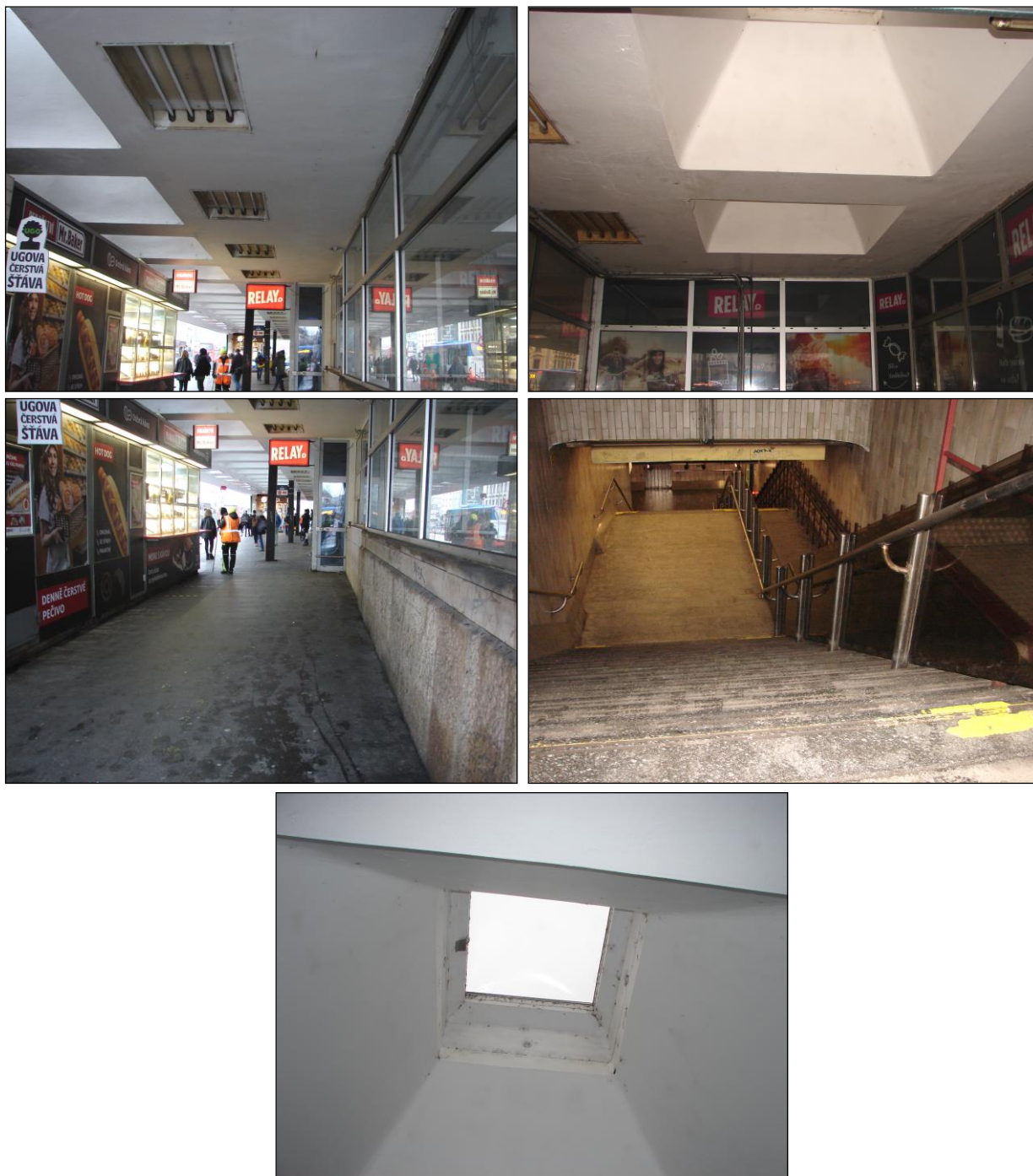
Foto 370 - 374: Fasáda, baldachýn, vstup do metra a venkovní nárožní část z 80. let 20. stol. (konstrukce z oceli a betonu), ocelové sloupky, hliníková okna a dveře, pískovcový obklad na soklu, keramický obklad vstupu do metra, kamenné schodišťové stupně, plastový světlík s plexisklem
