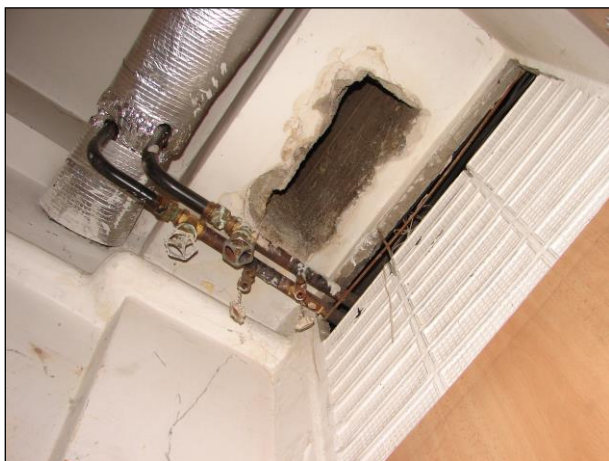
Foto 102 - 105: Místnost C.N1.25, WC, ŽB skelet, výplňové zdivo, zamalované luxfery ve stěně, plastové potrubí, obklad z dřevotřískových desek, keramický obklad, keramická dlažba na podlaze, kovové potrubí s izolací z minerální vlny obalené kartonem a Al fólií, odvětrávací otvor v průvlaku
