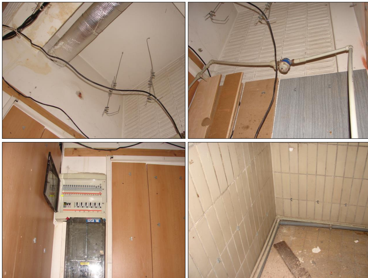
Foto 108 - 111: Místnost C.N1.23, soc. zařízení, ŽB skelet, výplňové zdivo, zamalované luxfery ve stěně, plastové potrubí, obklad z dřevotřískových desek, keramický obklad, keramická dlažba na podlaze, el. rozvody v plastových skříních
