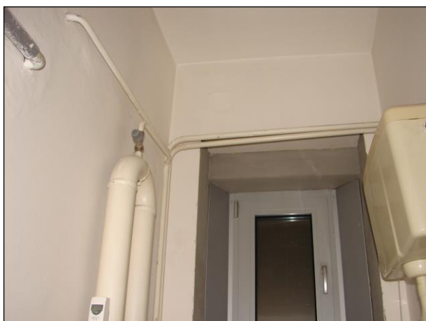
Foto 328 a 329: Místnost C.N2.08, WC, ŽB skelet, výplňové zdivo, keramický obklad, hliníkové okno, ocelové potrubí, na podlaze keramická dlažba
