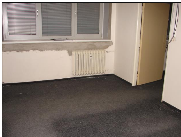
Foto 344 a 345: Místnost C.N2.02, ŽB skelet, výplňové zdivo, hliníkové okno, na podlaze koberec
