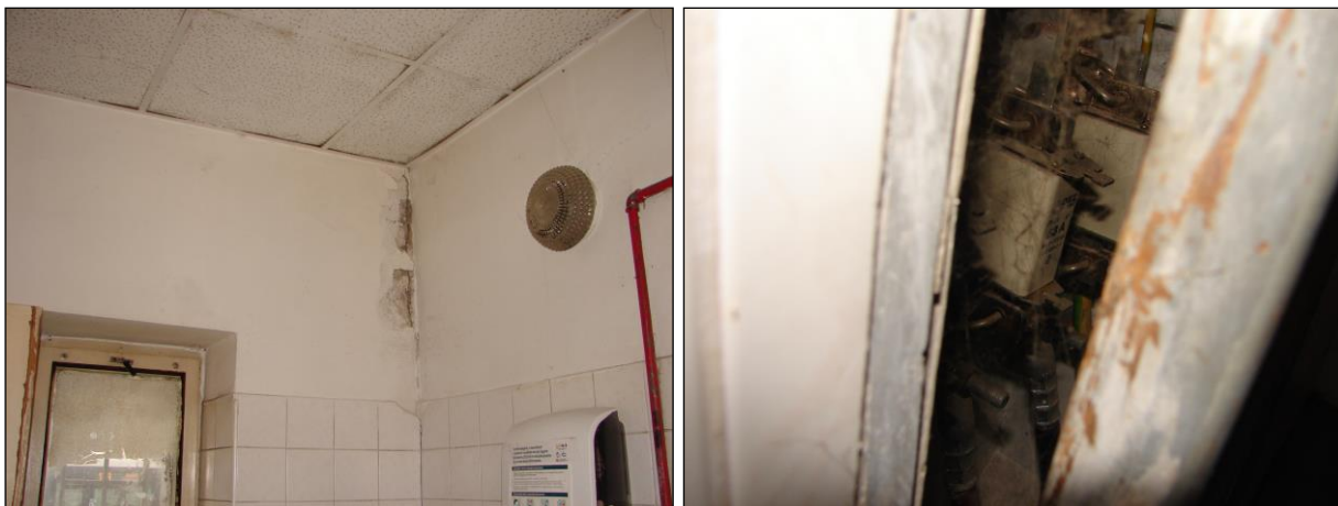
Foto 37 a 38: Místnost C.N1.43, místnost řidičů DP, ŽB strop s kazetovým podhledem, zděné stěny, dřevěné okno, keramický obklad, el. rozvody v obvodové stěně
