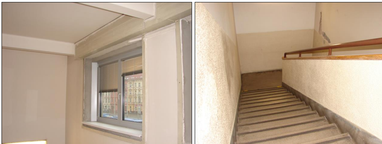
Foto 259 a 260: Místnost C.N2.29, schodiště do 1.NP, ŽB skelet, výplňové zdivo, hliníkové okno, na podestách a schodišťových stupních teraco, olejový nátěr podél schodiště, dřevěné madlo
