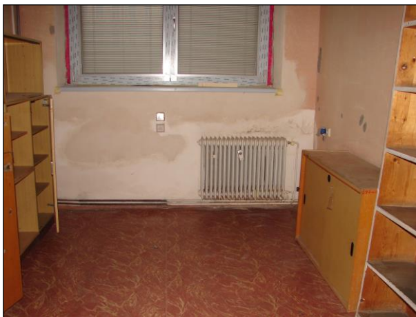
Foto 96 a 97: Místnost C.N1.28, ŽB skelet, výplňové zdivo, hliníkové okno, PVC na podlaze a pod ním parkety
