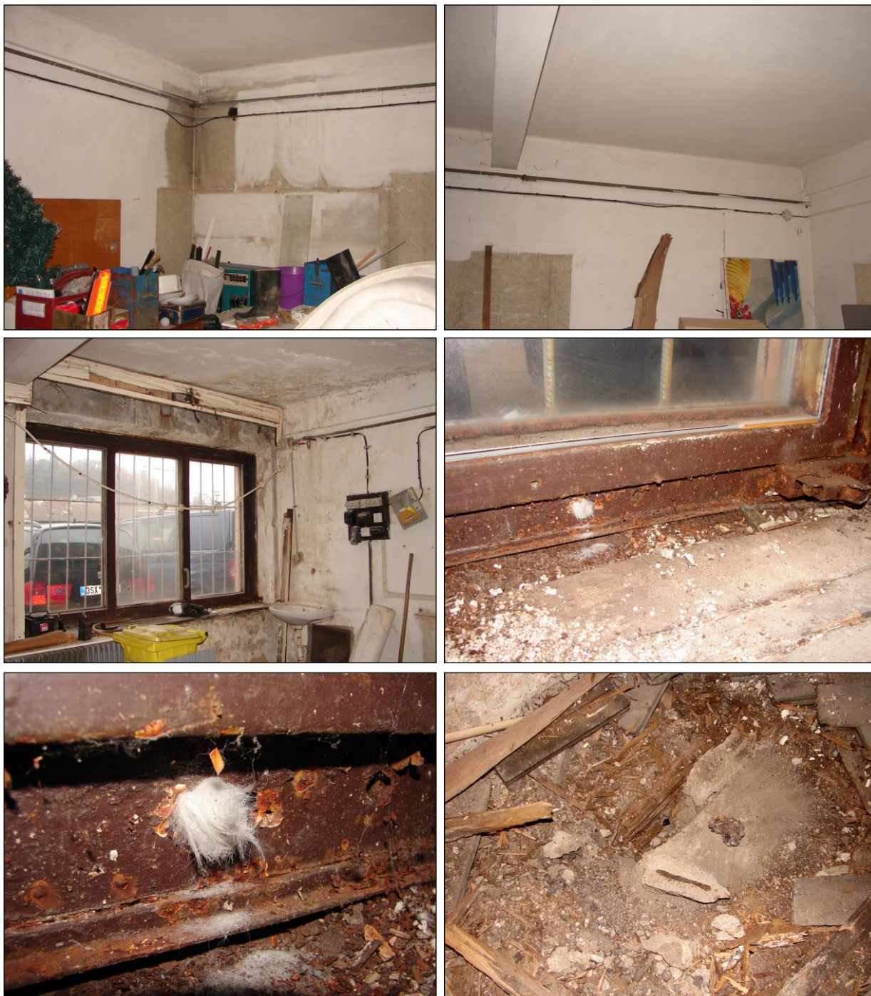
Foto 247 - 252: Místnost C.N2.31, ŽB skelet, výplňové zdivo, na podlaze parkety, el. rozvody na plastových deskách, kovové okno a kovové dveře, v kovovém rámu okna tepelná izolace ze skelných vláken, sonda do podlahy: parkety, prkna, škvárový násyp, beton
