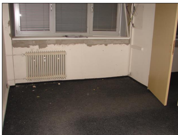
Foto 346 a 347: Místnost C.N2.01, ŽB skelet, výplňové zdivo, hliníkové okno, na podlaze koberec
