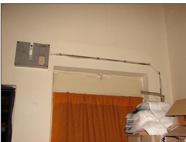
Foto 185 a 186: Místnost B.N1.22, ŽB skelet, výplňové zdivo, luxfery ve stěnách, el. rozvody na plastové desce
