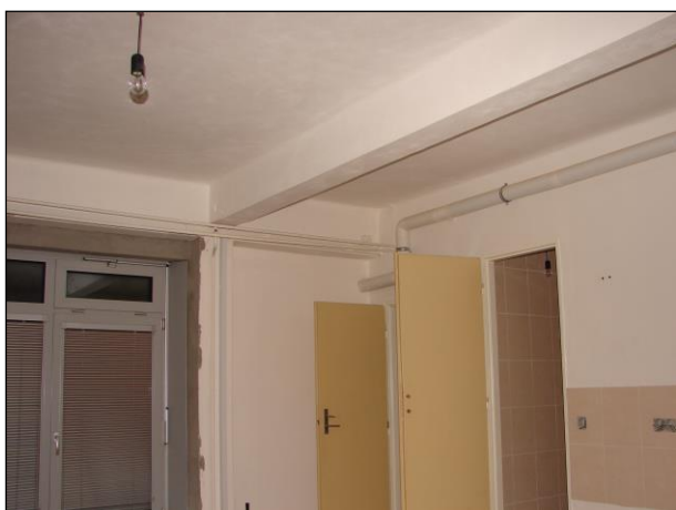
Foto 340 a 341: Místnost C.N2.04, ŽB skelet, výplňové zdivo, hliníkové okno, ocelové potrubí, na podlaze PVC, na schodišťovém stupni keramická dlažba
