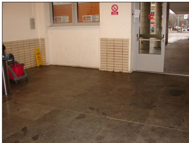
Foto 205 a 206: Místnost B.N1.23, hala, ŽB skelet, výplňové zdivo, keramický obklad, na podlaze kamenná dlažba, hliníkové okno a dveře
