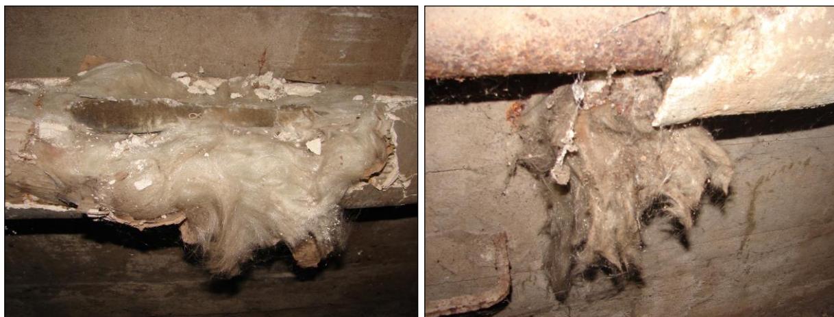
Foto 4 a 5: Technologický kanál B.PI.22, tepelná izolace potrubí u místa vstupu (Příloha 1.1), tepelná izolace ze skelných vláken obalená kartonem a sádkou, tímto způsobem je izolováno potrubí po celé délce posuzované části kanálu
