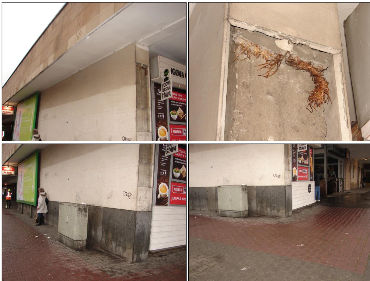
Foto 375 - 378: Fasáda, baldachýn, venkovní nárožní část, kamenný obklad na atice, ŽB stěna opatřená obkladem z mramoru a v soklové části ze žuly, na foto vpravo nahoře detail ŽB stěny s omítkou vyztuženou dřevitou vlnou
