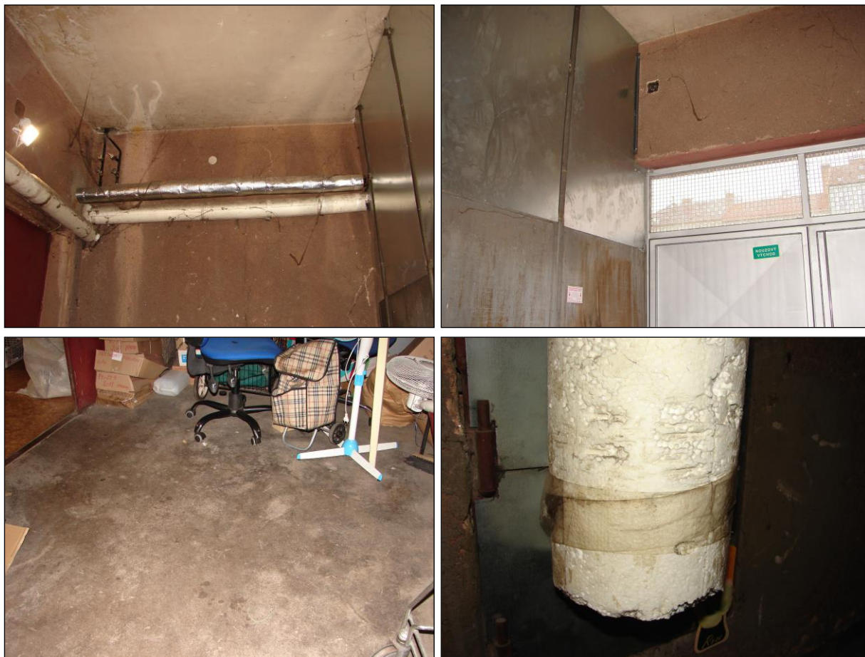
Foto 55 - 58: Místnost C.N1.40, ŽB skelet, výplňové zdivo, podlaha betonová, pískovcový sokl, ocelové drátěné mříže nad ocelovými vraty, ocelové potrubí s izolací z minerální vlny obalené kartonem a Al fólií a plastové potrubí izolované polystyrenem
