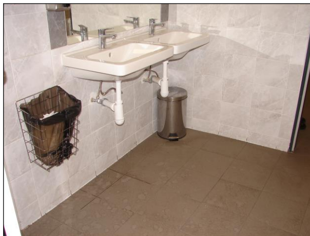
Foto 159 a 160: Místnost C.N1.06, umývárna na veřejném WC ženy, ŽB skelet, výplňové zdivo, keramický obklad, keramická dlažba na podlaze, pod stropem kazetový podhled
