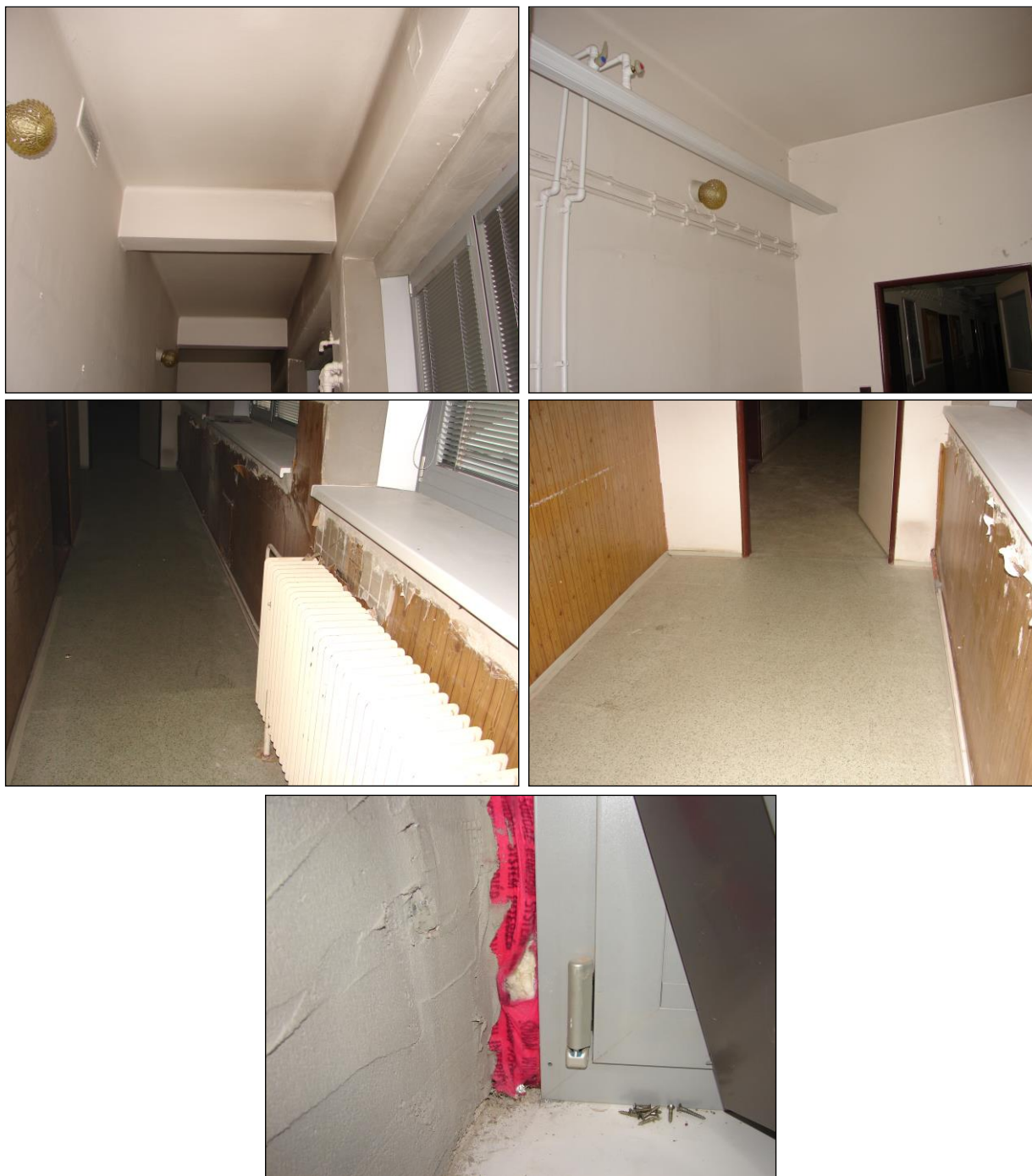
Foto 307 - 311: Místnost C.N2.14, ŽB skelet, výplňové zdivo, hliníková okna, na podlaze PVC, plastové potrubí, plechová lávka pod stropem, keramický obklad parapetu okna krytý tapetou s motivem dřeva, těsnění hliníkového okna PUR pěnou (tímto způsobem jsou těsněna všechna hliníková okna)
