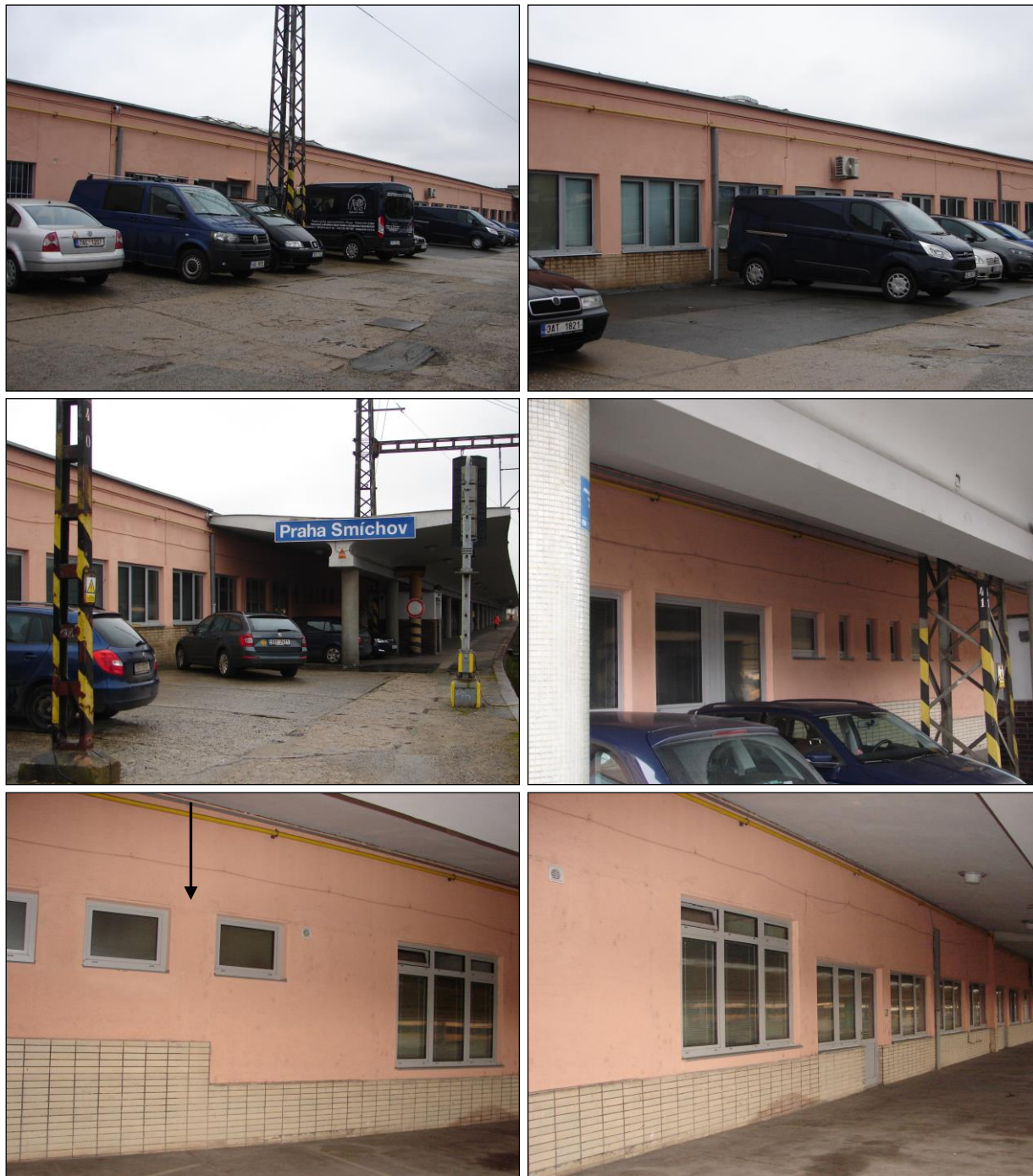
Foto 358 - 363: Fasáda, severní křídlo směrem ke kolejišti, ŽB skelet s výplňovým zdivem z CP, hliníková okna a dveře, na soklu keramický obklad, ŽB zastřešení nástupiště, na foto vlevo dole šipkou vyznačen konec severního křídla, na foto vpravo dole posuzovaná část centrální části výpravní budovy (dtto severní křídlo)
