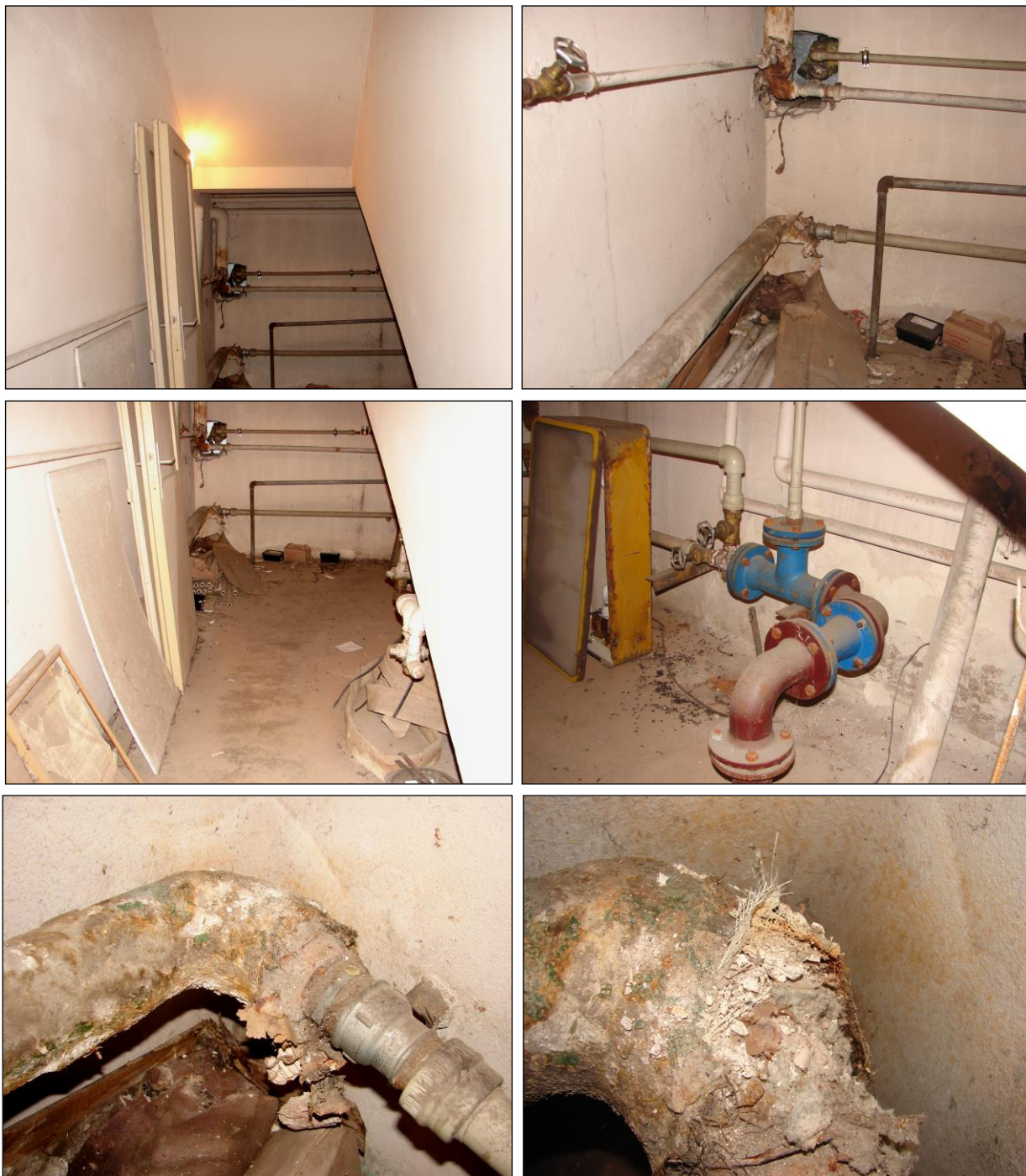
Foto 59 - 64: Místnost C.N1.39, místnost pod schodištěm do 1.NP, zděné stěny, podlaha betonová, ocelové potrubí s izolací z minerální vlny obalené kartonem a sádkou s textilní vložkou, plastové potrubí
