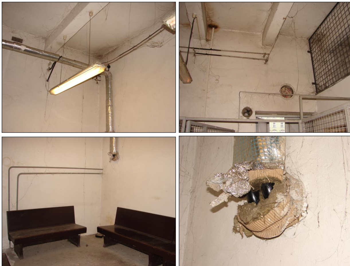
Foto 31 - 34: Místnost C.N1.45, místnost řidičů DP, ŽB strop, zděné stěny, podlaha betonová, ocelové drátěné mříže, ocelová vrata, ocelové potrubí s izolací z minerální vlny obalené kartonem a Al fólií
