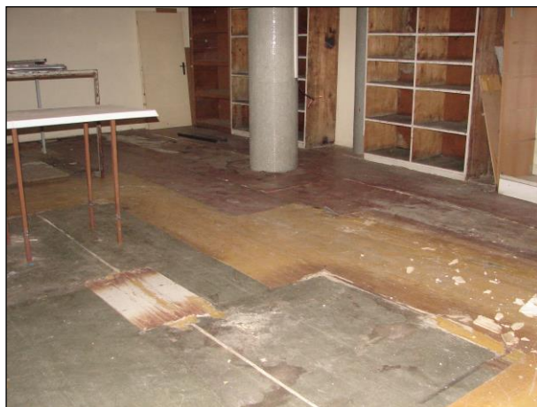
Foto 176 a 177: Místnost C.N1.01, zadní část místnosti, ŽB skelet, výplňové zdivo, kazetový podhled pod stropem, PVC a keramická dlažba na podlaze
