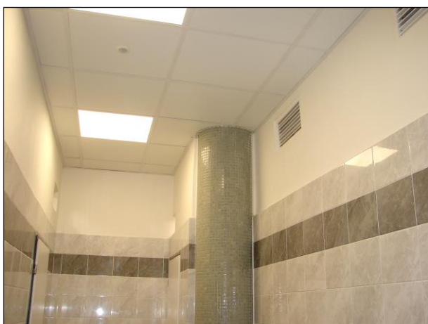
Foto 137 a 138: Místnost C.N1.12, soc. zařízení, ŽB skelet, výplňové zdivo, keramický obklad a keramická dlažba na podlaze
