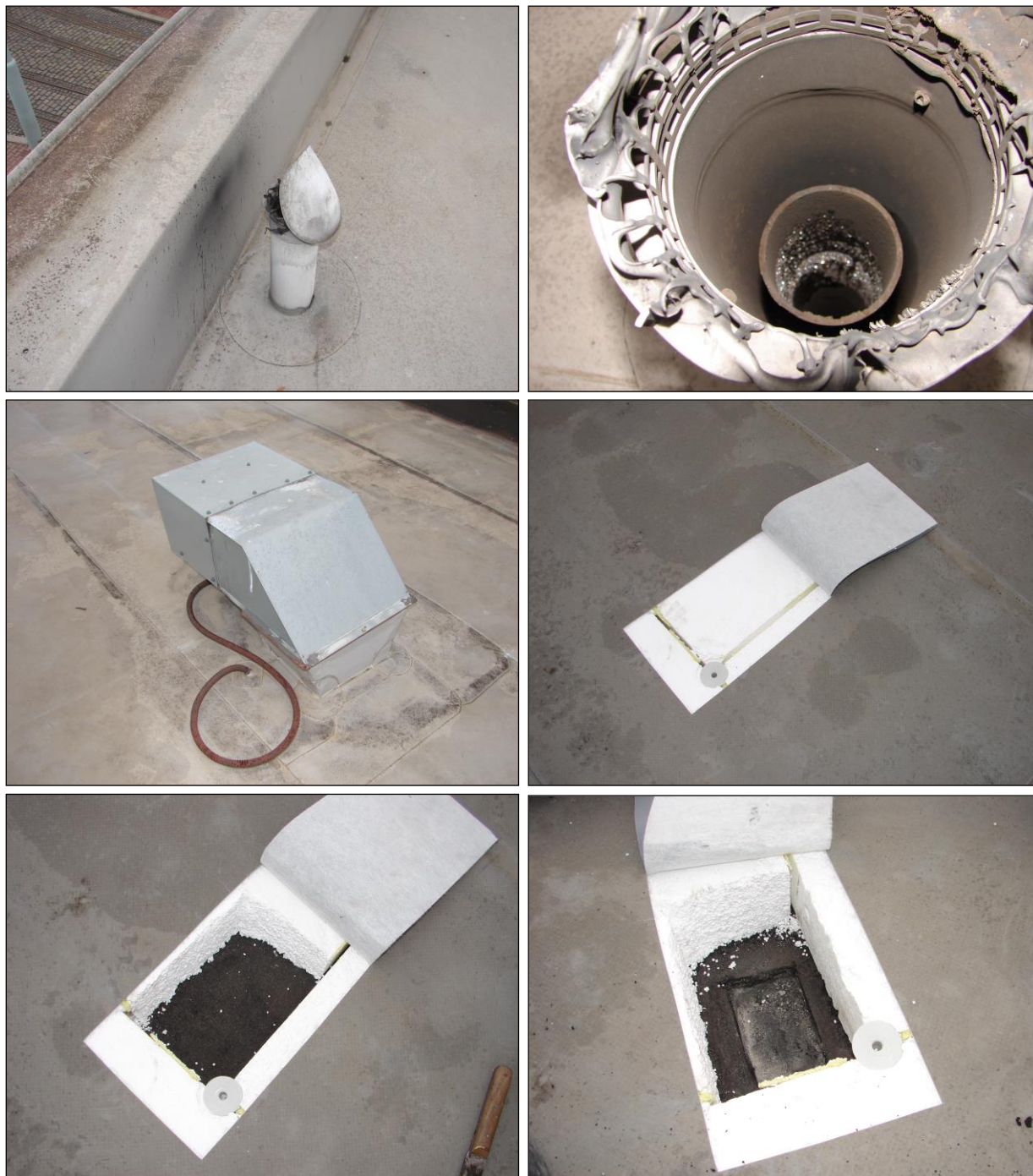
Foto 385 - 390: Střecha, severní křídlo, v plastovém odvětrání kanalizace je litinová roura, vyústění plechového VZT potrubí na střeše, sonda do skladby střešního pláště: hydroizolační PVC fólie, netkaná textilie, pěnový polystyren tl. 100 mm, hydroizolační souvrství (celková tl. souvrství cca 40 mm): 1x hydroizolační asfaltový pás novodobý, 1x hydroizolační asfaltový pás původní, 3x asfaltová lepenka s nátěry litým asfaltem (celková tl. souvrství cca 40 mm), ŽB stropní konstrukce
