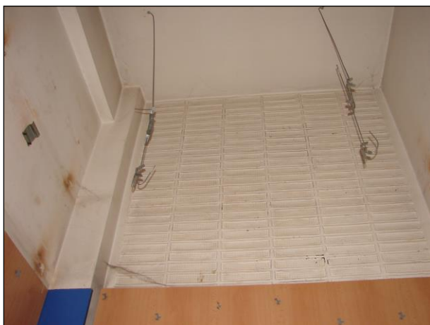
Foto 106 a 107: Místnost C.N1.24, soc. zařízení, ŽB skelet, výplňové zdivo, zamalované luxfery ve stěně, plastové potrubí, obklad z dřevotřískových desek, keramický obklad, keramická dlažba na podlaze
