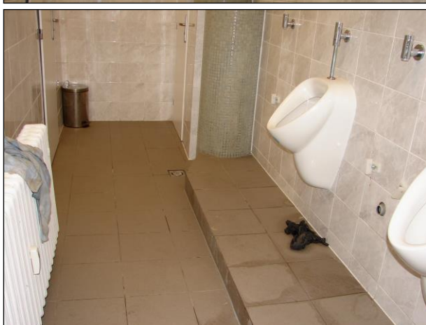
Foto 139 - 142: Místnost C.N1.11, veřejné WC muži, pisoáry a jedna ze dvou kabin (druhá kabina viz další strana), ŽB skelet, výplňové zdivo, keramický obklad a keramická dlažba na podlaze, pod stropem kazetový podhled
