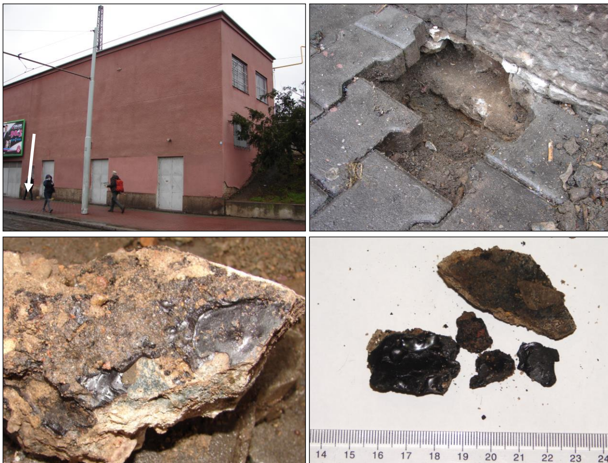
Foto 419 - 422: 1.NP, izolace spodní stavby, místo odběru vzorku, sonda a vzorek, spodní hydroizolace je tvořena litým asfaltem, přítomnost azbestu: negativní - identifikace (B), (C), kap. 5.3
