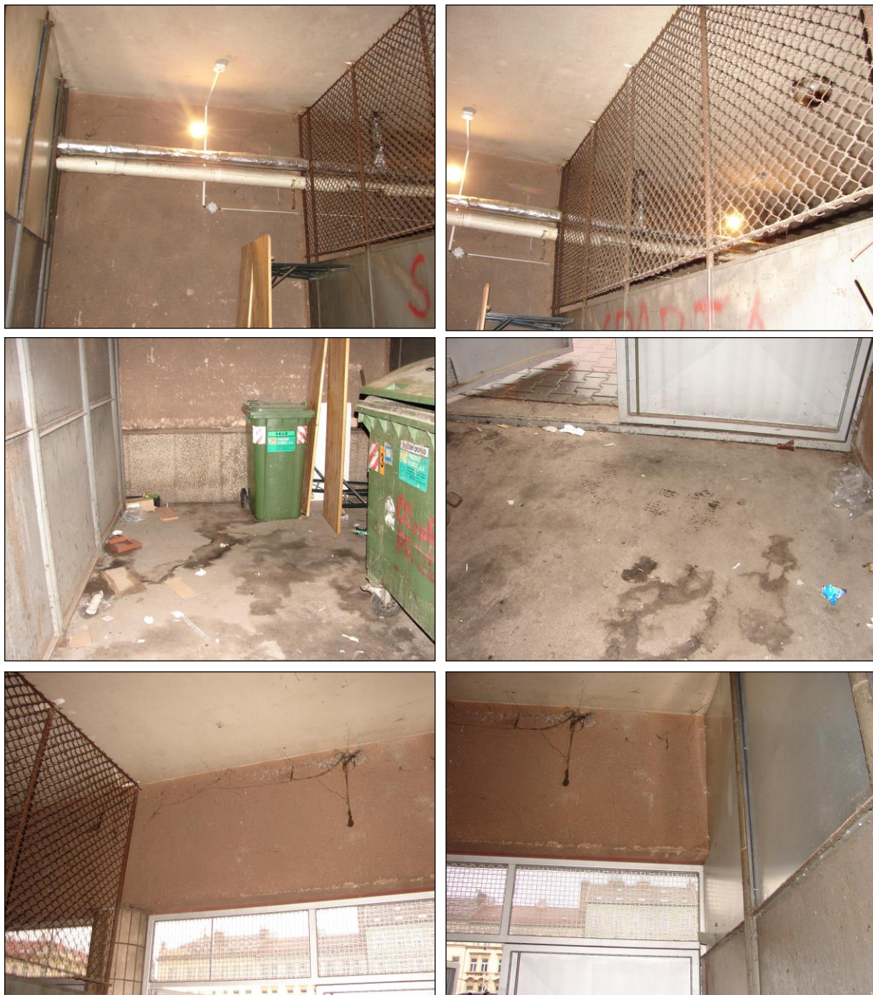
Foto 49 - 54: Místnost C.N1.41, umístěny plastové kontejnery na odpad, ŽB strop, zděné stěny, podlaha betonová, pískovcový sokl, ocelové drátěné mříže a plechová přepážka, ocelová vrata, ocelové potrubí s izolací z minerální vlny obalené kartonem a Al fólií a plastové potrubí izolované polystyrenem
