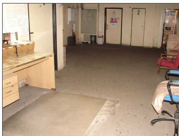
Foto 189 - 192: Místnost B.N1.23A (písmeno A k číslu místnosti přidáno zhotovitelem), ŽB skelet, výplňové zdivo, betonová podlaha, příčka z plechu, ocelové potrubí s izolací z minerální vlny obalené kartonem a Al fólií
