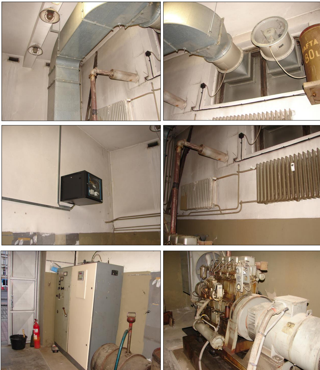
Foto 19 - 24: Místnost C.N1.47, diesel agregát, ŽB strop, zděné stěny, podlaha betonová, plechové VZT potrubí, ocelová vrata, el. rozvody v kovových skříních
