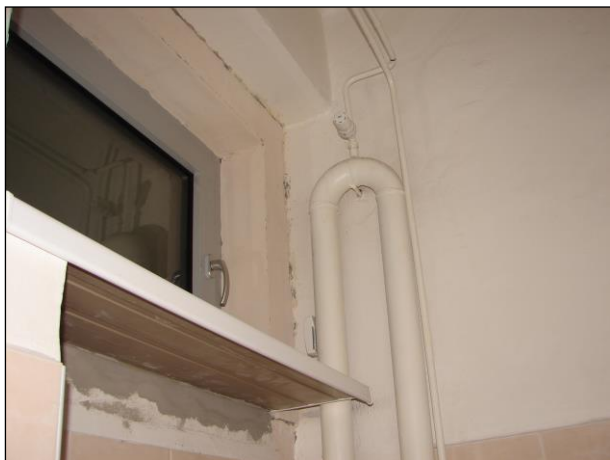
Foto 336 a 337: Místnost C.N2.06, WC, ŽB skelet, výplňové zdivo, keramický obklad, ocelové potrubí, litinová roura u podlahy, hliníkové okno, na podlaze keramická dlažba
