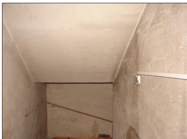
Foto 161 a 162: Místnost C.N1.05, místnost pod schodištěm do 2.NP, ŽB skelet, zděné stěny ŽB schodišťové rameno, betonová podlaha
