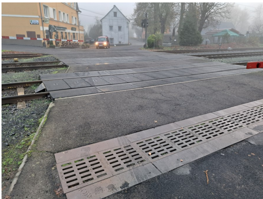
Obr. č. 1 – přejezd km 163,941 (P77)
