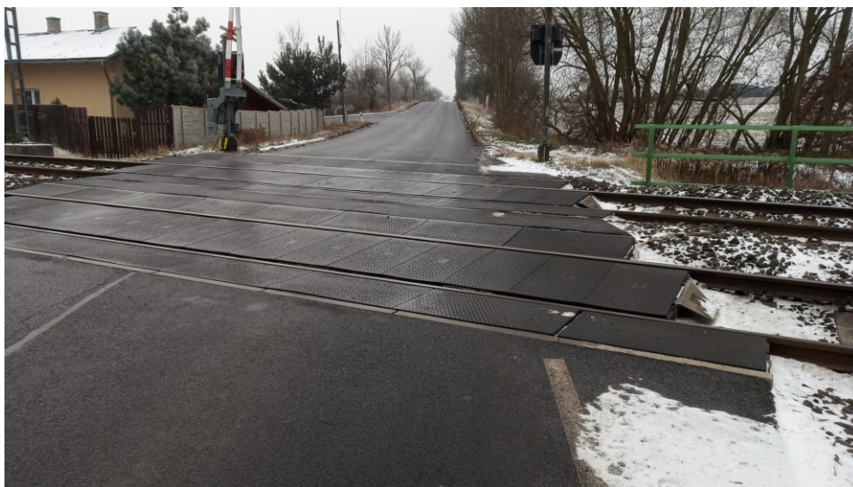
Obr. č. 7 – přejezd km 176,260 (P79)
