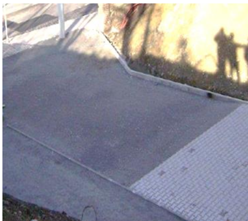
Obr. 1 - Dočasné zřízení komunikace - stanovený výškový rozdíl maximálně 20 mm (zámková dlažba, asfaltový, atd.)
