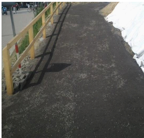
Obr. 3 - Hutněný nezpevněný povrch z recyklátu
