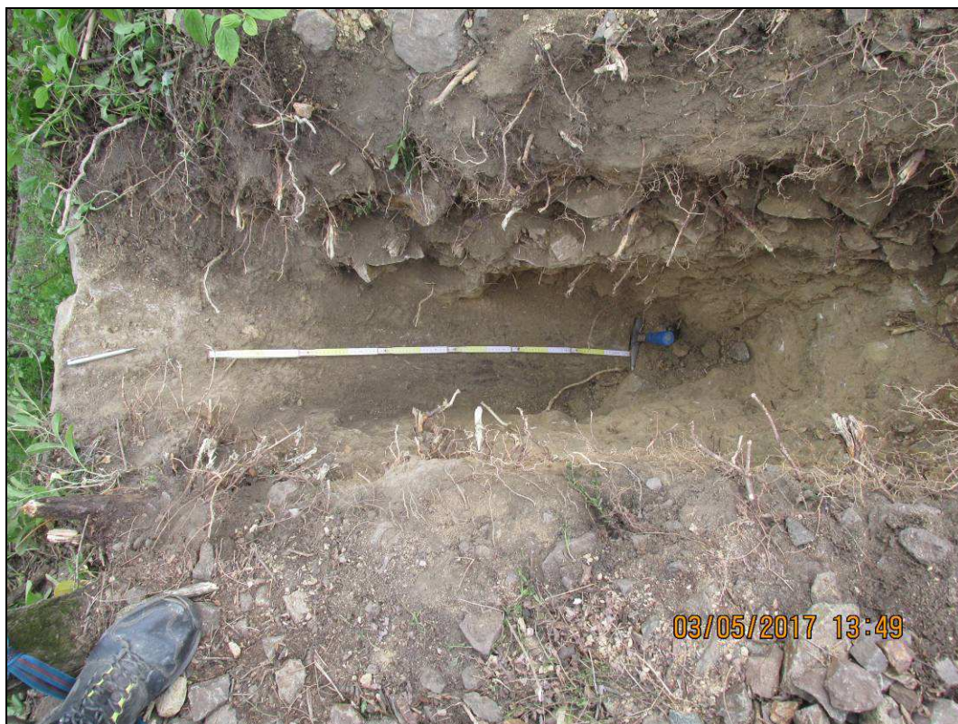
Obr. č. 7 - kopaná sonda pro ověření tvaru koruny opěrné zdi
