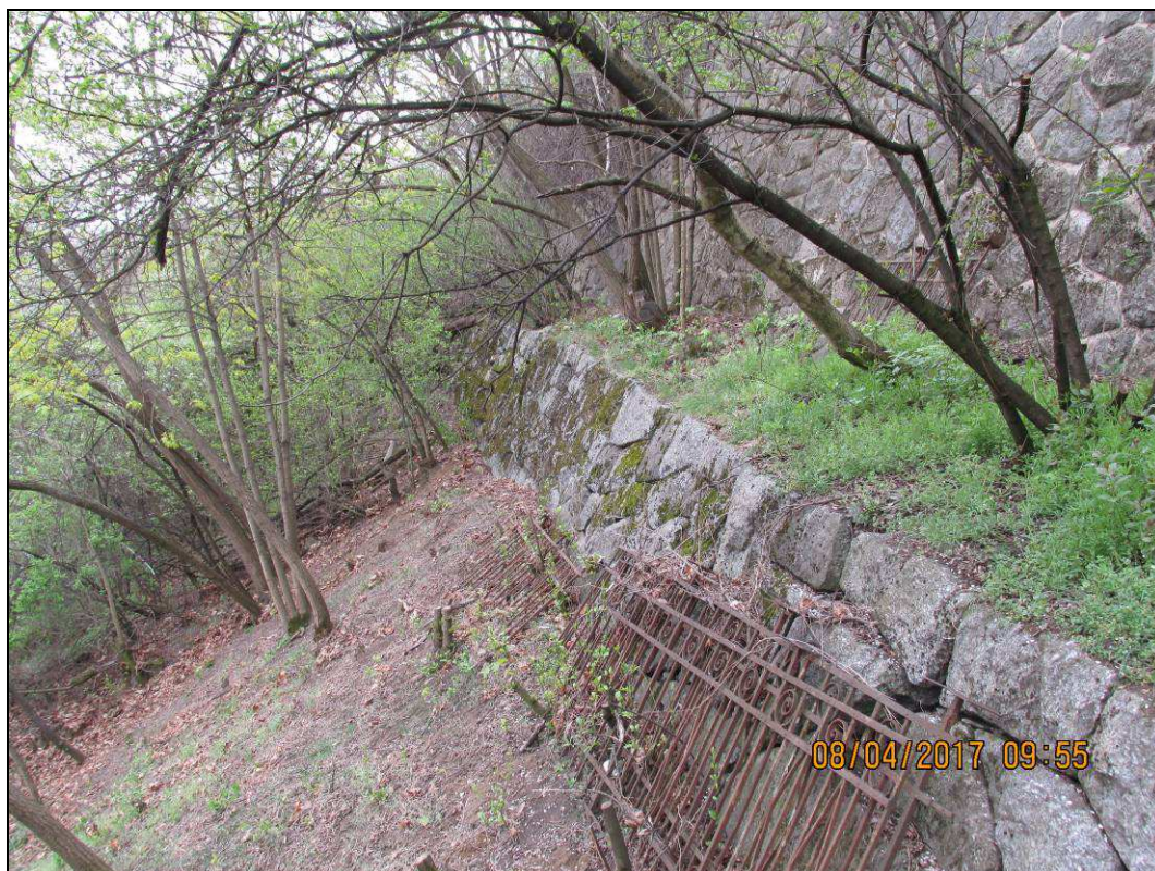
Obr. č. 6 - kamenná rovinanina pod opěrnou zdí
