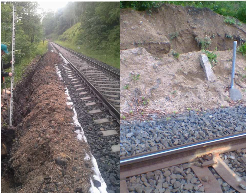
Obrázek 47 Další ukázka vedení výkopu přímo polohou geodetického bodu
