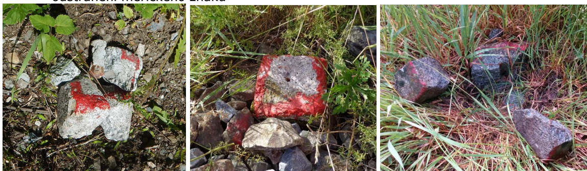
Obrázek 8 Ukázka zničených bodů sekáním trávy
