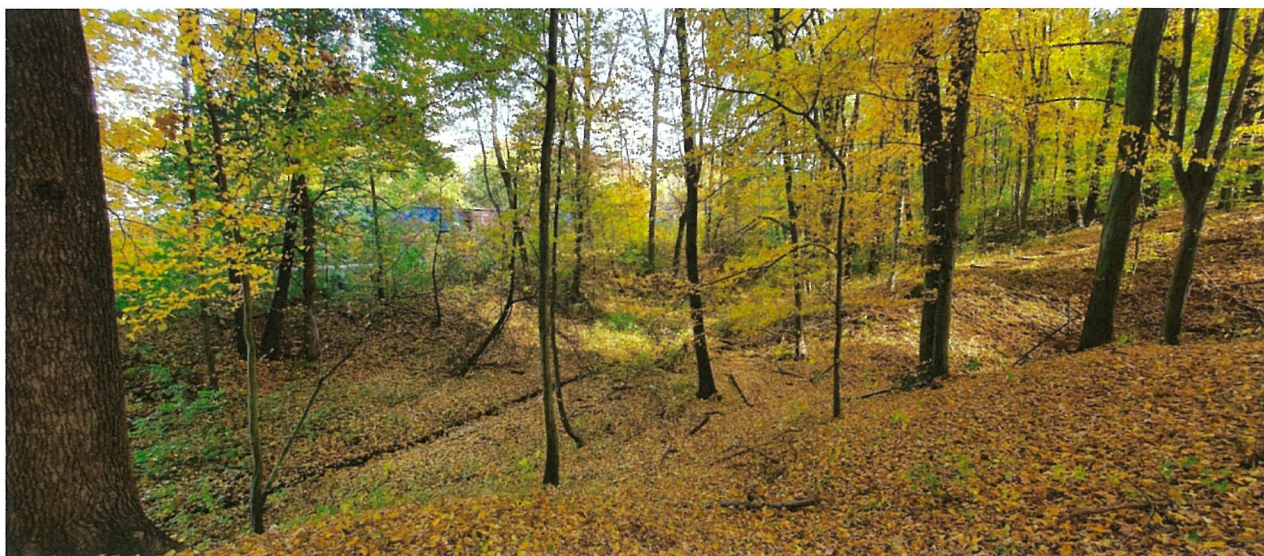
Obrázek 4 Zvlněný svah a odvodňovací rýha v jižním předpolí trati v km 37,070
