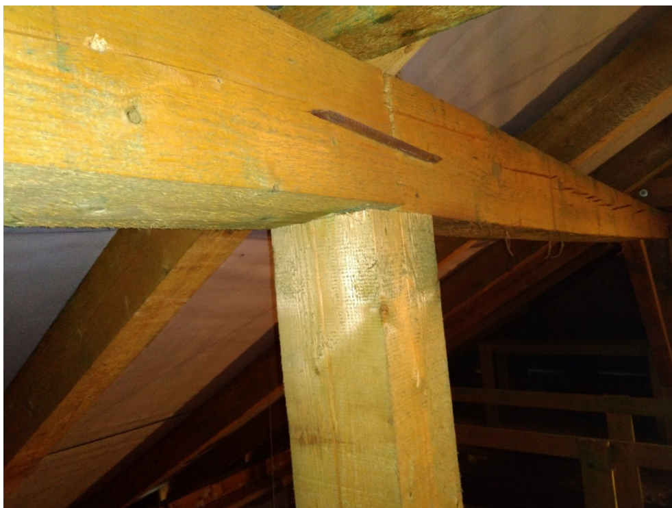
Uložení vaznice na sloupek bez zpevňujících pásků
