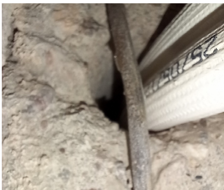
Sonda V2 – detail smykové výztuže
