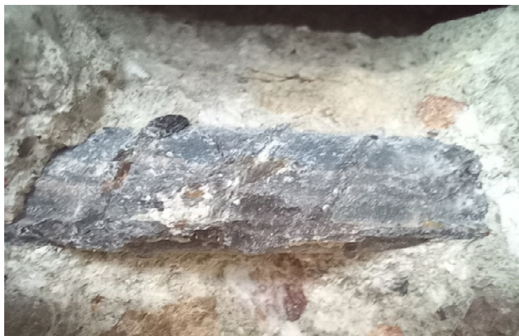
Sonda V1 – detail podélné výztuže
