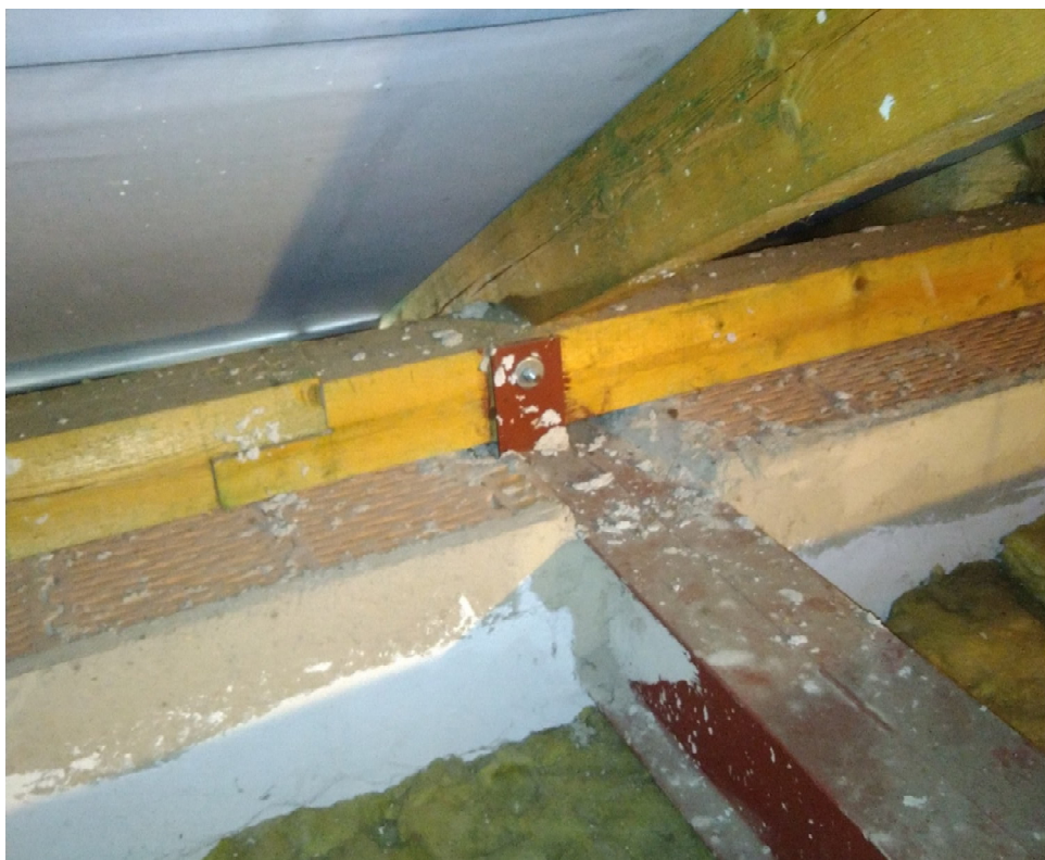
Spoj pozednice s ocelovým vazným trámem
