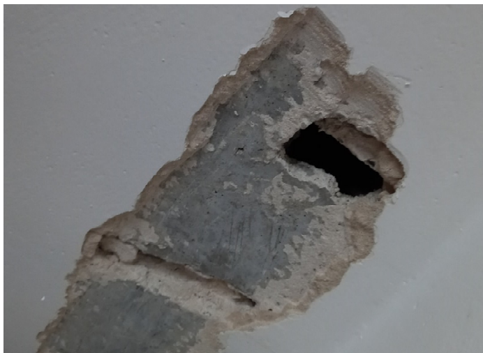
Sonda V1 – stropní panel
