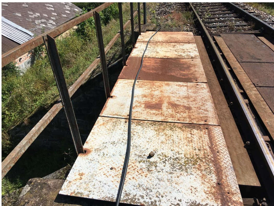
Kabel Telematiky na mostě
