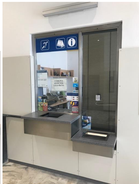
Obrázek 5.1.1, 5.1.3 – Příklad odkládací plochy - pultu/parapetu, pokladního okna
