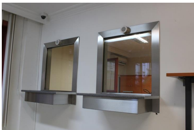
Obrázek 5.1.1, 5.1.3 – Příklad odkládací plochy - pultu/parapetu, pokladního okna
