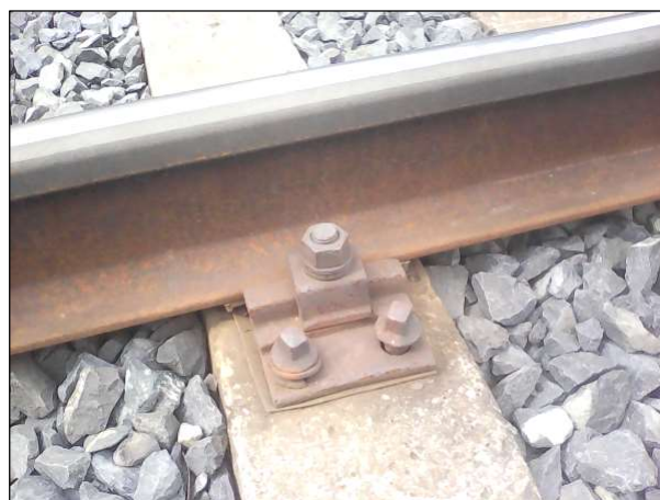
Detail železničního svršku, stará kolej (R 65)
