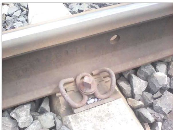
Detail železničního svršku, nová kolej (60 E1)
