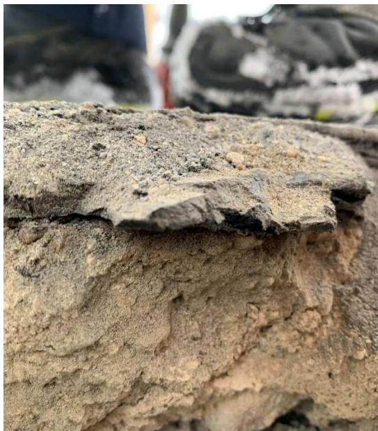
obr. 9 Sonda 3 – hydroizolace + betonová mazanina
