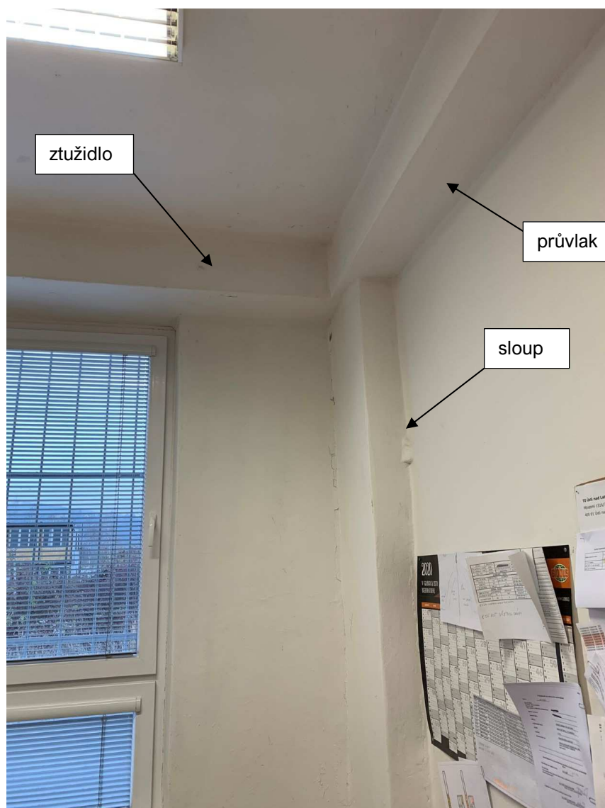
obr. 7 Sloup, průvlak a ztužidlo systému S1.2 ve zkoumané budově
