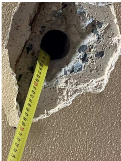
obr. 15 Tloušťka střechy 550 mm
