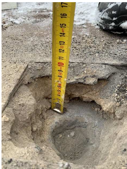
obr. 12 Tloušťka betonové mazaniny v sondě 3 – 90 mm
