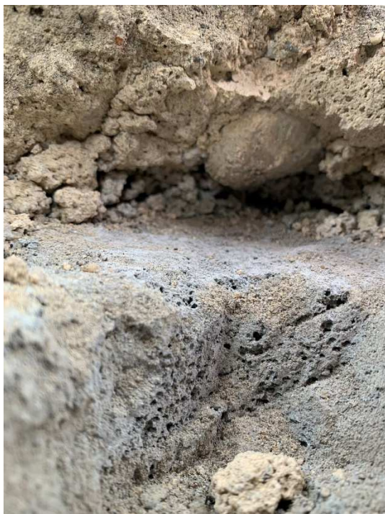
obr. 10 Vrstva šedého plynosilikátu pod betonovou mazaninou
