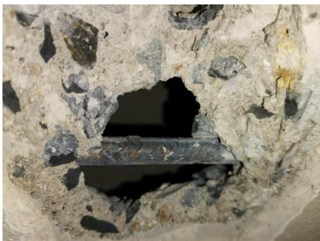
obr. 14 Detail žebírkové nosné výztuže \varnothing 12 mm stropního panelu P1
