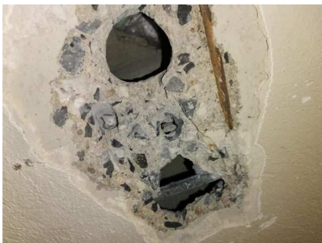
obr. 13 Sonda 1 zespod stropní konstrukce
