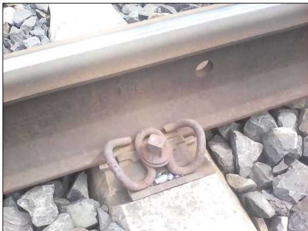
Detail železničního svršku, nová kolej (60 E1)
