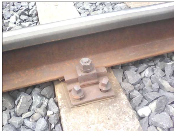
Detail železničního svršku, stará kolej (R 65)
